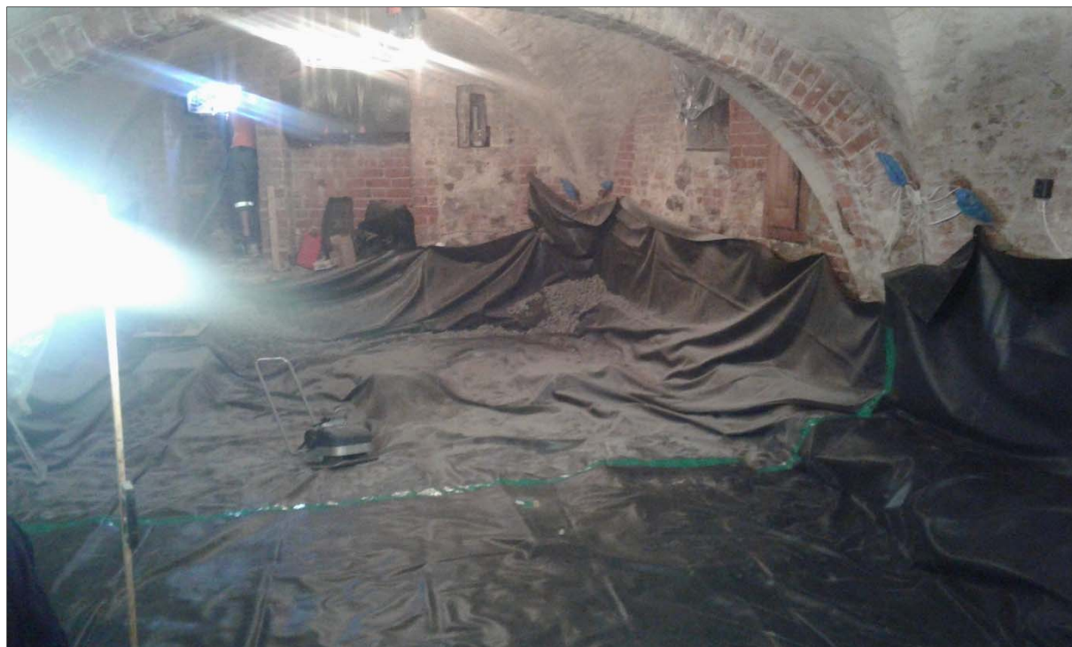
Figur 10. En tjock gummimatta lades ut ovan schaktbotten för att förhindra fortsatt uttorkning och förhoppningsvis minska risken för återkommande sättningsskador. Ovan gummiduken tillkom glasgranulat och sedan en gjuten betongplatta. Fotografi från väster.
