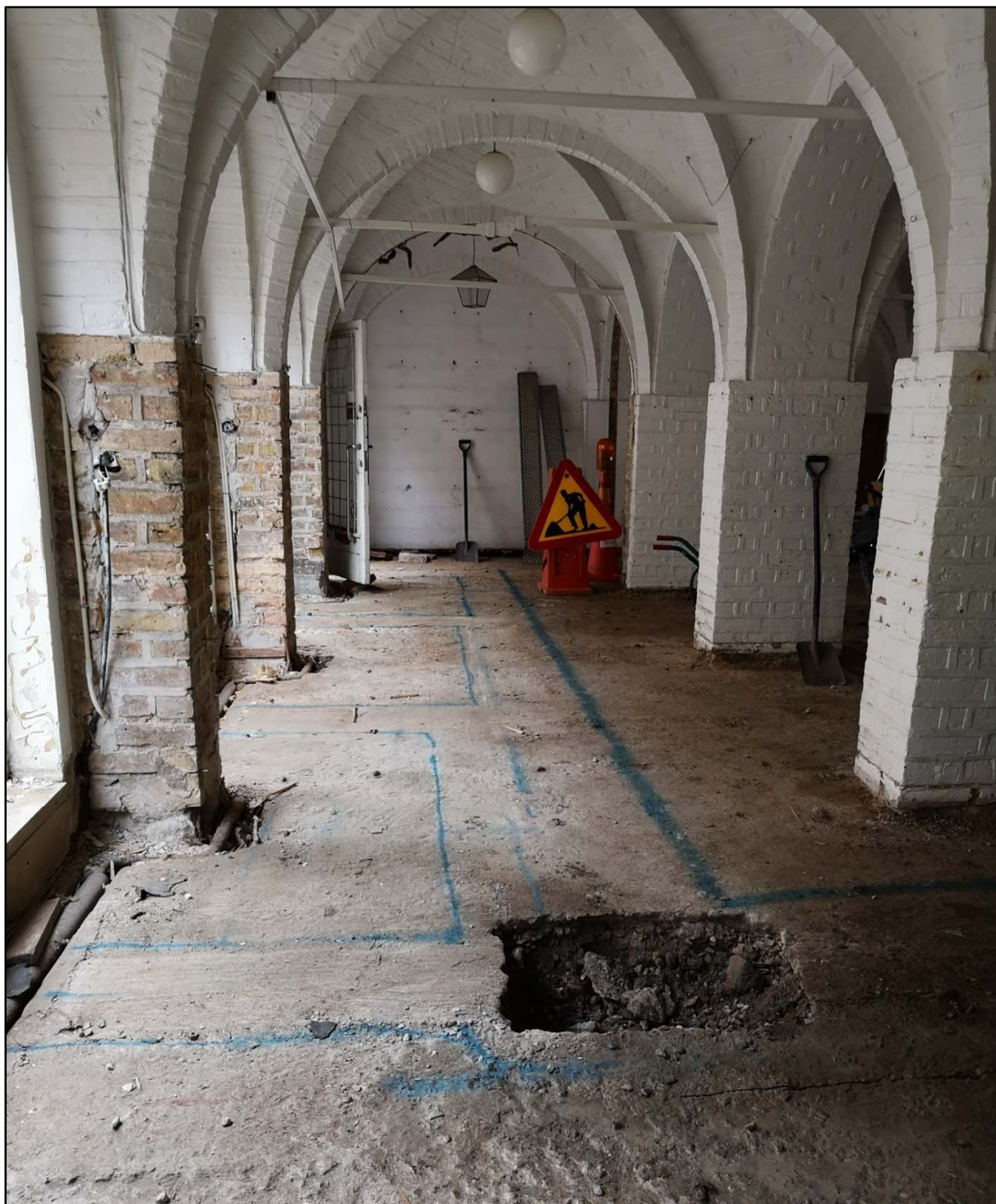
Figur 6. Status då schaktningsarbetena upptäcktes. Markeringar för ledningsdragningar fanns i rummet mot Stora Södergatan. Under golv och bärlager fanns intakta kulturlager kvar med datering 16–1700-tal. Fotografiet taget från norr.
