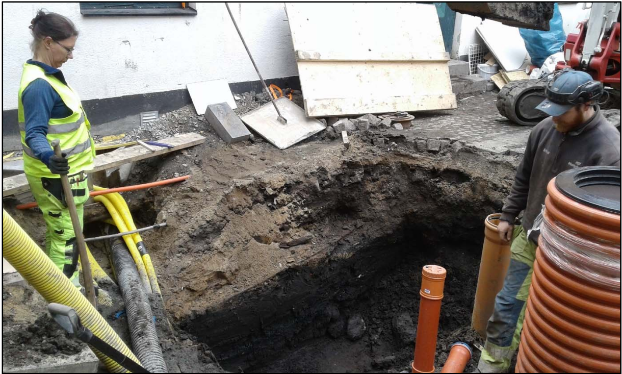
Figur 11. Schaktning för ny fettavskiljare, Schakt 3. Fotografiet taget från norr.
