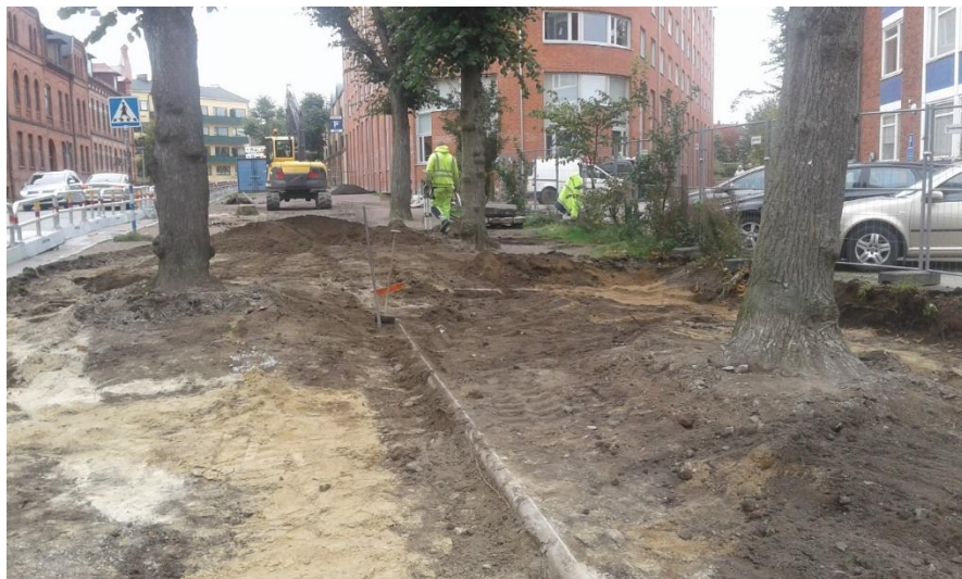
Figur 8. Arbetsytan, steg 2, sett från väster.
