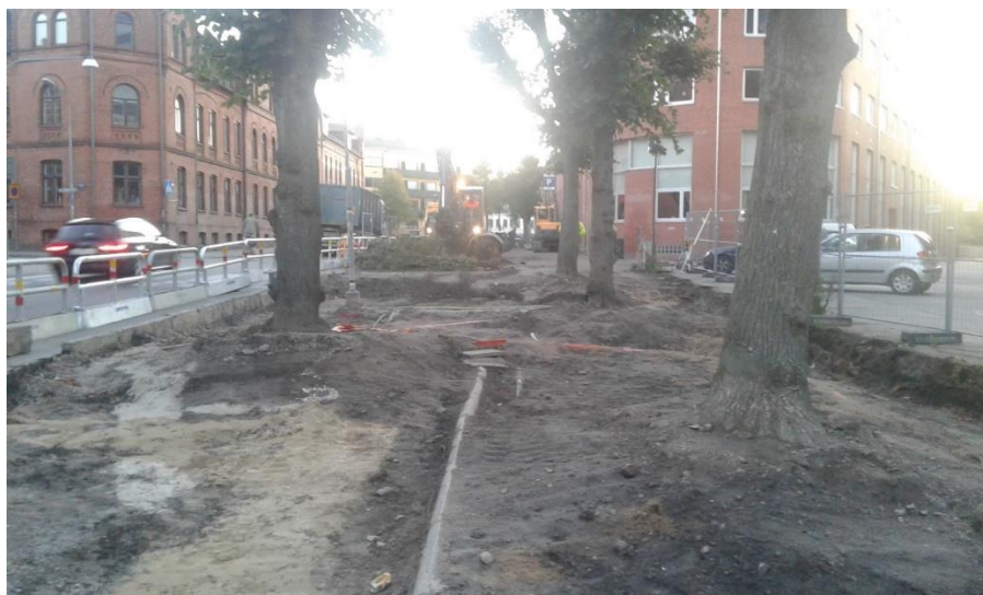
Figur 7. Vy över arbetsytan, steg 2, sett från väster.
