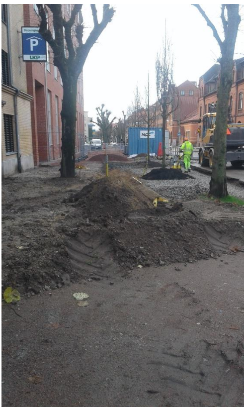
Figur 11. Återställning av arbetsytan.
