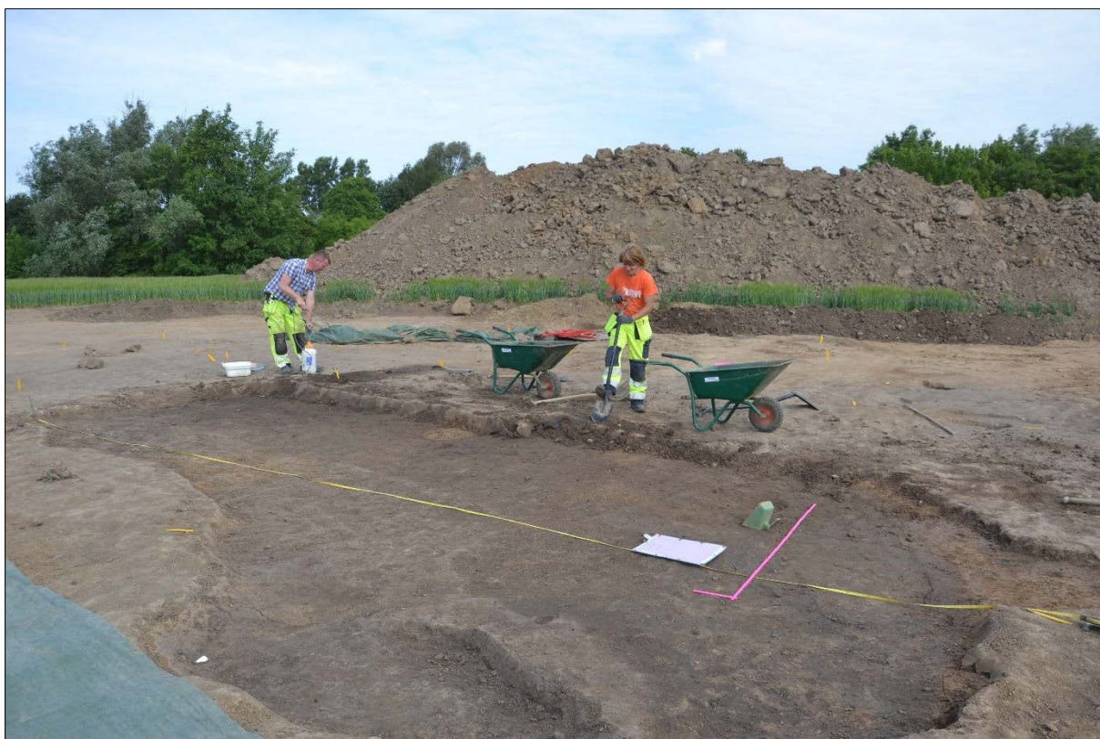
Figur 5. Johan Wallin och Anna Lagergren har påbörjat undersökningen av det stora mörka området som framkom vid avbaningen av matjorden. Den stora nedgrävningen visade sig bestå av flera fyllningar. Fotografiet taget från sydöst.
