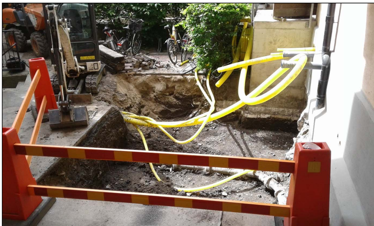
Figur 3. Schakt 2 sett från öster.
