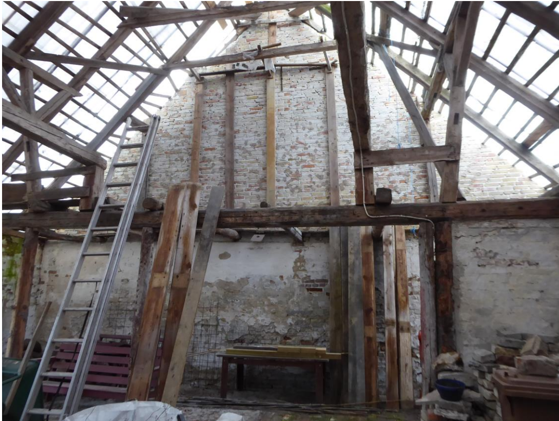
Före åtgärder. Norra delen. April 2019.
