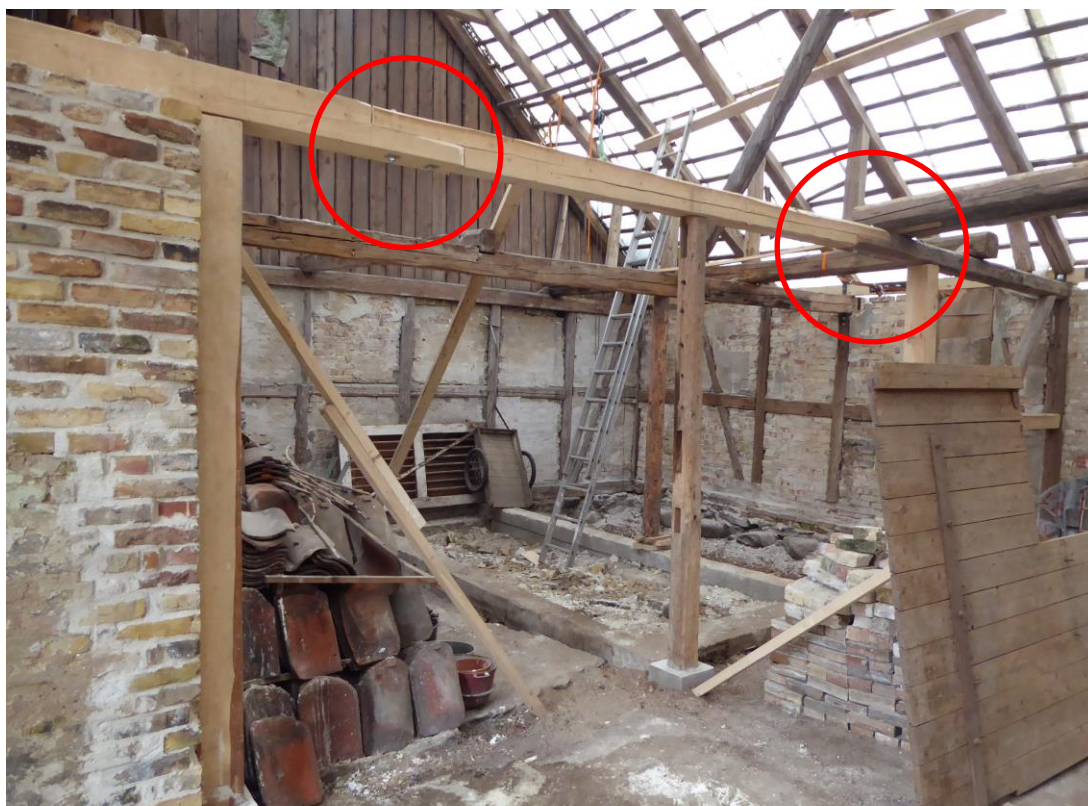
Efter åtgärder. Södra delen. Bjälken skarvades halvt i halvt och sattes med bultar. Skarvar markerat med röda ringar på fotografiet. April 2020.
