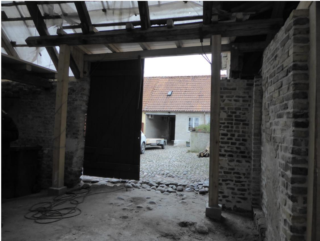
Efter åtgärder. Innervägg till höger i bild samt tak ovan port är det aktuella. April 2020.
