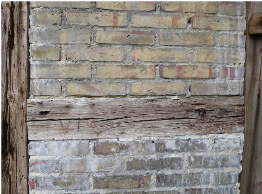
April 2019. Synliga hantverksmärken på löshult vid korsvirkesfasaden (västra fasaden).
