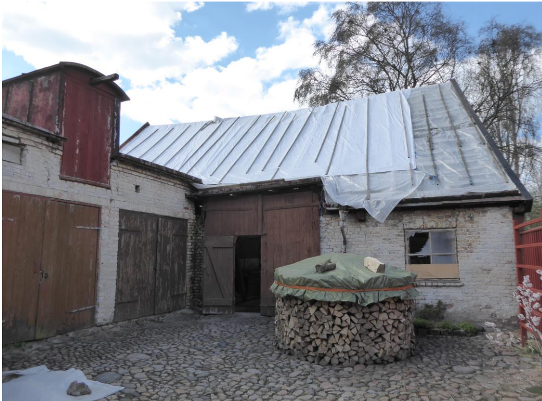
Före åtgärder. Östra fasaden. April 2019
