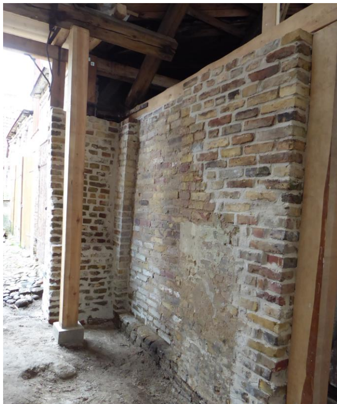
Efter åtgärder. Tegelvägg och innervägg. April 2020
