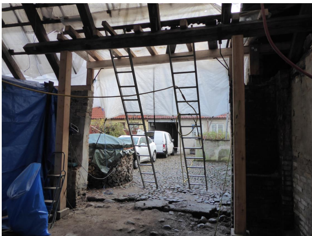
Under arbetets gång. Nytt tak ovan port. November 2019.
