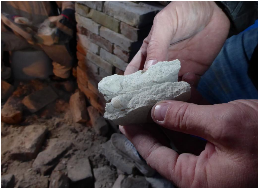
Under arbetets gång. Under nedmontering av östra hörnet på norra fasaden noterades äldre murbruk utan ballast med hela snäckor i. November 2019
