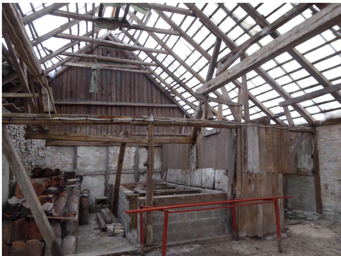
Före åtgärder. Södra delen. April 2019.
