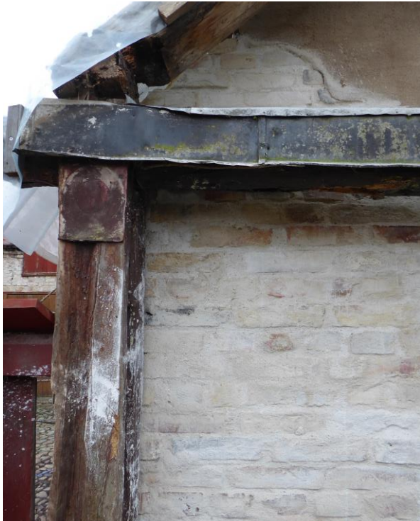
Efter åtgärder. Detaljbild på östra hörnet av norra fasaden. April 2020.
