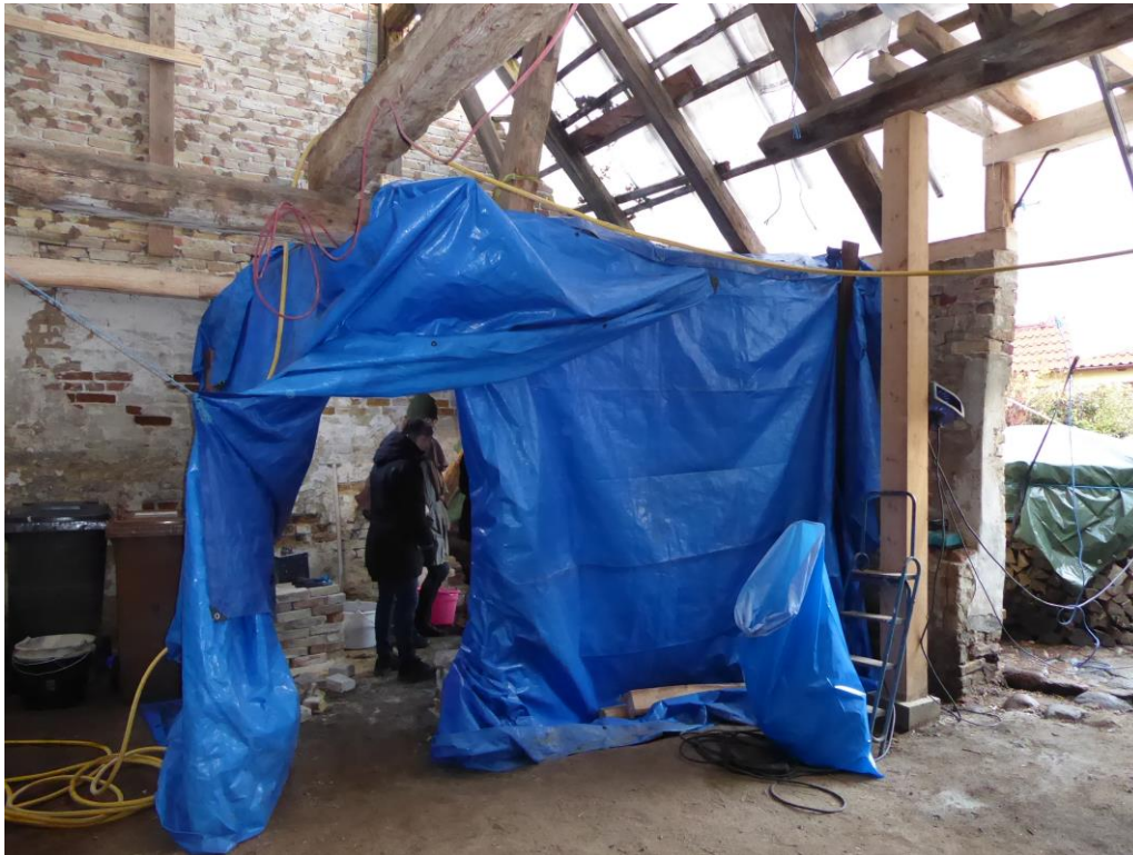
Under åtgärder. Under murning av östra hörnet på norra fasaden. November 2019
