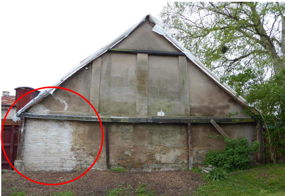
Efter åtgärder. April 2020.
