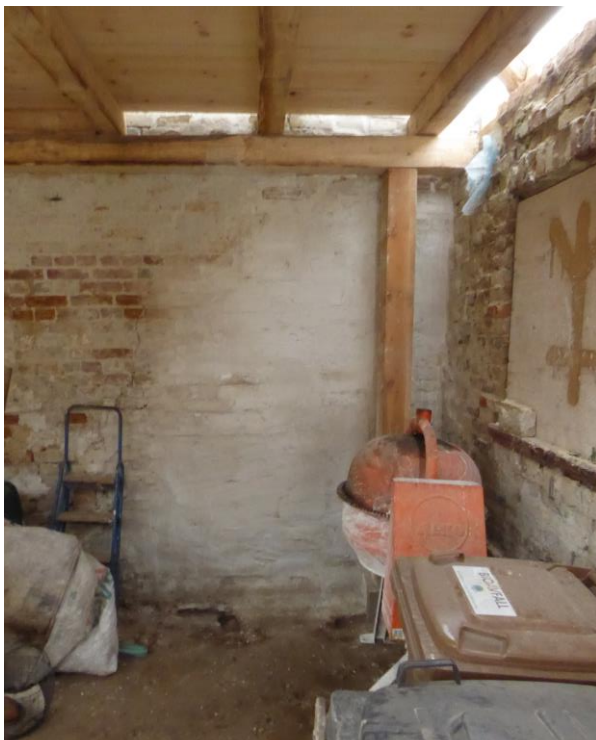
Efter åtgärder. Östra hörnet av norra fasaden sett från insidan. April 2020.
