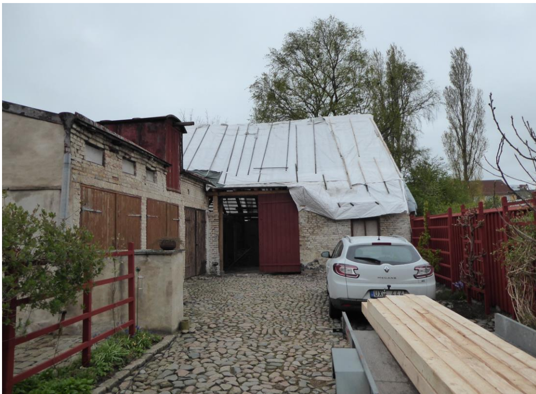
Efter åtgärder. Östra fasaden. Det vänstra portbladet är ännu inte återmonterat. April 2020
