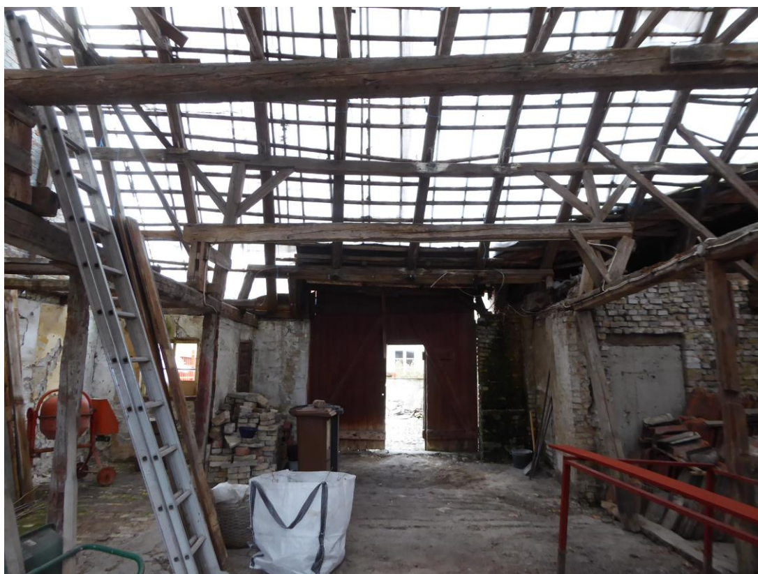
Före åtgärder. Väggbartier till höger i bild samt tak ovan port är det aktuella. April 2019.
