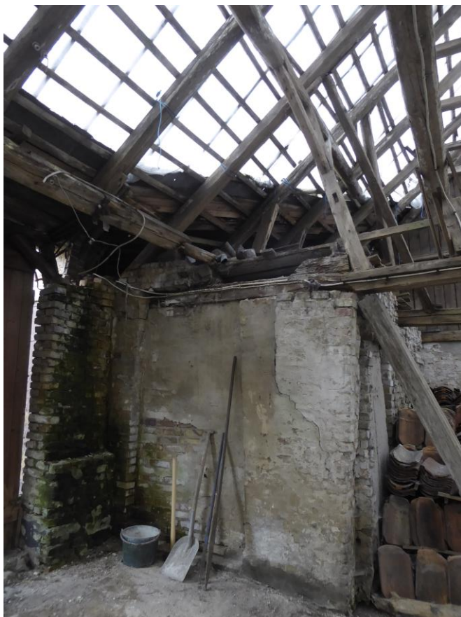
Före åtgärder. Tegelvägg och innervägg. April 2019
