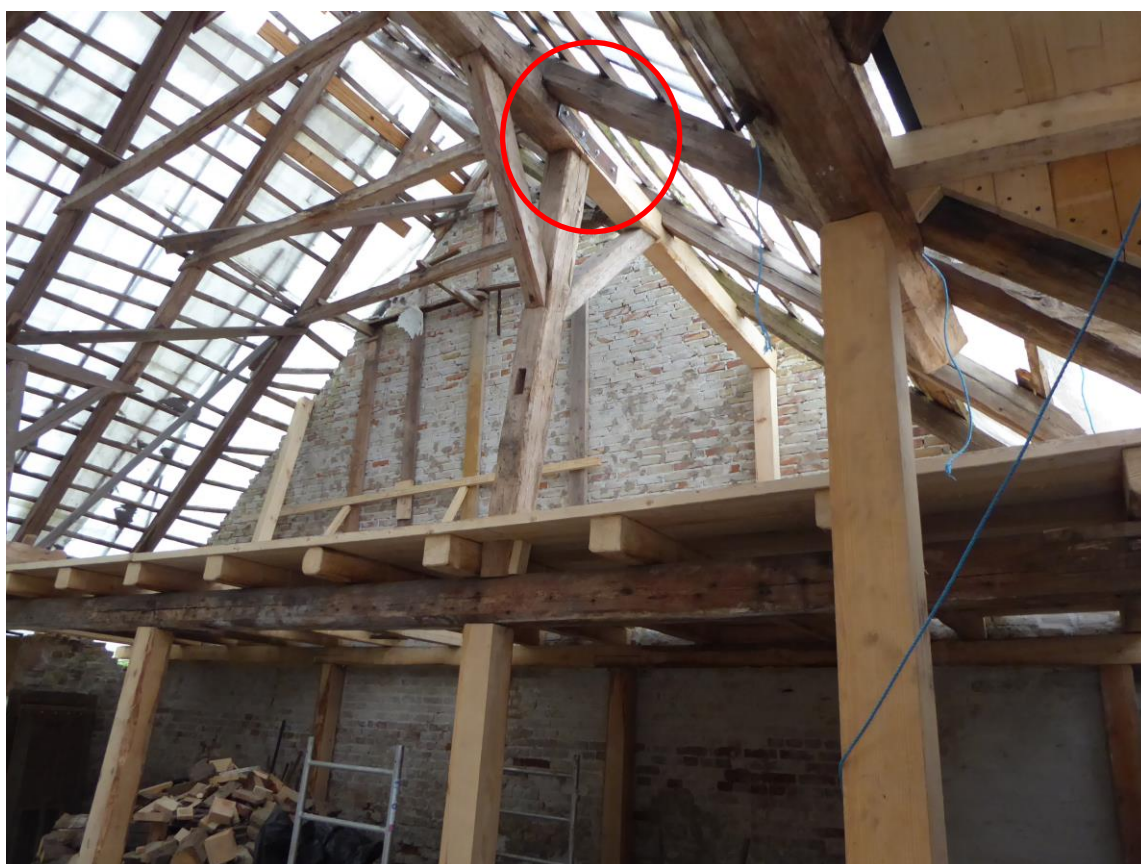
Efter åtgärder. Norra delen. Stålbreslag markerat med röd ring. April 2020.
