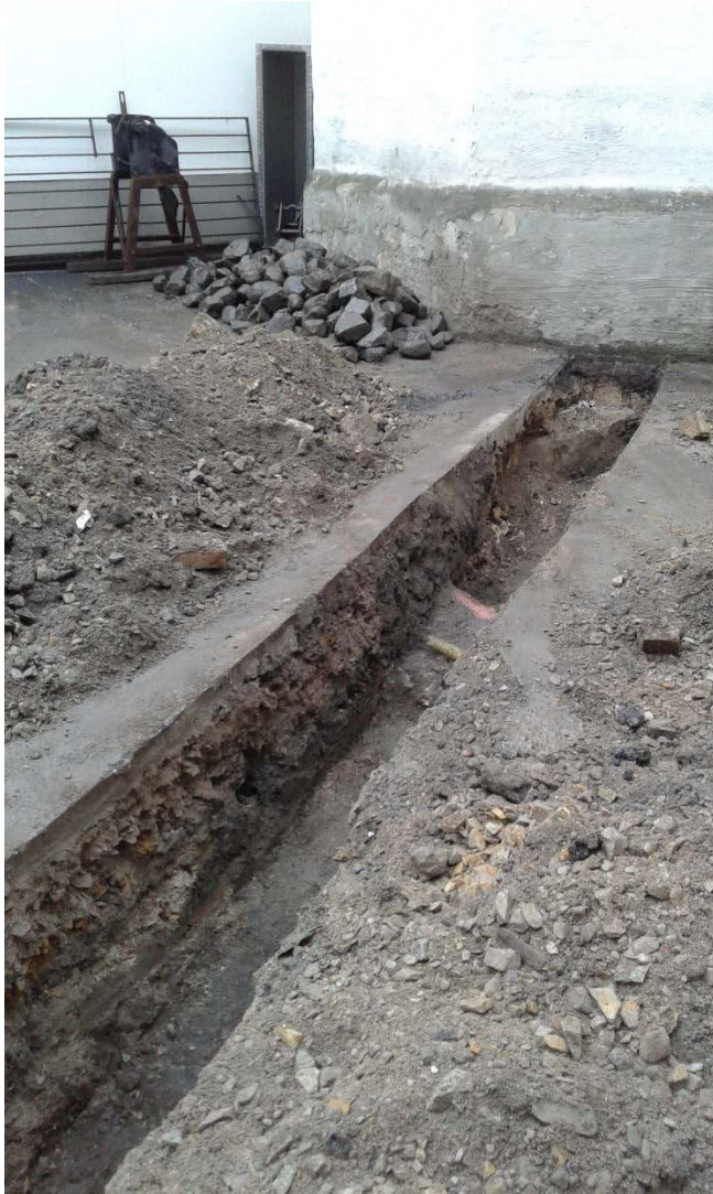
Figur 4. Bild över schaktet i nordöstlig riktning, draget fram till fastigheten ut mot Stora Gråbrödersgatan. Sett från sydväst.
