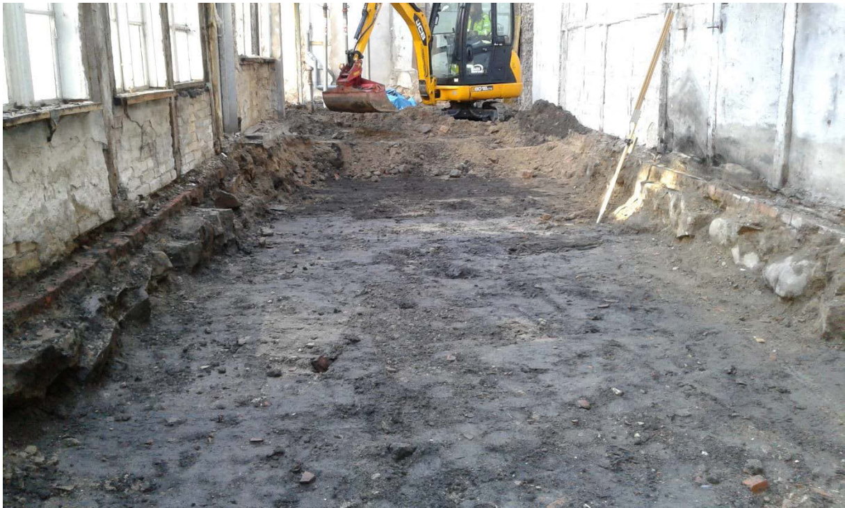
Figur 3. Bild från inne i gårdshuset när det schaktas för sänkning av golv. Sett från väster.
