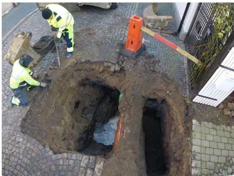
Figur 15. Översikt över schaktet. Foto taget från väster.
