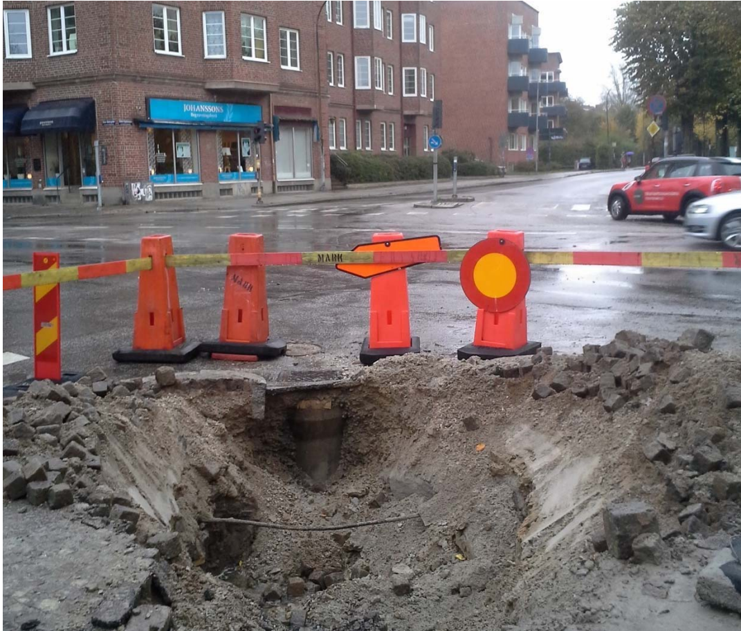
Figur 6. Schakt 2 vid korsningen Stora Södergatan/Södra Esplanaden. Fotot taget från sydväst.
