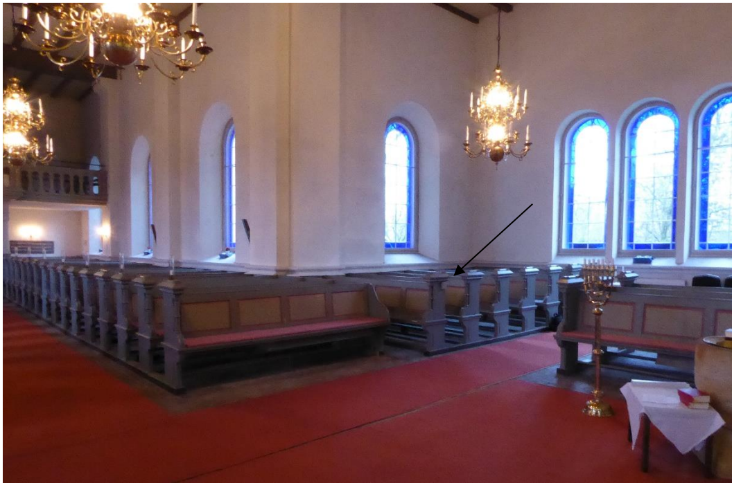
Efter åtgärd, ny givare på bänkgavel markerad med pil.
