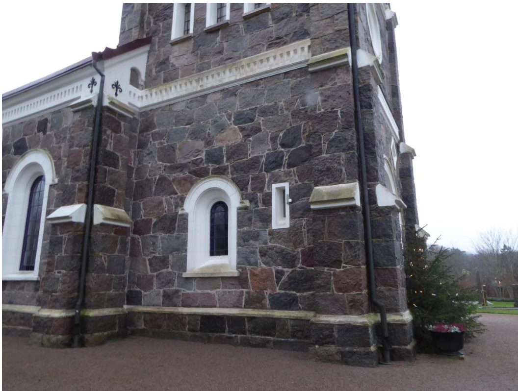
Västtornets norra fasad efter åtgärder.
