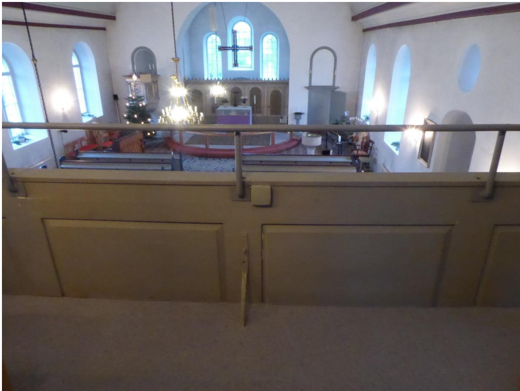
Läktarbarriären med ny inmålad givare på samma plats som den tidigare. Ingen kabeldragning är utförd.
