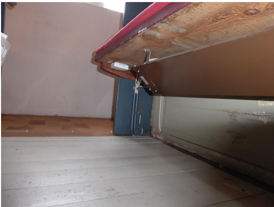
Läktarbarriären med ny inmålad givare på samma plats som den tidigare. Ingen kabeldragning är utförd.
