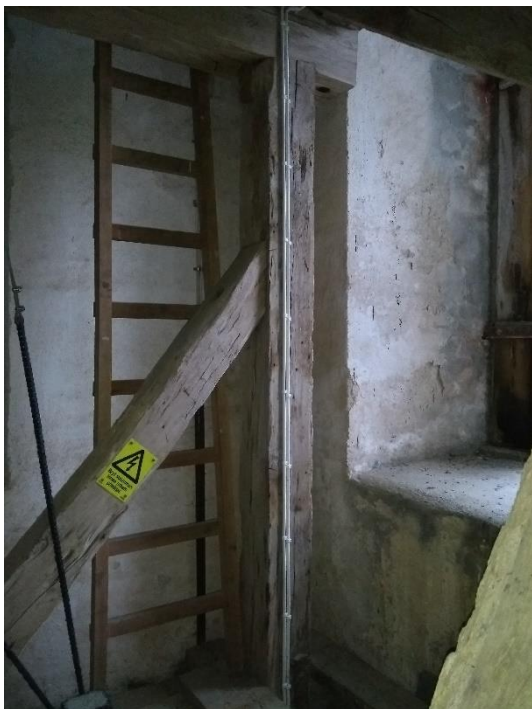
Kabel för klockringning har följt befintlig kabeldragning på vinden.
