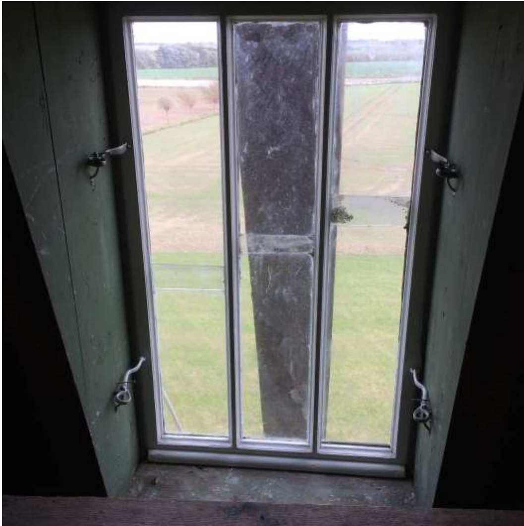
Renoverat Fönster III II med skarvade glas och delvis återanvända beslag. Övre beslag som var moderna vred har bytts mot Stormhaspe 5067 från Eskilstuna Kulturbeslag.
