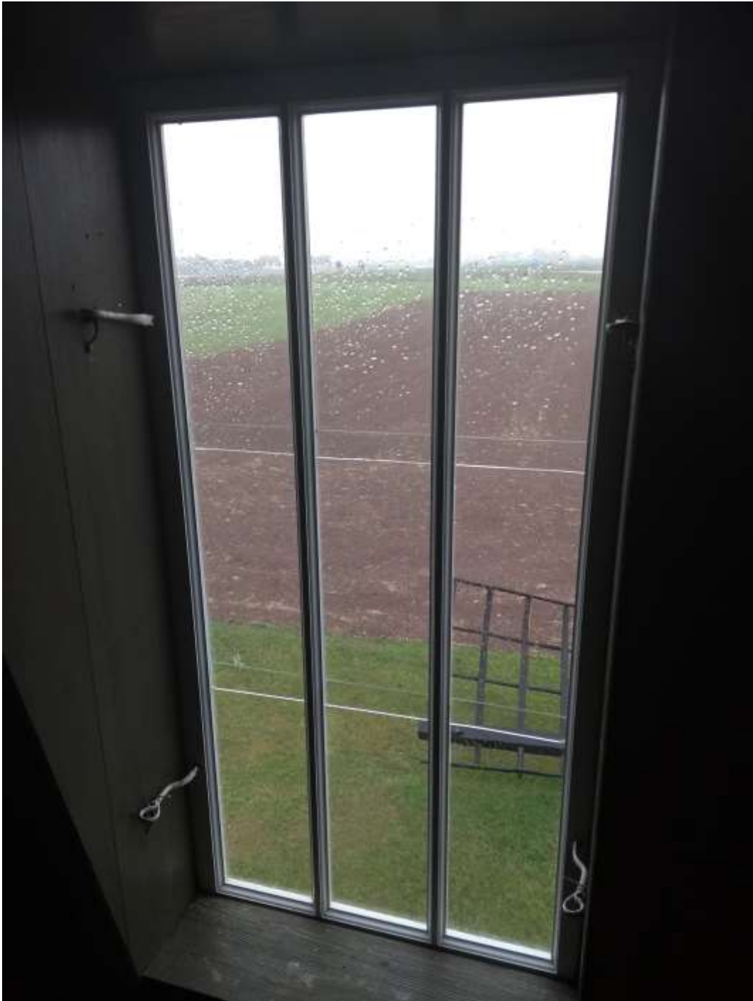
Nyttillverkat Fönster III från insidan.
