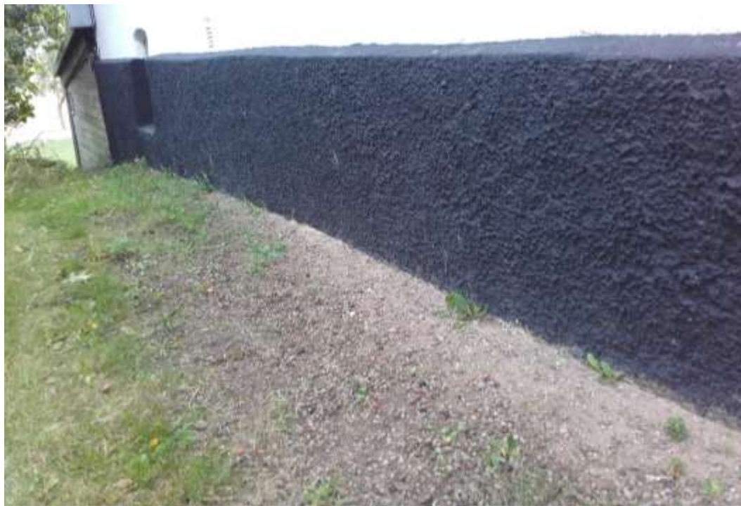
Västra sidan med relativt nyligen pålagd cementhaltig puts. Endast östra sidan, mellan entrétrapporna, har putsas om i den här etappen.
