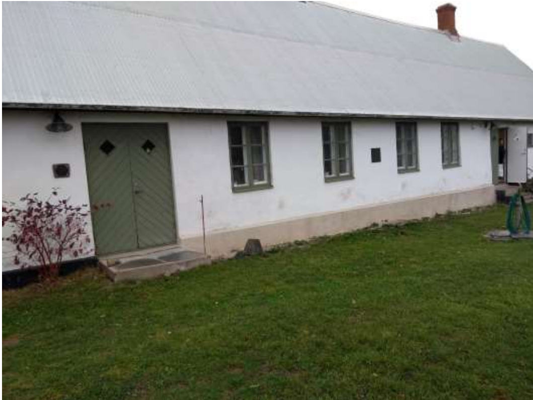
Omfattningen östra långsidan mellan trapporna som putsats om i denna etapp.
