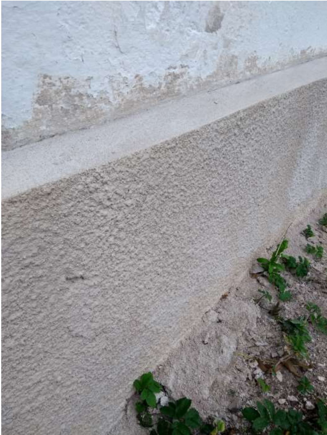
Sockeln efter utstockning, slätputs och ytputs (3 mm).
