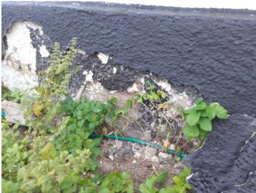
Östra långsidans sockel före åtgärder. Äldre putslager och grundstenarna synliga.
