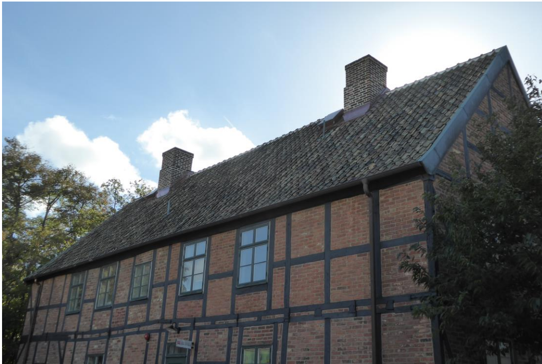
Efter åtgärder. Norra takfallet.
