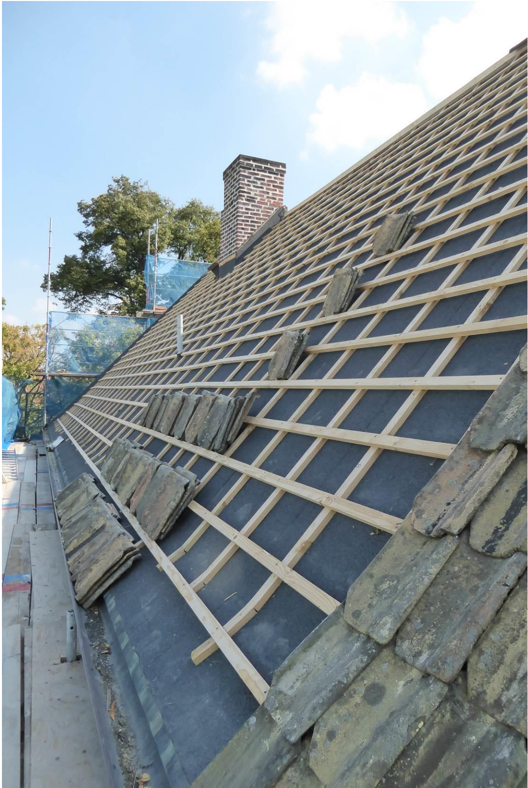
Under arbete, norra takfallet.
