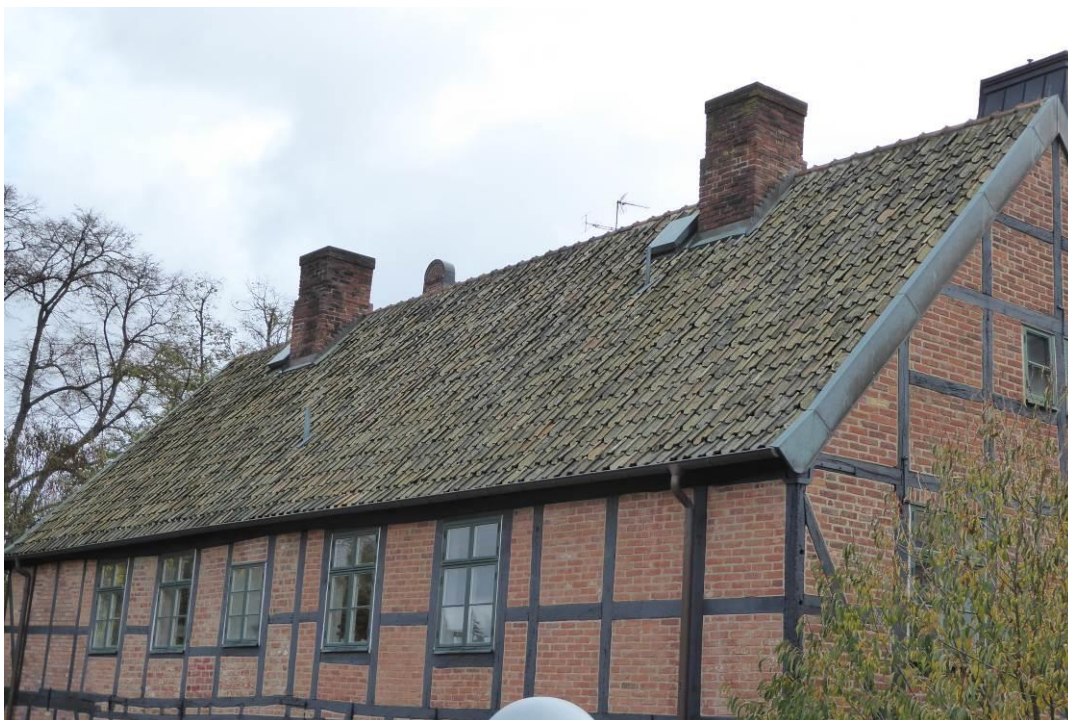
Före åtgärder norra takfallet.
