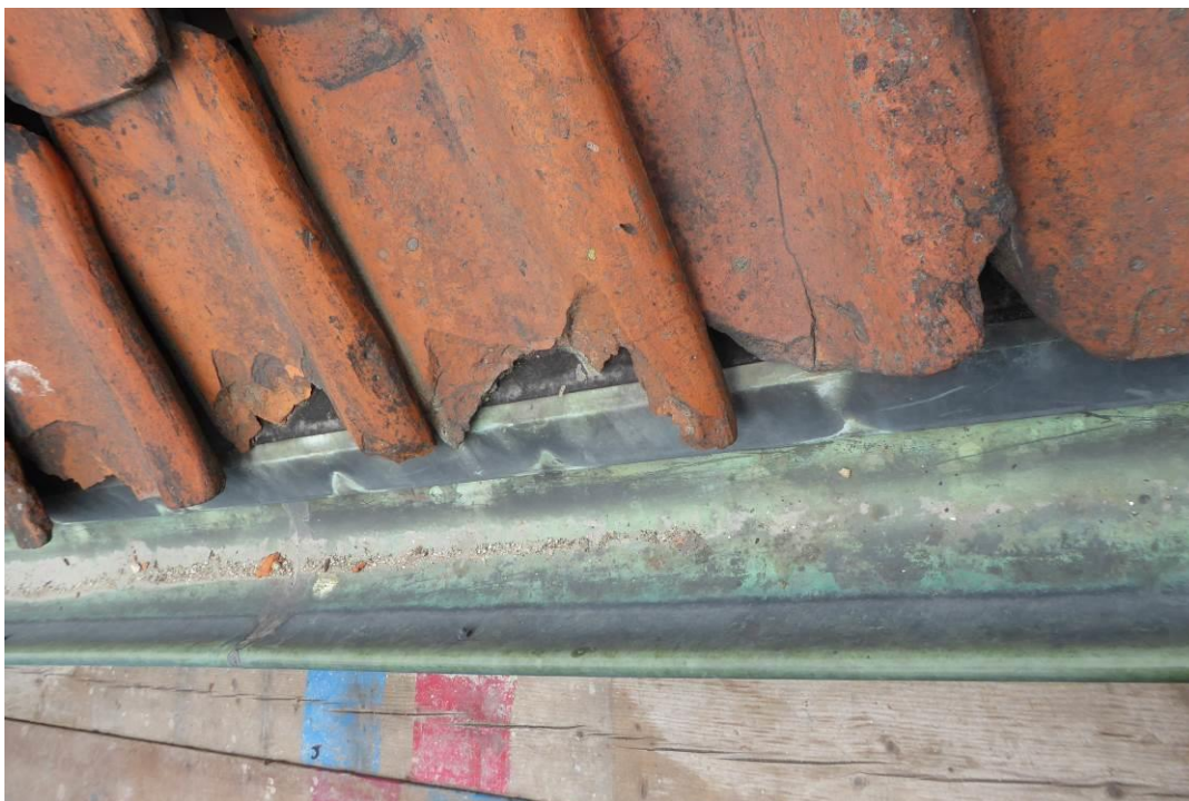
Före åtgärder södra takfallet.
