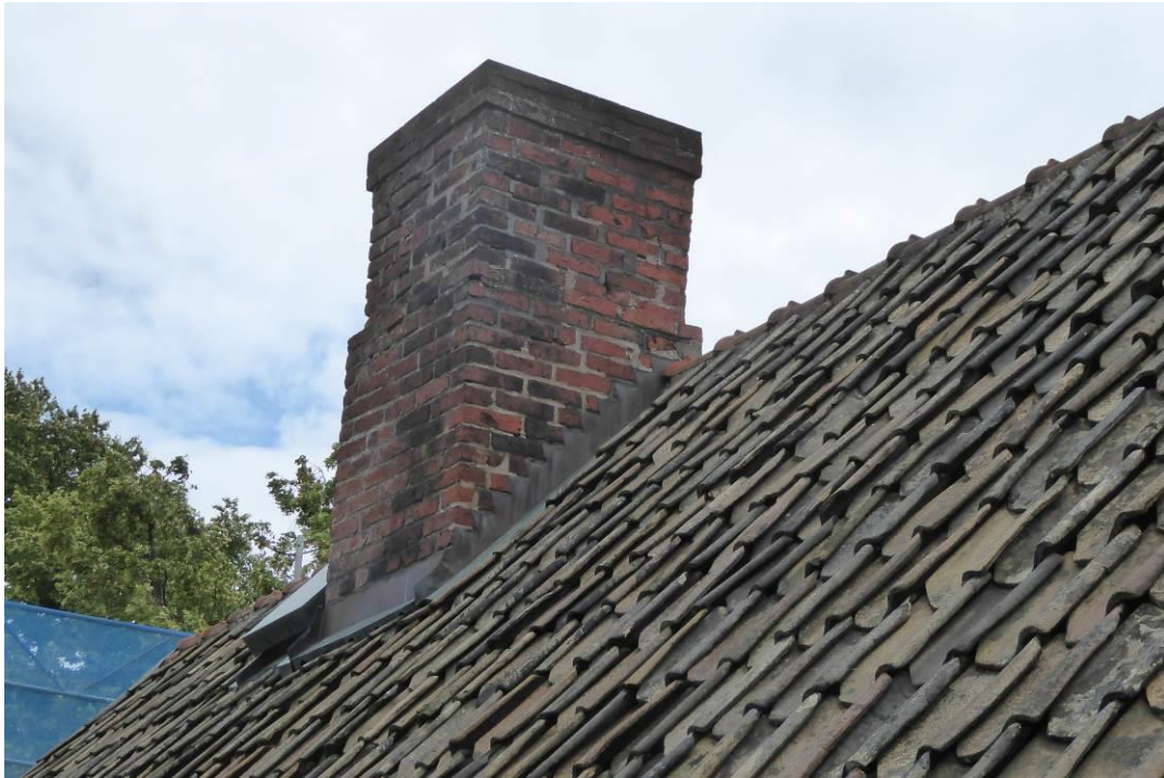
Före åtgärder norra takfallet.
