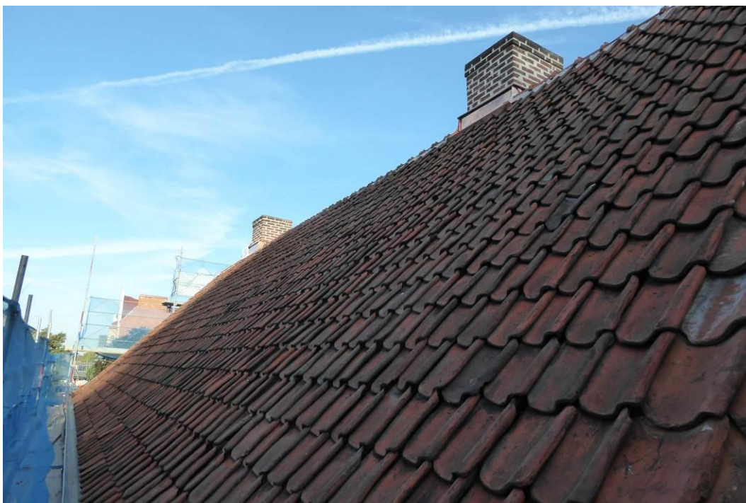
Efter åtgärder. Norra takfallet.
