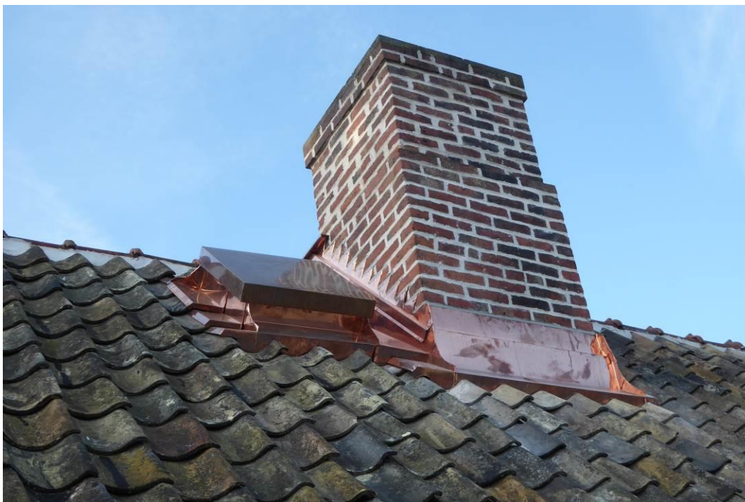
Efter åtgärder. Norra takfallet.
