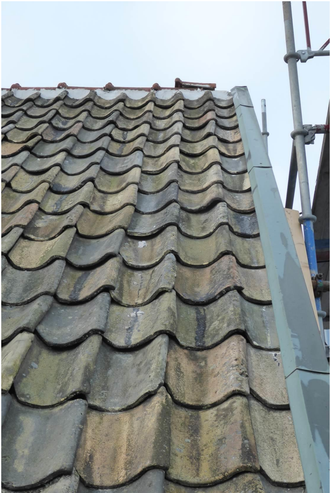
Efter åtgärder. Plåt på vindskivor återmonterades.
