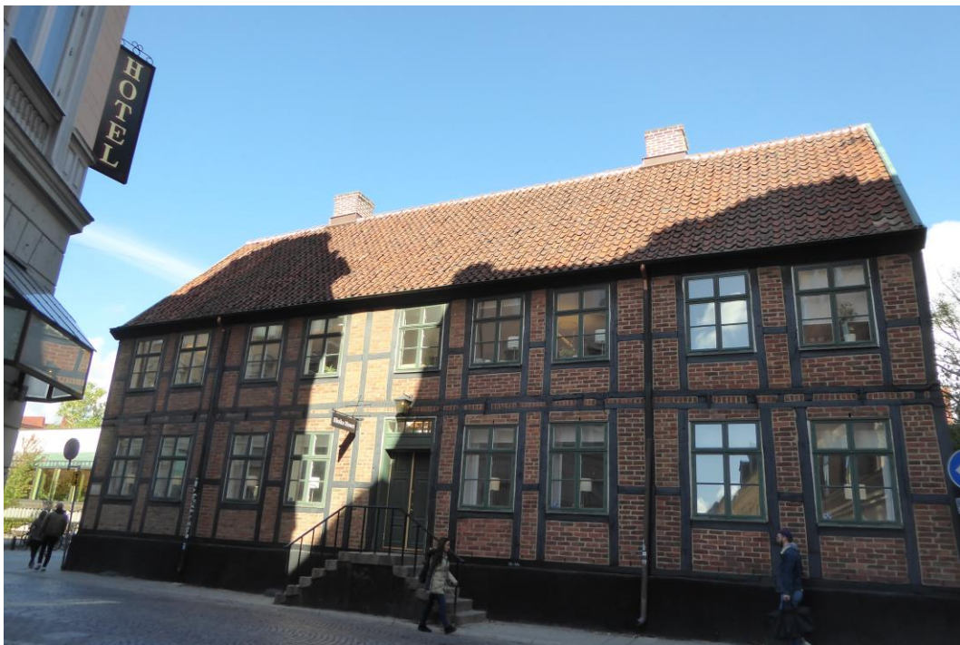
Efter åtgärder. Södra takfallet.
