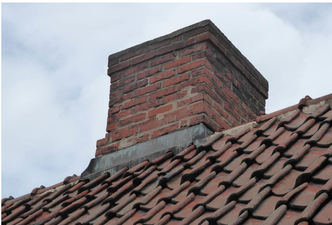
Före åtgärder södra takfallet.
