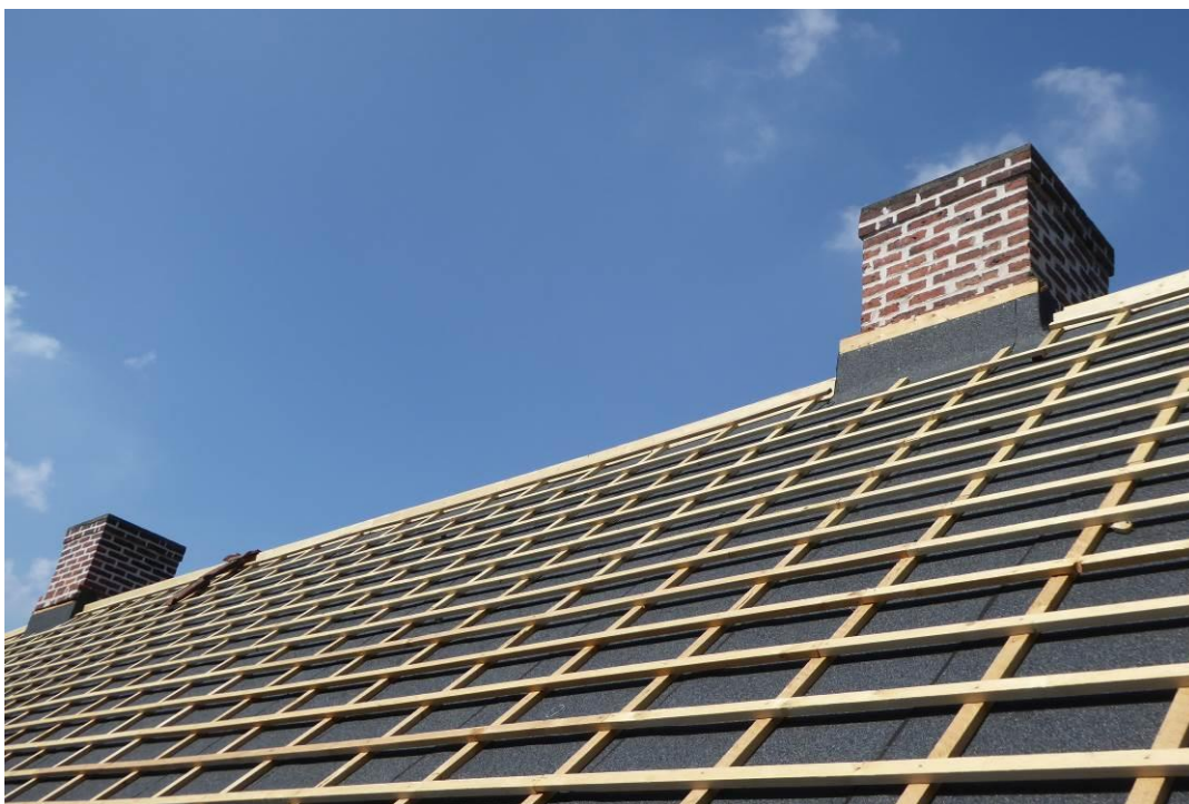
Under arbete södra takfallet.
