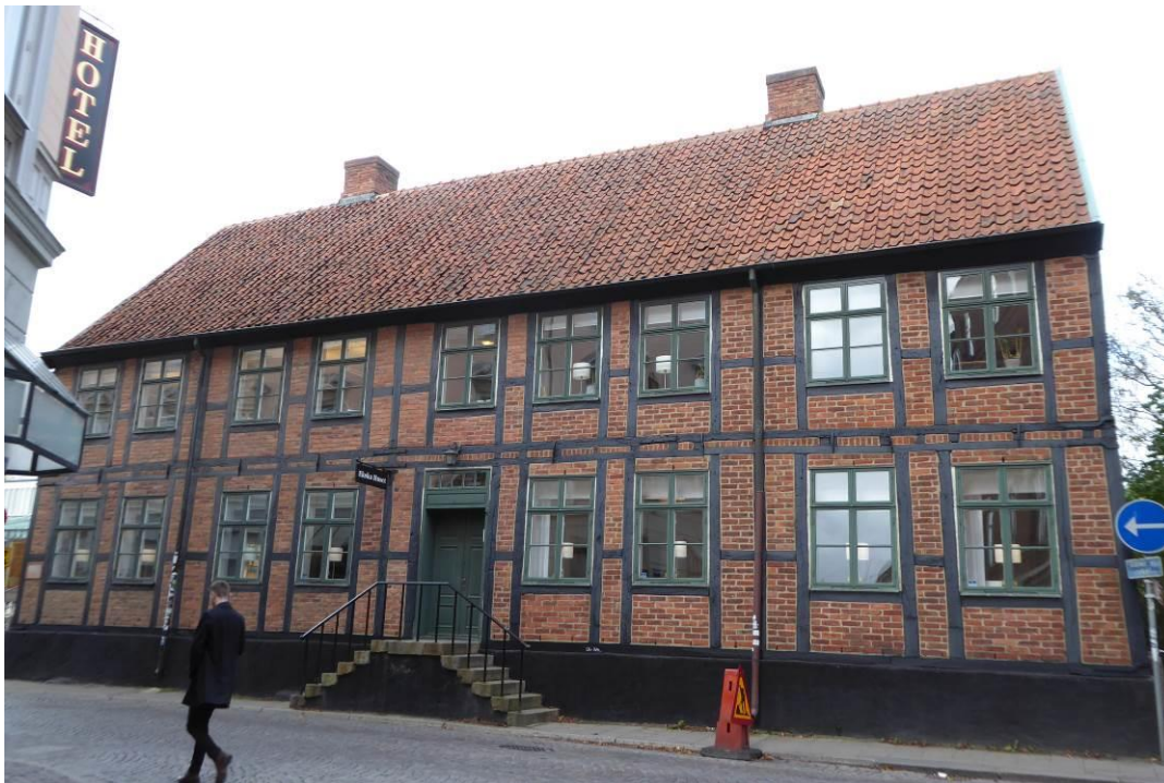
Före åtgärder södra takfallet.
