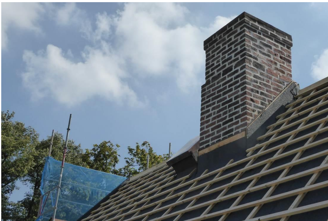
Under arbete norra takfallet.
