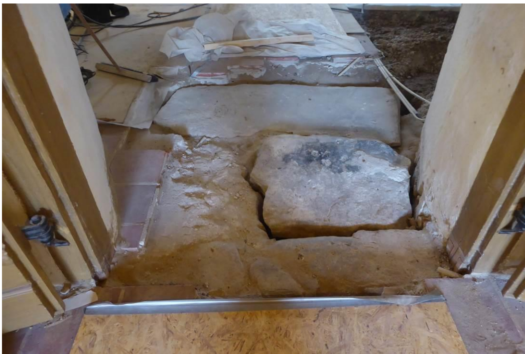
Stenar under betongplattan invid dörren mellan långhus och vapenhus blottades under arbetet. Vy mot långhuset.
