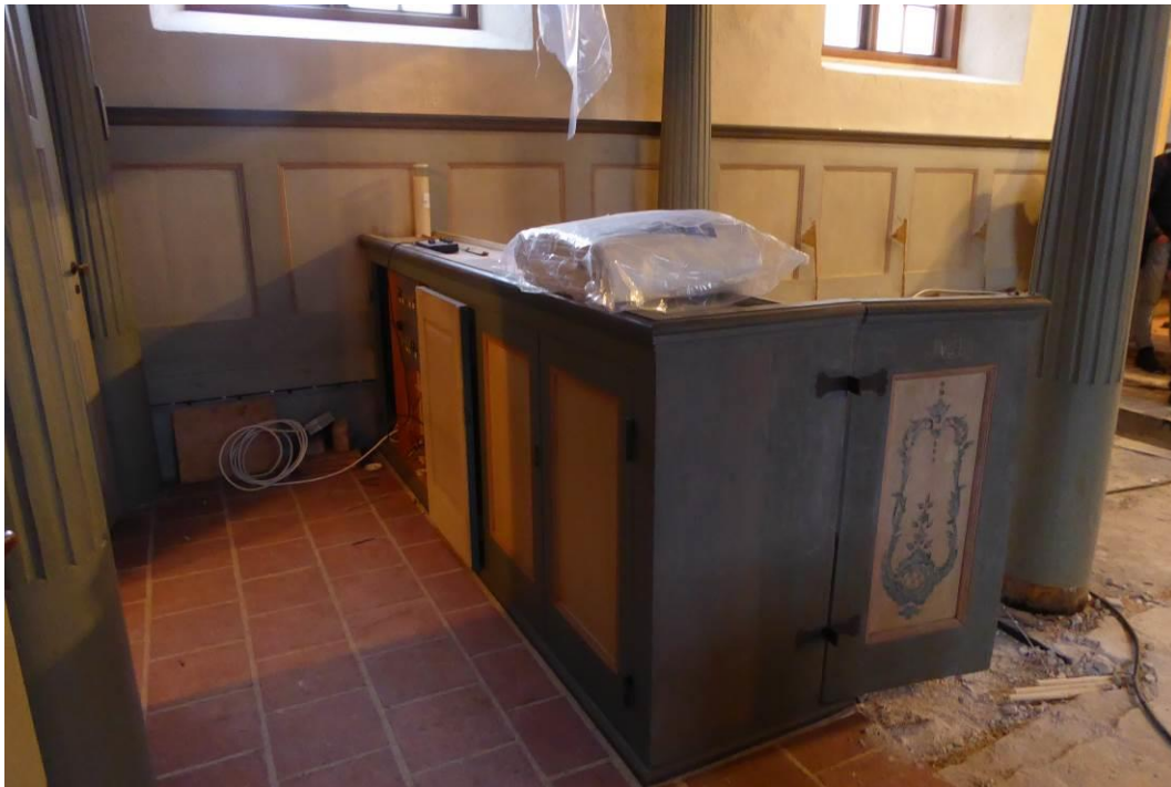
Nykyrkan. Skåp under läktaren som efter åtgärderna vänts och placerats mellan pelarna.
