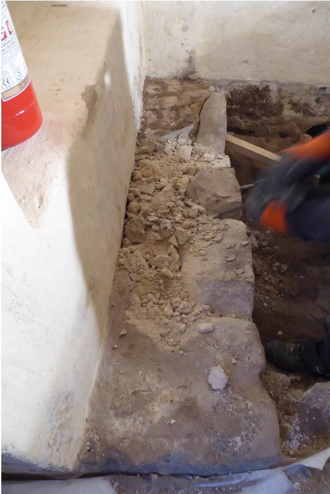
Under arbete. Avjämnande bruk har tagits bort från den murade bänken som ska demonteras i sin mittersta del. Bänkarna var inte murade i förband med ytterväggarna.
