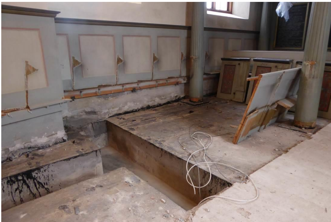
Nykyrkan. Demonterade bänkar samt betonggolv som bilas bort, på väggen syns tjärbestrykning som togs bort.
