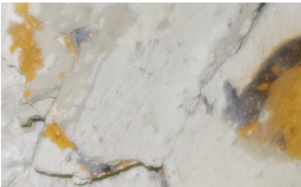
Detalj område 3. Ett ljust kalkskikt ligger strax under det ockragula skiktet. Grått och svart ligger strax ovanpå det ockragula. En varm grå tillhör de ovanpåliggande skikten och återfinns över hela ytan på väggen.
