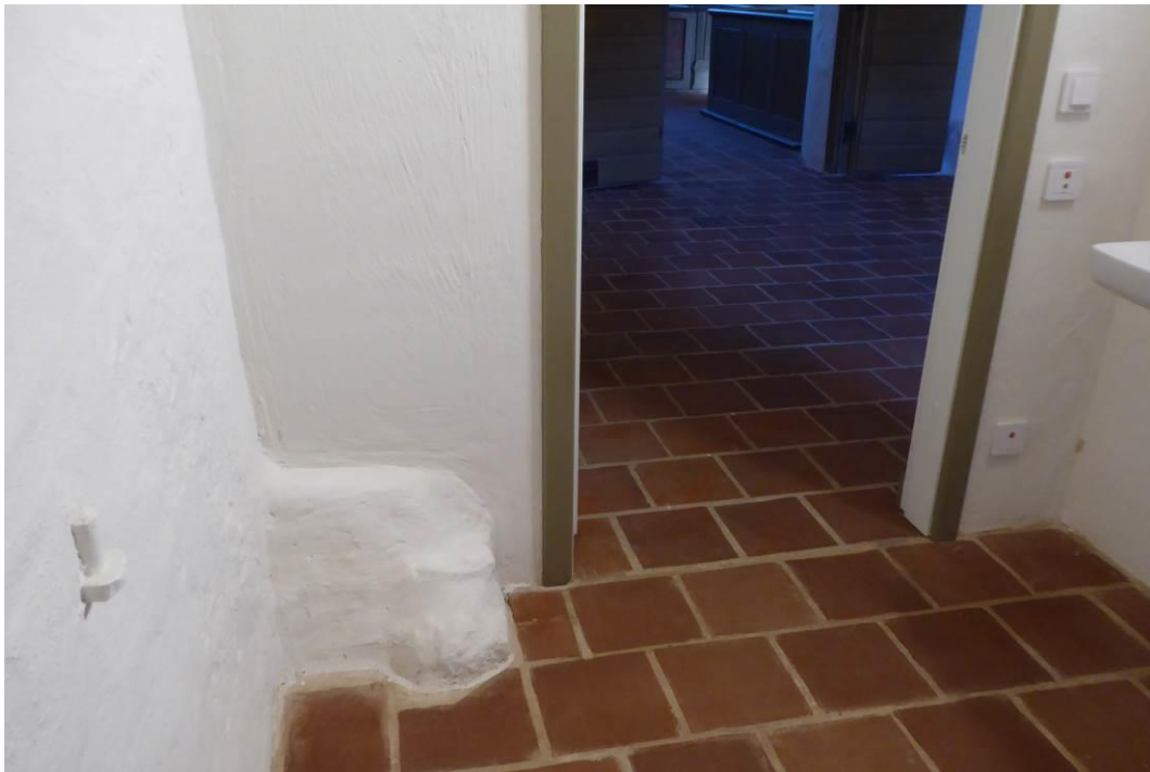
Efter åtgärder. Ny wc med bevarad synlig del av den murade bänken. Alla installationer är fästa i de nya träväggarna.
