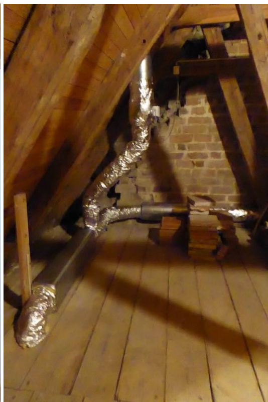
Efter åtgärder. Vindsstege i wc-utrymmet. Ventilationsdragning på vapenhusvinden. Till vänster i bild rör genom taket i förråd och yttertak.
