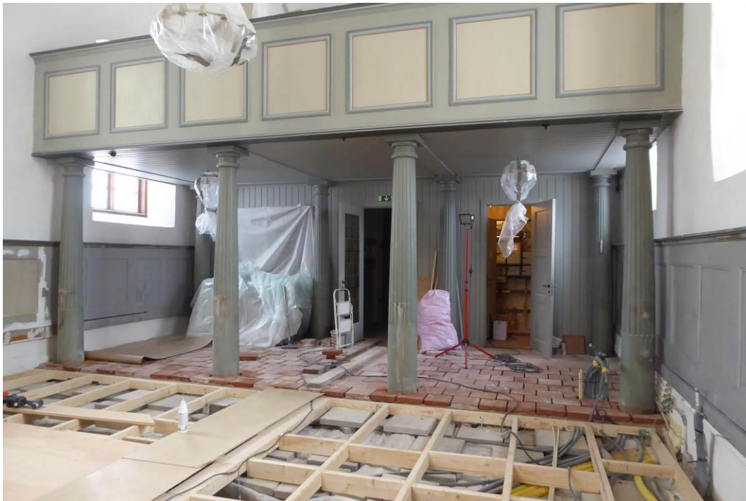
Nytt trägolv läggs i nykyrkan och tegelgolvet läggs om. Vägghälsarna under målning. Till höger i bild skymtas rördragning för konvektorerna längs väggarna.
