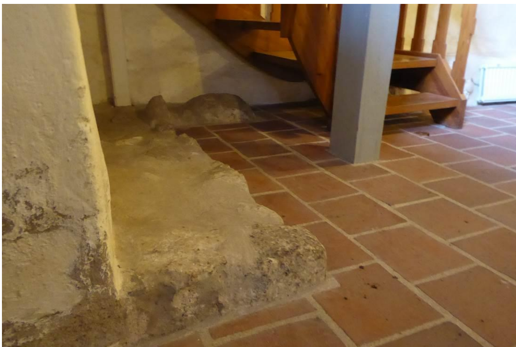
Före åtgärder. Sydvästra hörnet i vapenhuset. Murade bänkar hade redan tidigare delvis tagits bort.
