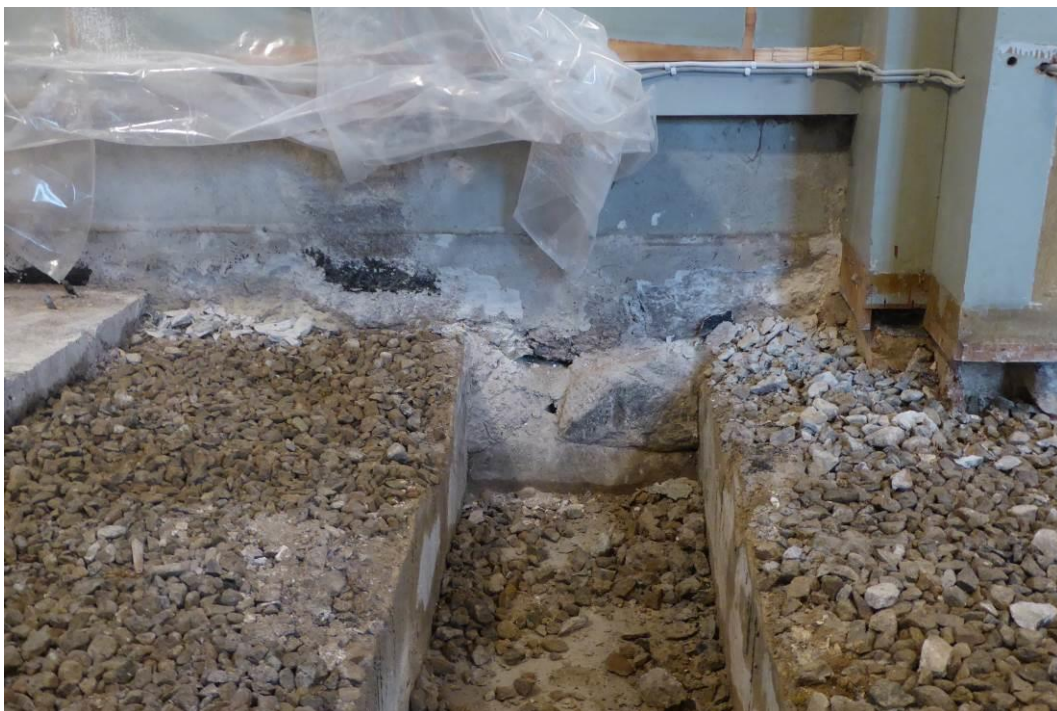
Långhusets södra vägg. Betongplattan där nya brädgolv ska läggas är borttagen. I yttermuren skymtas utkragande fältsten i murverket.
