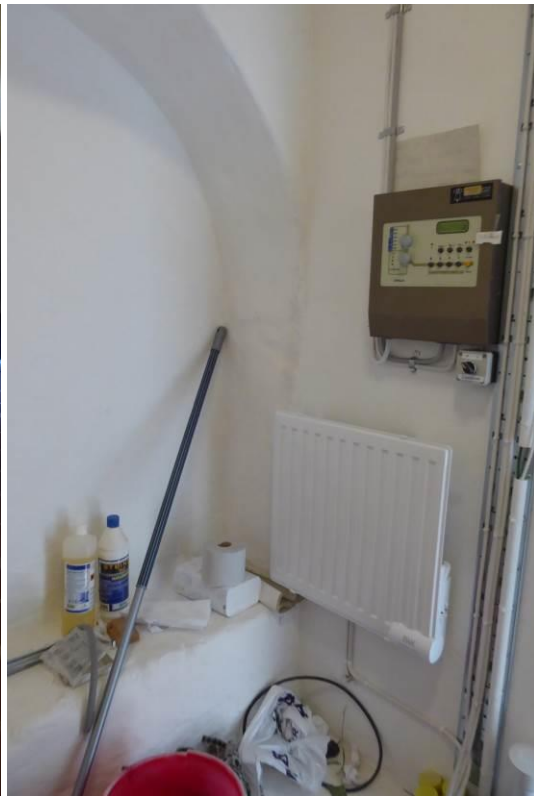
Efter åtgärder. Vänster: bevarad del av murad bänk i wc. Höger: alla installationer är fästa i nybyggda väggar och murad bänk är bevarad i sin helhet.
