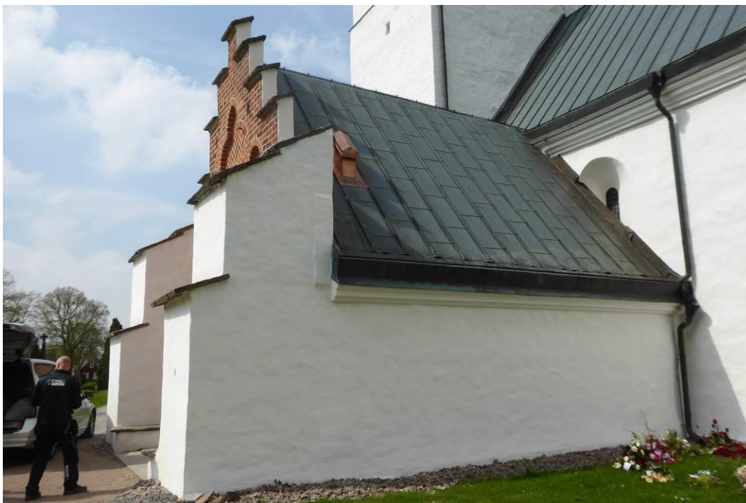
Efter åtgärder. Vapenhuset sett från sydost.
