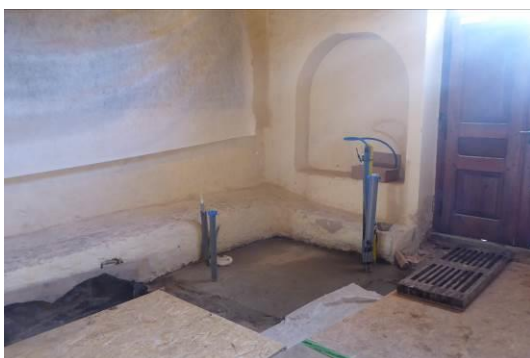
Nytt golv är gjutet i pentry/förvaring och i den nya toaletten.
