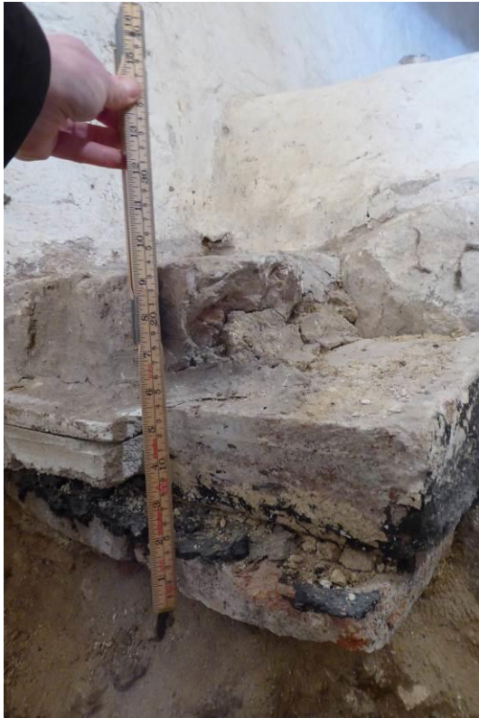
Nordvästra hörnet av gropen var murad med tegelsten och troligen golvplattor av tegel. Dessa var inte murade i förband med fortsättningen av bänken mot norr eller med vapenhusets yttervägg.
