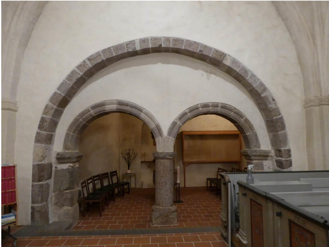
Före åtgärder. Vy mot tornet i väster.
