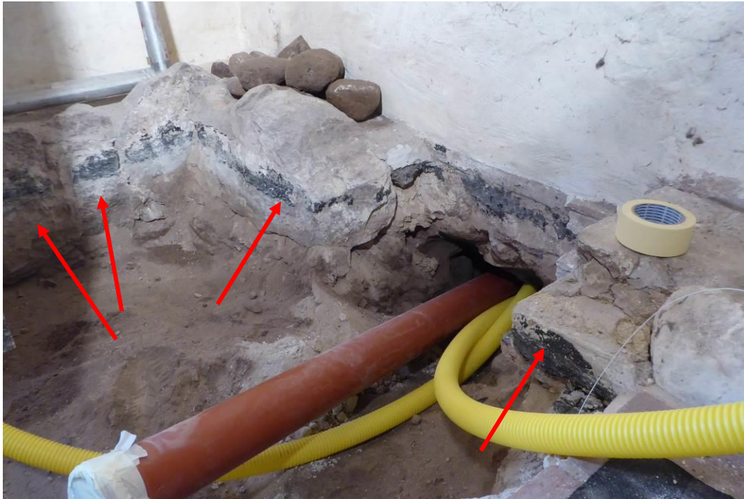
De med pil markerade stenarna togs bort. Hörnstenen lämnades kvar på sin plats.
