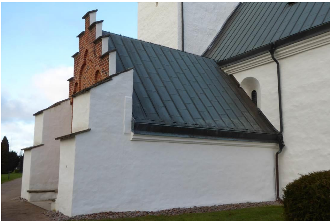
Före åtgärder. Vapenhuset sett från sydost.
