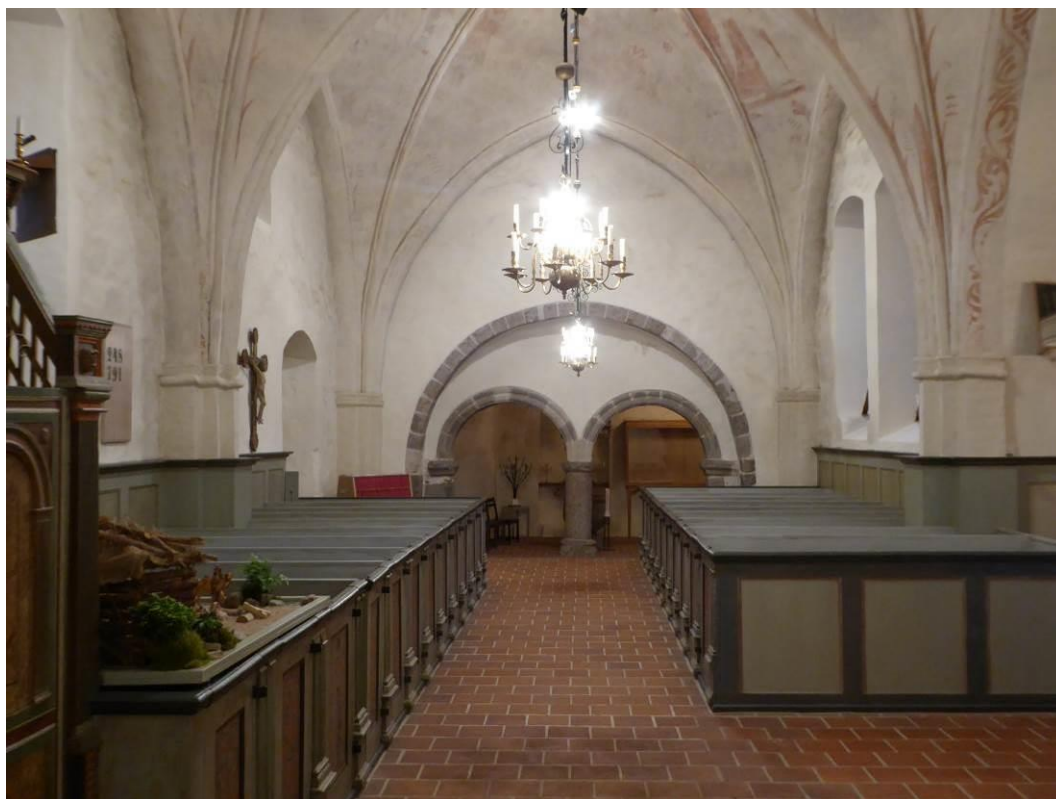
Före åtgärder. Långhuset vy mot väster.
