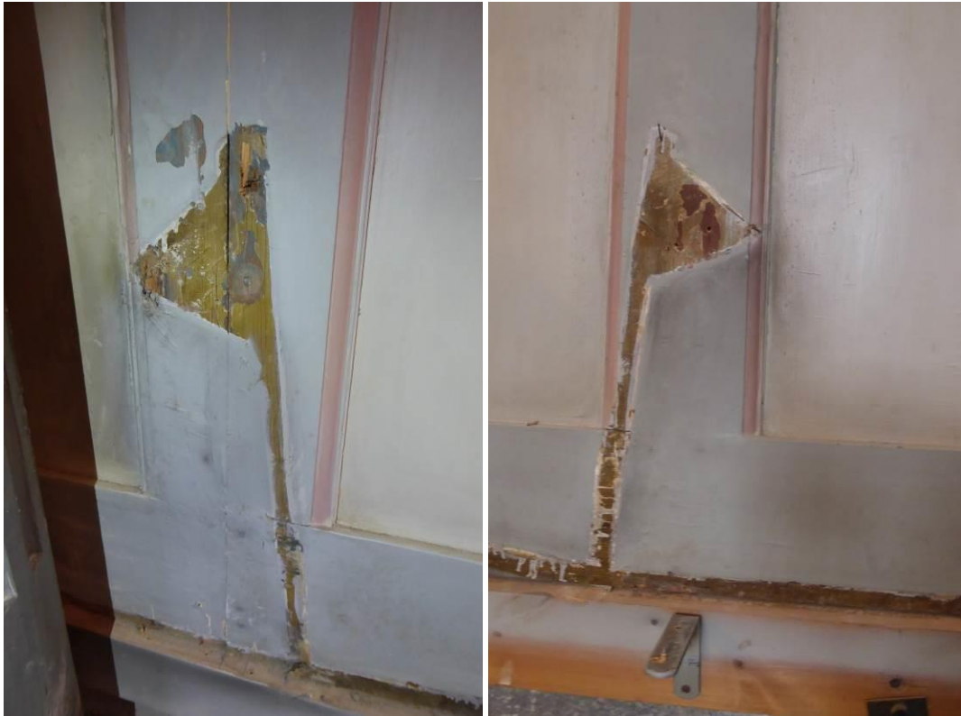
När bänkarna demonterats syns äldre bemålning på väggboaseringarna.
