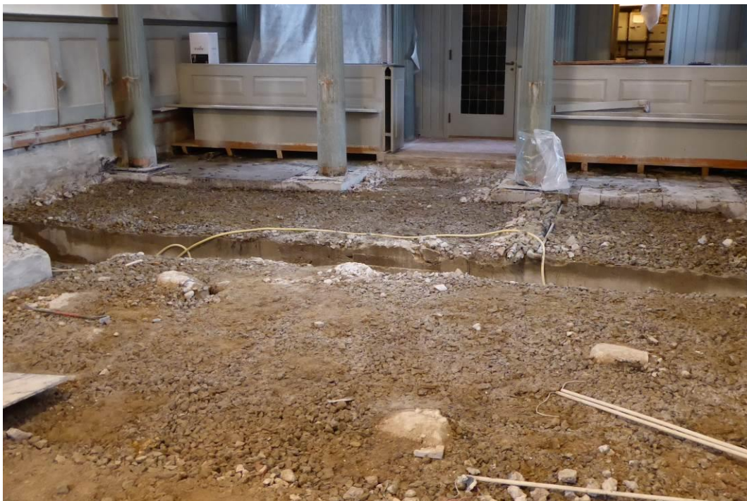
Nykyrkan vy mot norr. Betongplattan där nya brädgolv ska läggas är borttagen. Stenarna som syns i golvet är troligen grundstenar från långhusets norra yttermur som revs när nykyrkan byggdes i norr.
