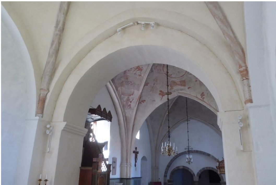
Ny belysning på befintliga skenor i koret.
