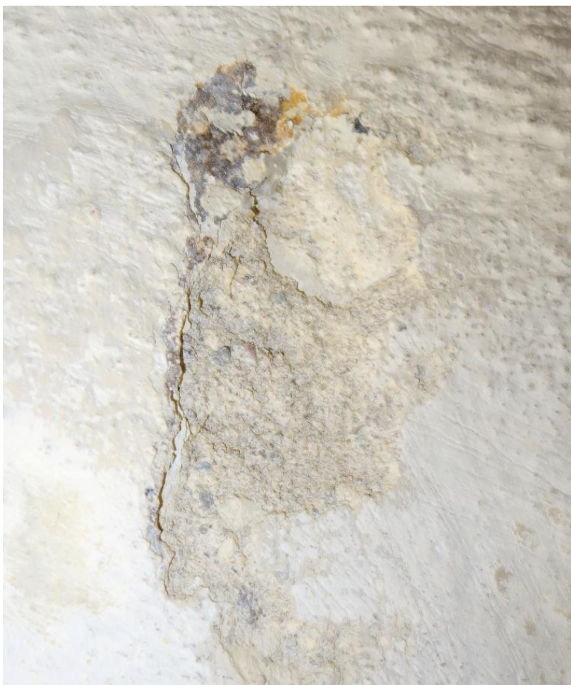
Område 6. Fragmentet finns upptill i en putsskada. Det större runda partiet till höger om bemålningen är den slammade yta som påträffats över väggen.
