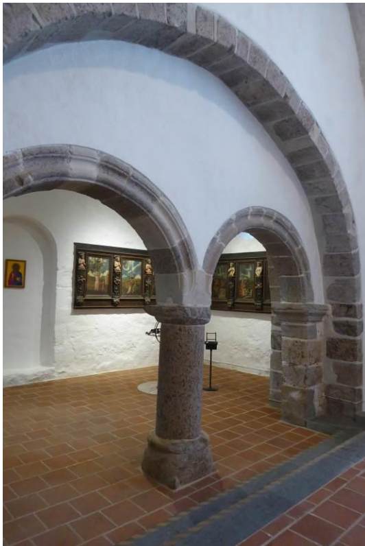
Ny placering av läktarbröstningar i tornet.
