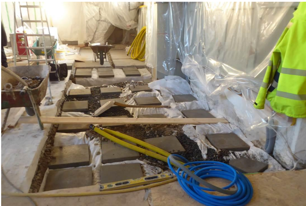
Markduk, lösa betongplattor och makadam där trägolv ska läggas. Södra sidan av långhuset.
