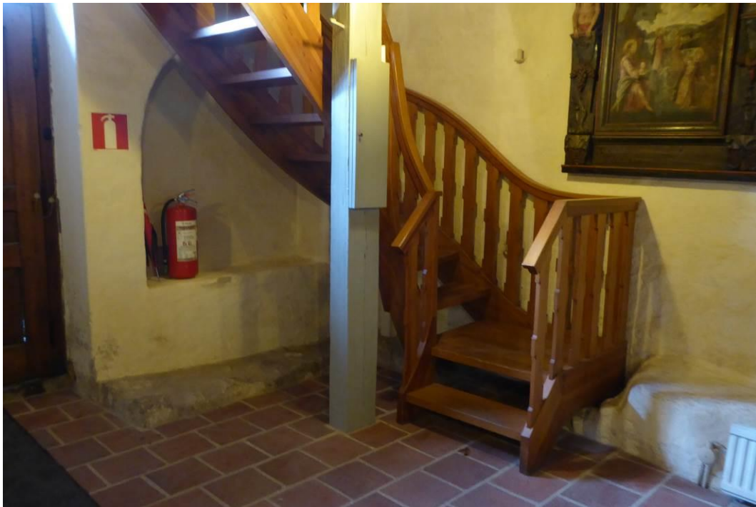
Före åtgärder. Sydvästra hörnet i vapenhuset. Murade bänkar till vänster om trappan i bild har delvis tagits bort.
