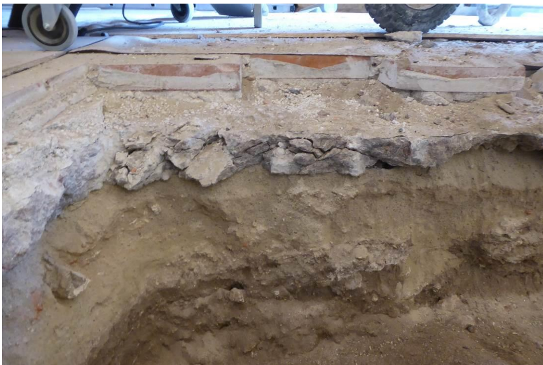
Vapenhusets golv där ny wc byggs (överst ligger tillfälliga byggskivor).
