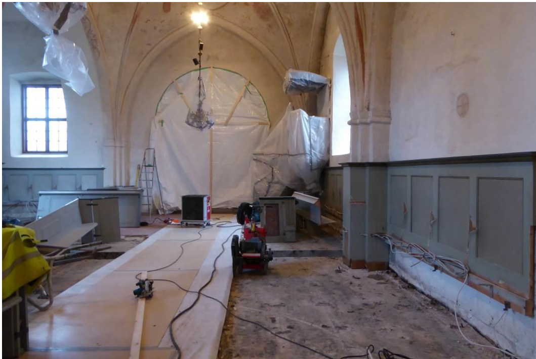
Långhuset. Bänkkvarteren är demonterade. Mittgångens tegelgolv sparades, betongplattan i övriga delar togs bort. Inventarier och koret är skyddstäckta.
