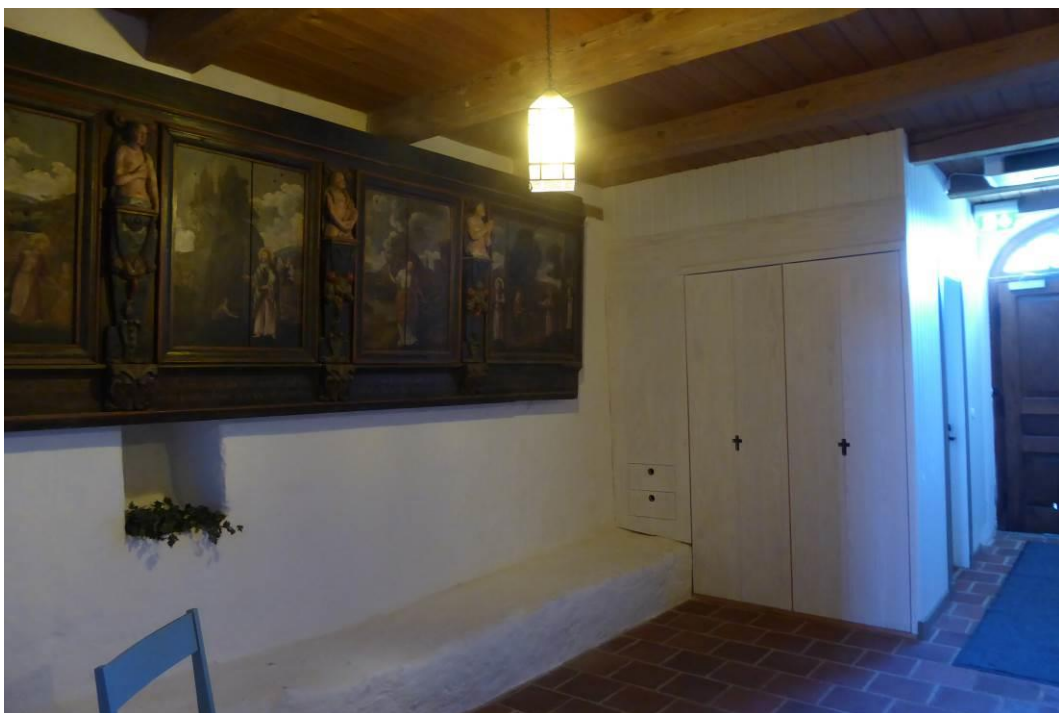
Efter åtgärder. Vapenhusets östra vägg med omhängd läktarbarriär samt nybyggt pentry och för-råd.
