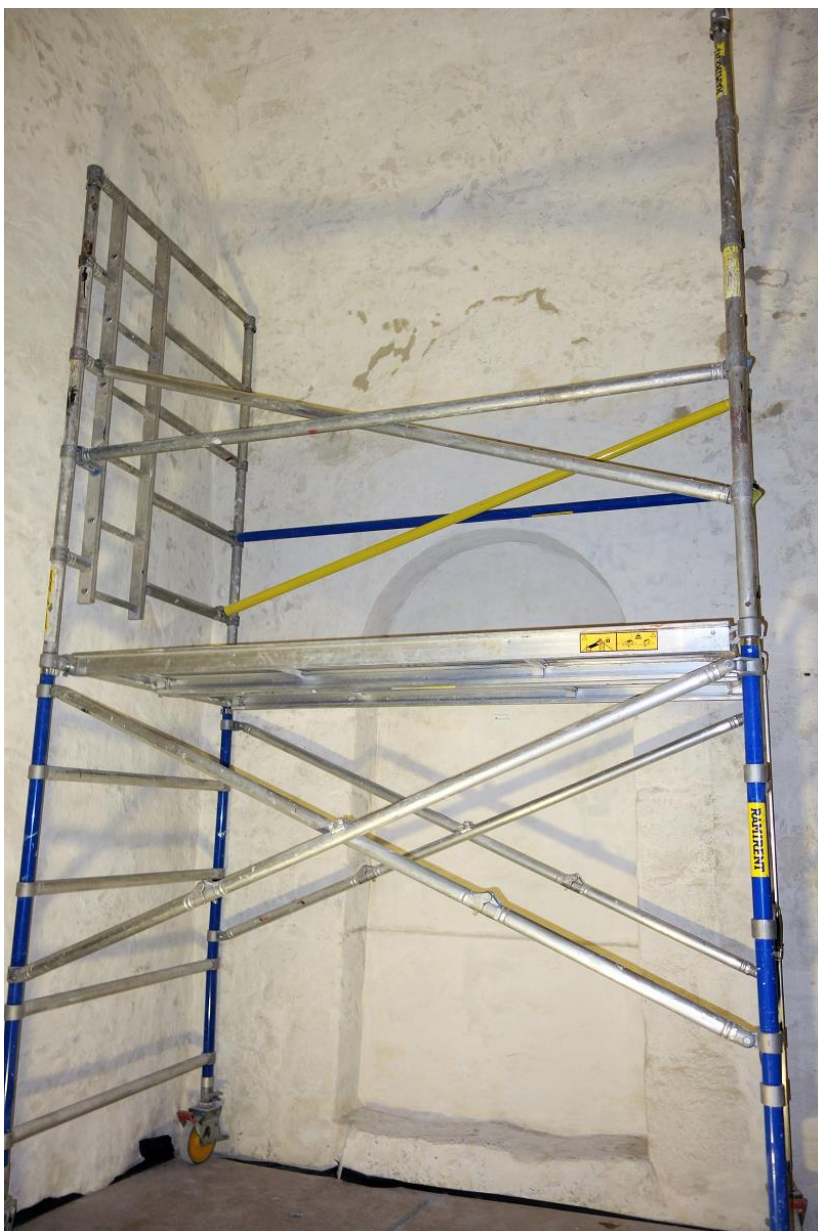
Väggen efter upplagning.
