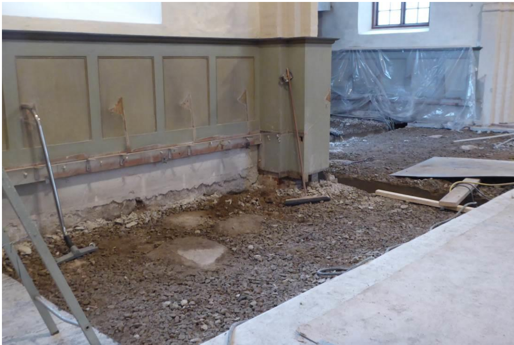
Betongplattan där nya brädgolv ska läggas är borttagen. Långhusets norra vägg med golvstenar (stenarna rördes inte). Stenarna som skymtas är möjligen grundstenar eller golvhällar.
