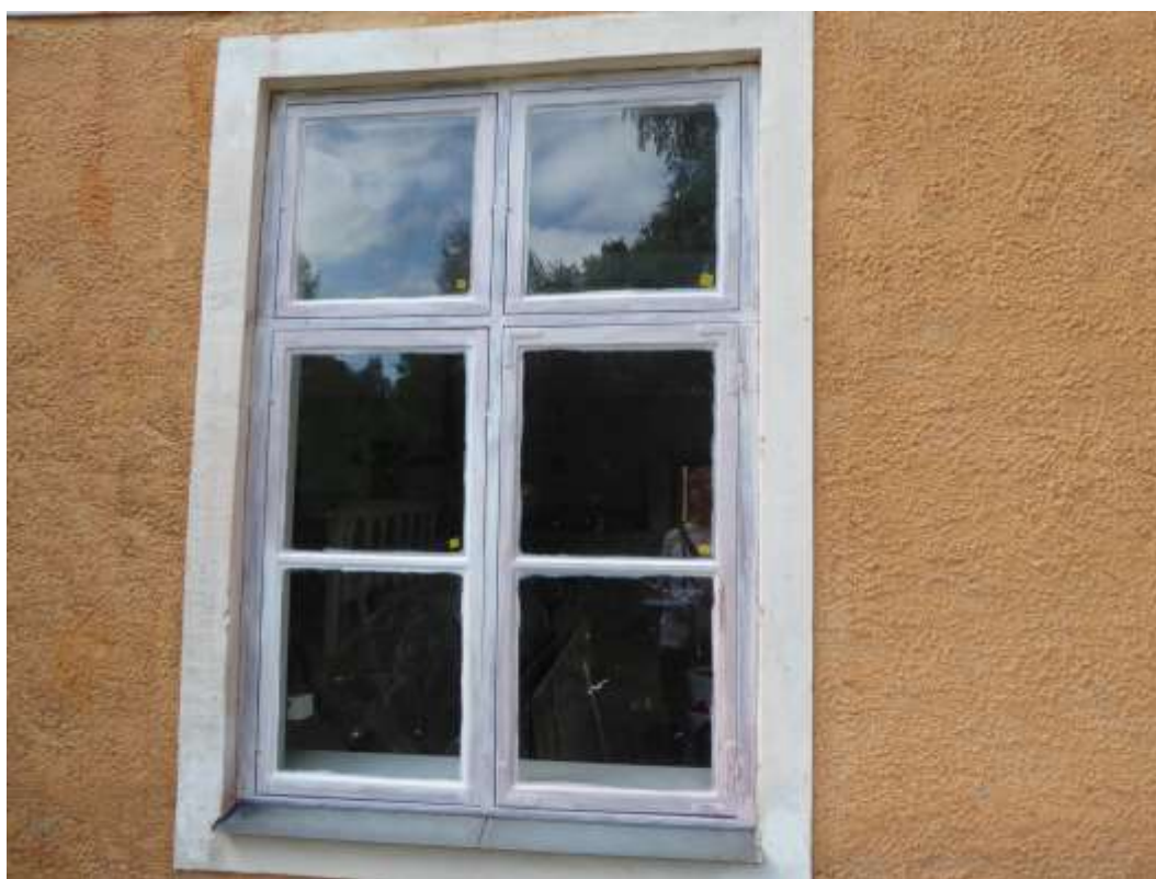
Fönster XI med felvända övre bågar. Grundmålade med vit grundfärg.
