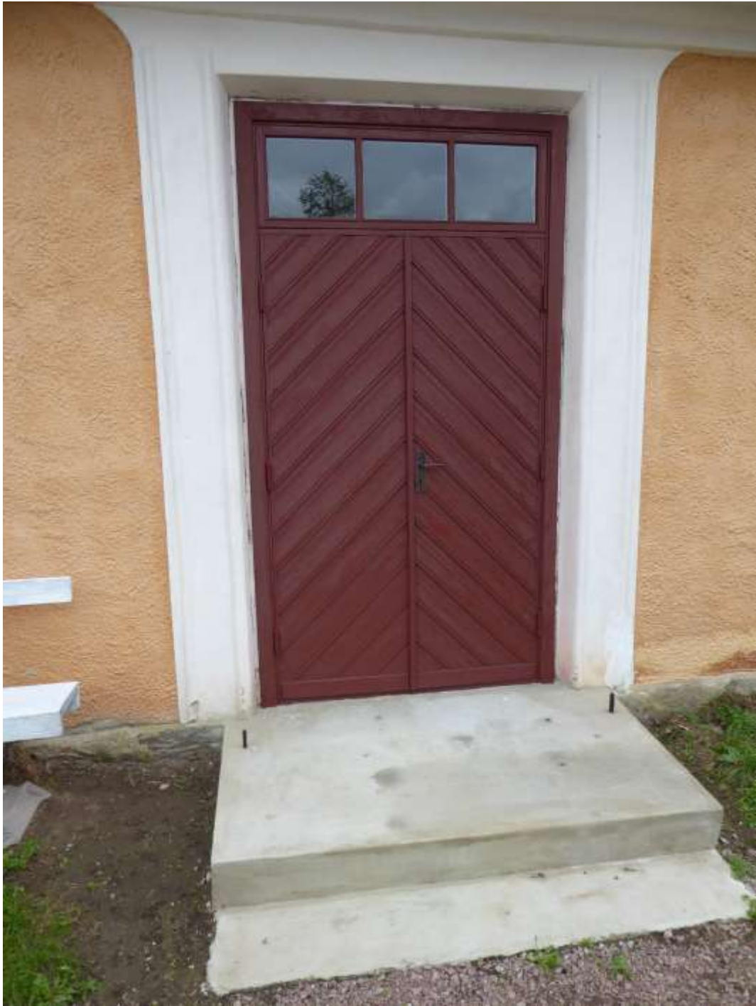
Dörr II efter utförd renovering.
