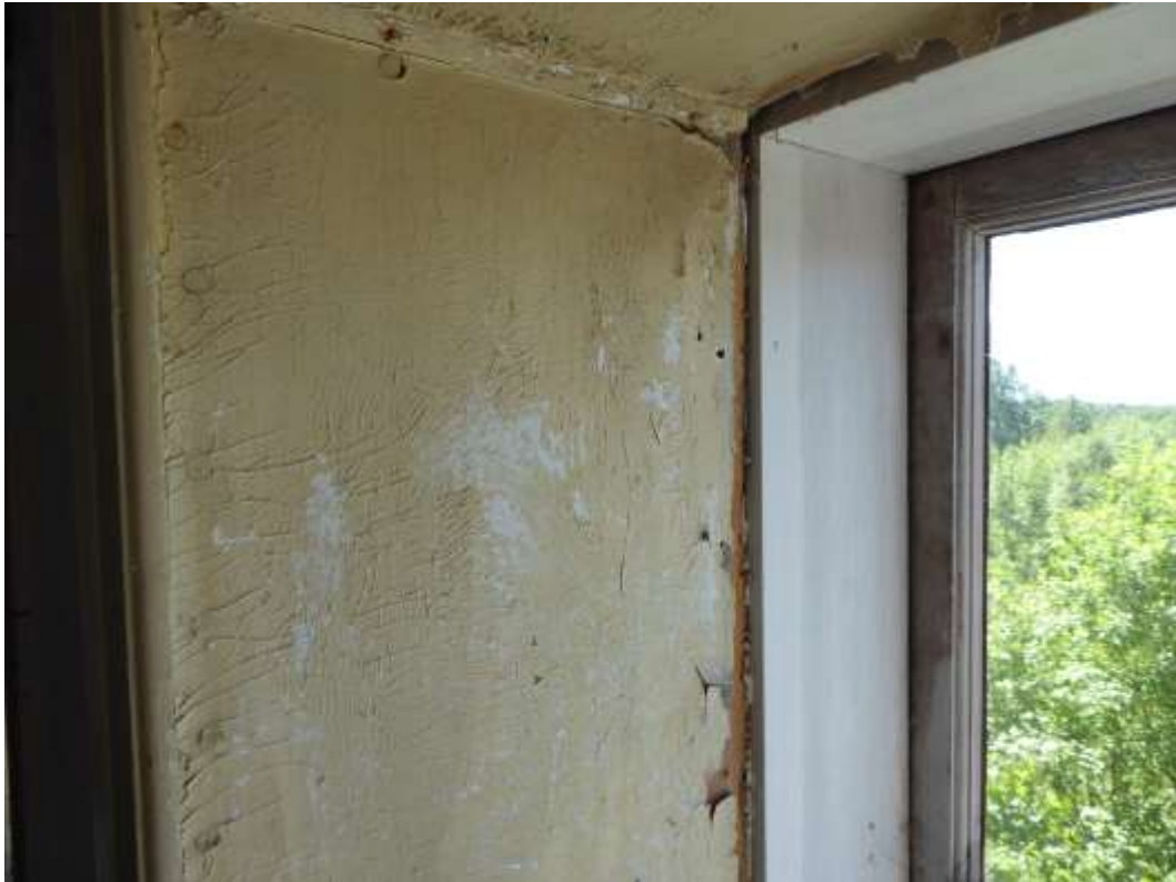
Karm på ovanvåning bytt i sin helhet (IV 1 ).
