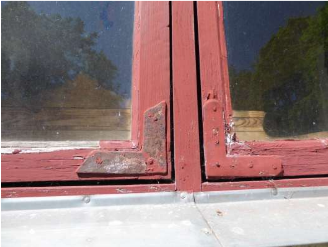
Olika varianter av hörnjärn samt de skarvade fönsterblecken.
