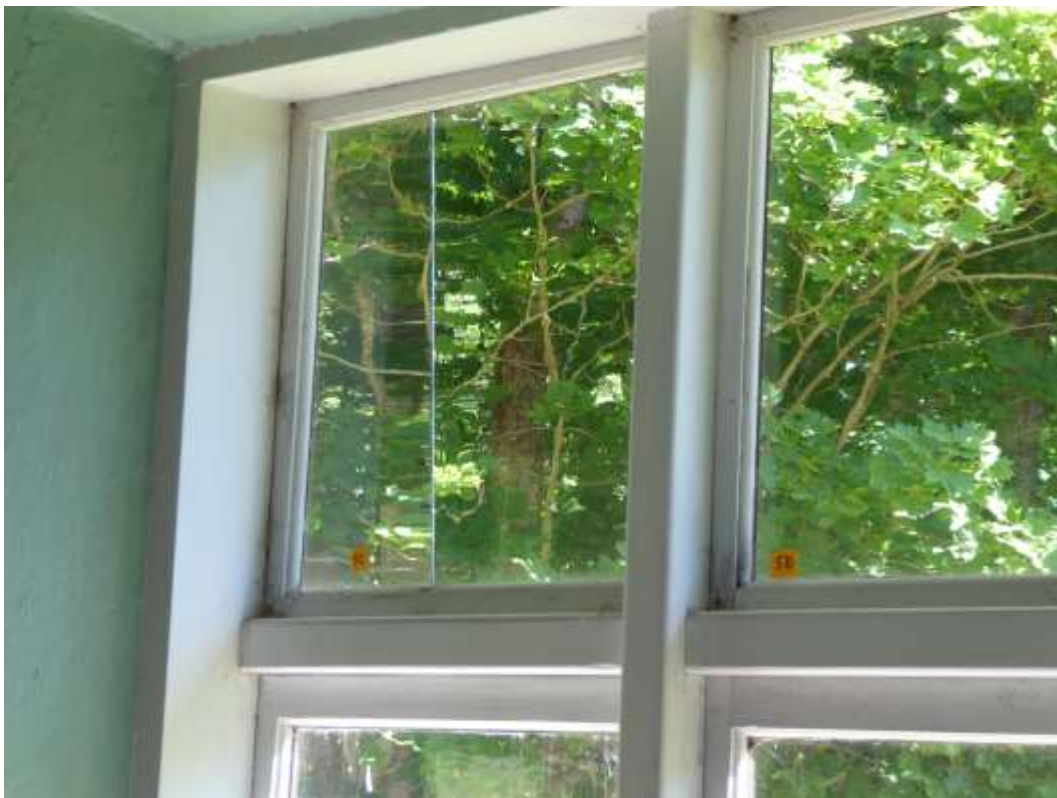
Fönster med den utbytta korsposten utan profilering.
