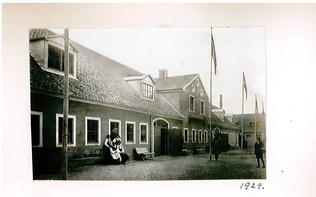
2. Allmogehallen efter ombyggnaden 1929. Takfönstren som finns i arbetsbeskrivningen verkar inte blivit utförda.
