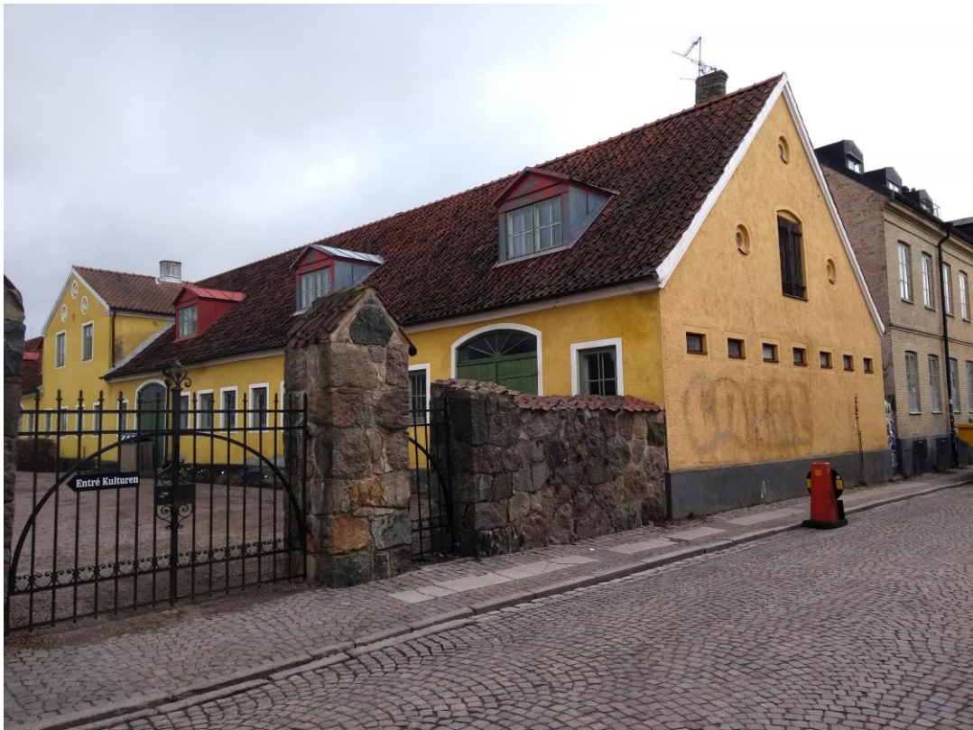
10. Del av västra fasaden och södra fasaden.
