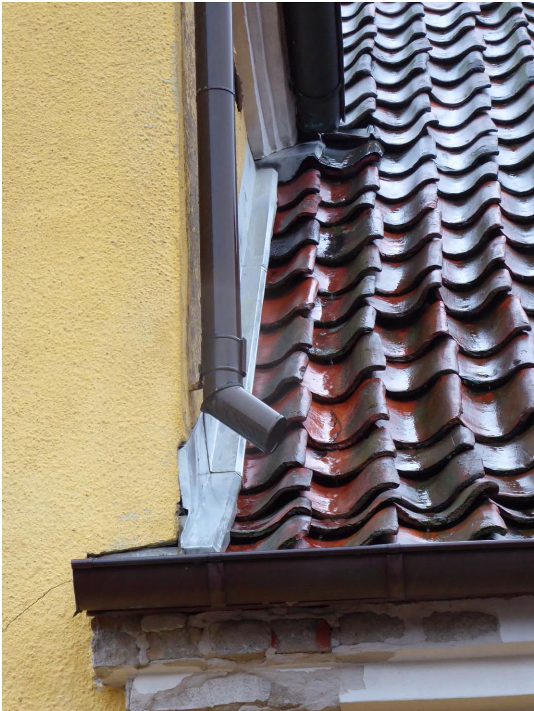
14. Handslagna tegelpannor och stuprör med lödade krökar. Västra fasaden vid frontespisen fotograferad vid regn.
