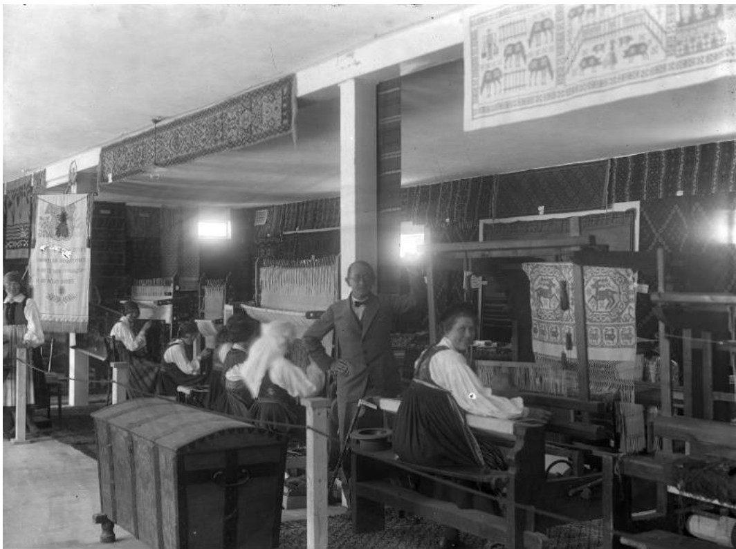
4. Väverskor i Allmogehallen 1929. Bjälklagsförstärkning med betongpelare gav öppna rum med gott om plats för vävstolarna.
