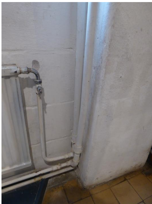
22. Dörr till rum 205A. 16 (höger). Äldre, självcirkulerande rördragning på bottenplan, nyare radiator. Vägghälskor till höger i bild.
