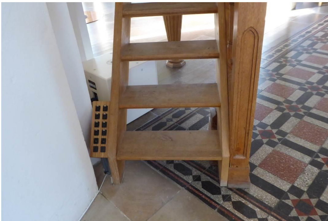
Efter åtgärder. Kontaktstycke i ek och under trappan en fristående subbas högtalare. Till vänster i bild skymmas kabel från korets högtalare som sedan går vidare under golvet i befintligt kabelrör.
