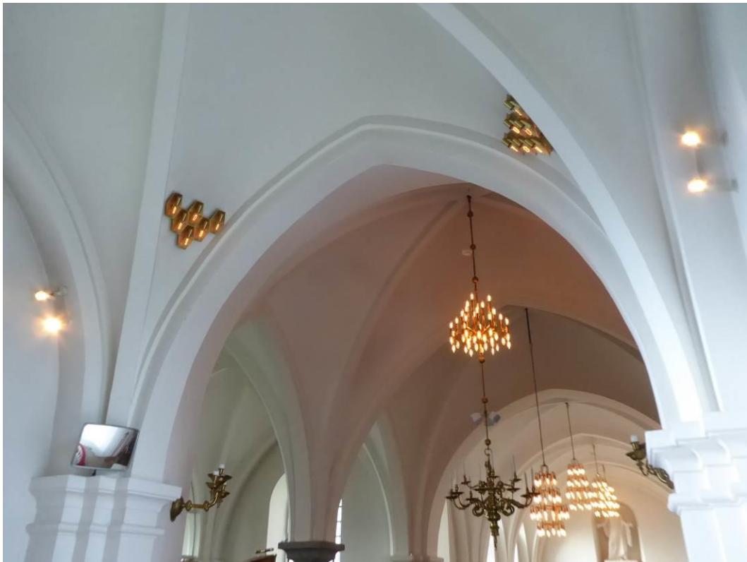
Koret och vy mot väster före åtgärder.
