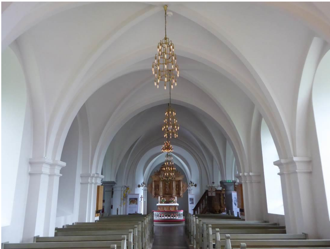
Långhuset vy mot öster före åtgärder.
