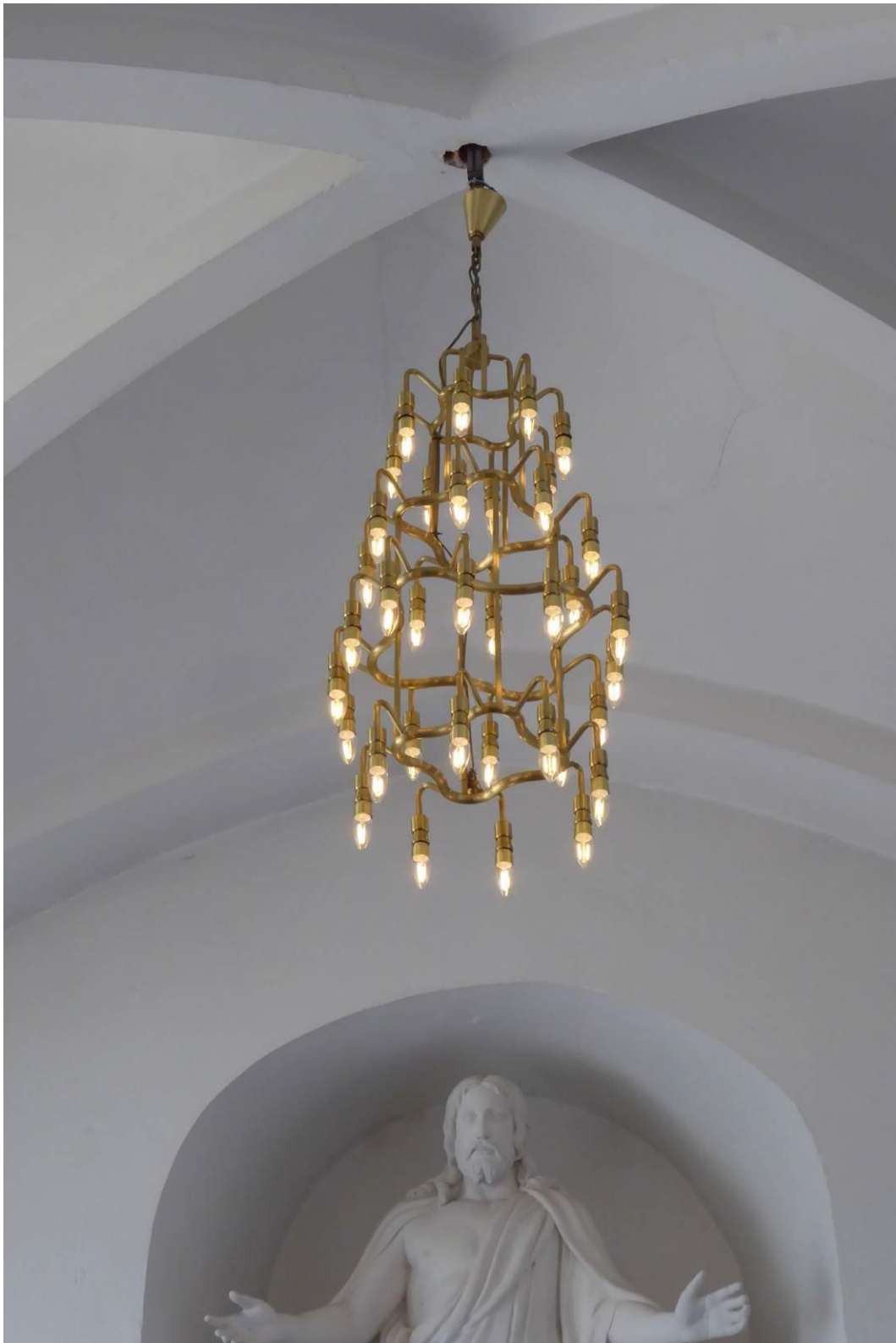
Efter åtgärder. Ny liten spotlight i mässing i ljuskronans nedre krans.
