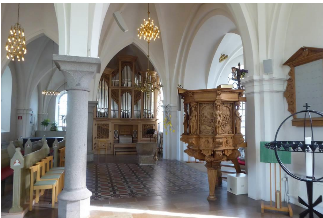
Efter åtgärder. Vy i korsarmen mot norr. Ny högtalare i vajer invid takkronan i bildens mitt, en ny högtalare på pilastern till höger i bild, ny högtalare under predikstolen.
