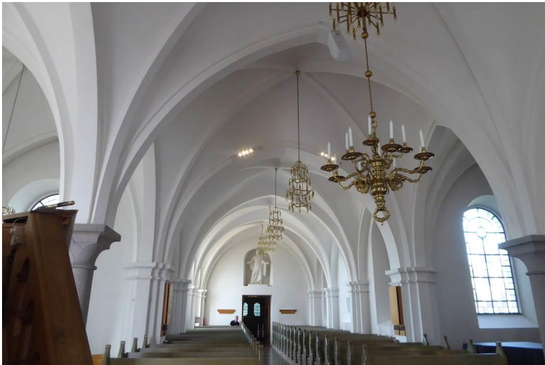
Efter åtgärder. Långhuset med ny högtalare invid ljuskronan till höger i bild samt spotlights på valvbåge.
