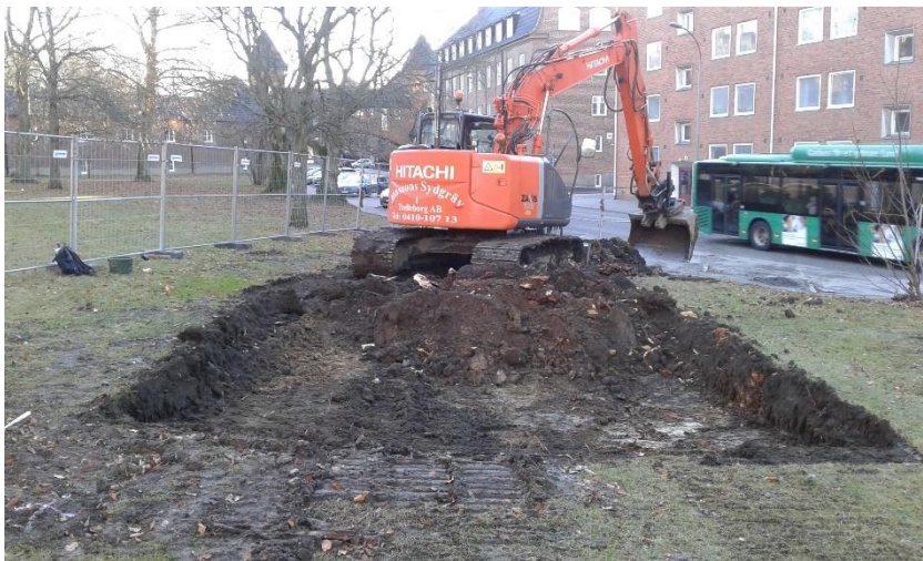
Figur 4. Översikt från norr. Avbaningen påbörjad.
