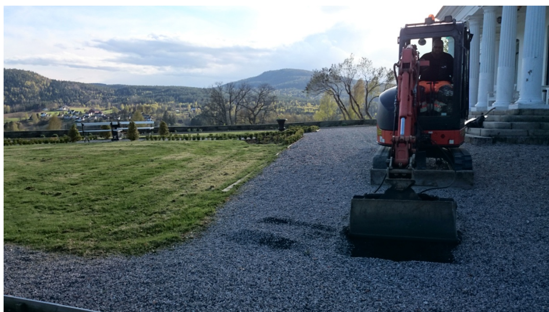
Figur 34. Övre terrassen innan schaktningen påbörjas. En svag förhöjning av ytan framför trappan kan skönjas. Fotografi från öster.
