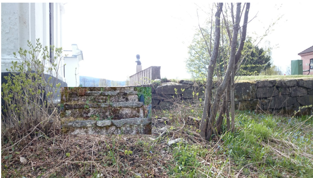
Figur 51. Platsen för en försvunnen trappa? En trappa är fotomonterad förslagsvis på den plats där det kan ha funnits en. Fotografiet taget från öster mot huvudgårdens nordöstra flygel.
