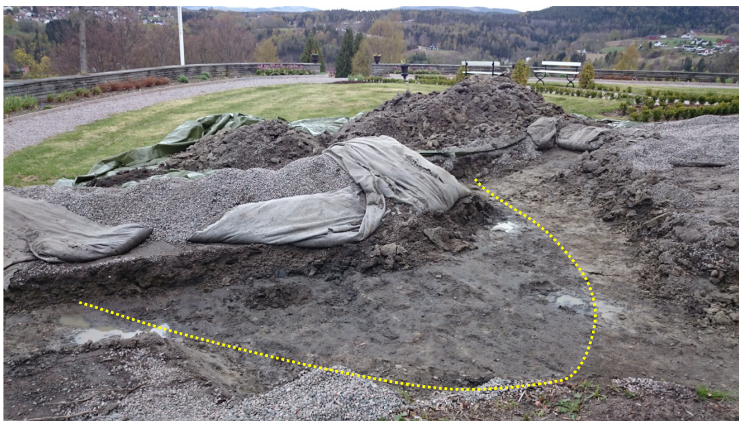
Figur 35. Övre terrassen efter schaktning. Den gula streckade linjen är begränsningen för den tidigare formen på anläggningen. Fotografi från norr.
