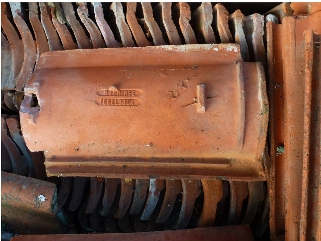
Befintliga tegelpannor som återlagts.
