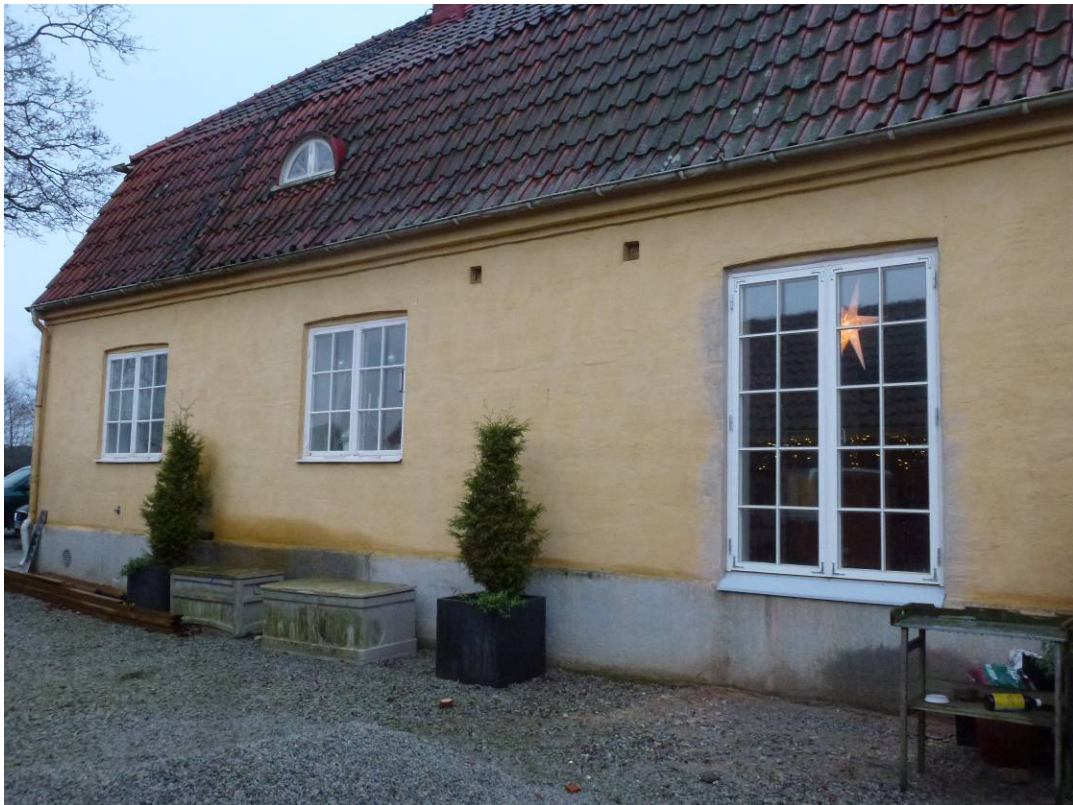
Bostadshuset efter åtgärder. Fönsterdörren är inmonterad.
