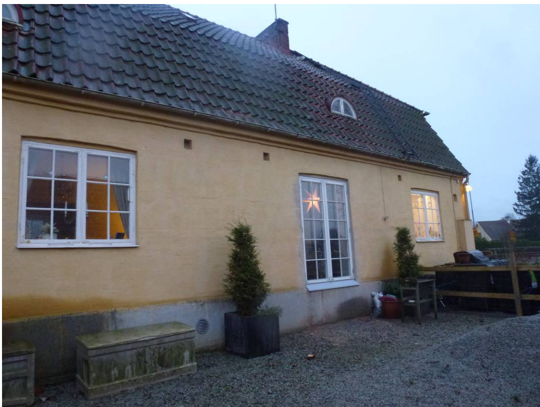
Bostadshuset efter åtgärder. Fönsterdörren är inmonterad.
