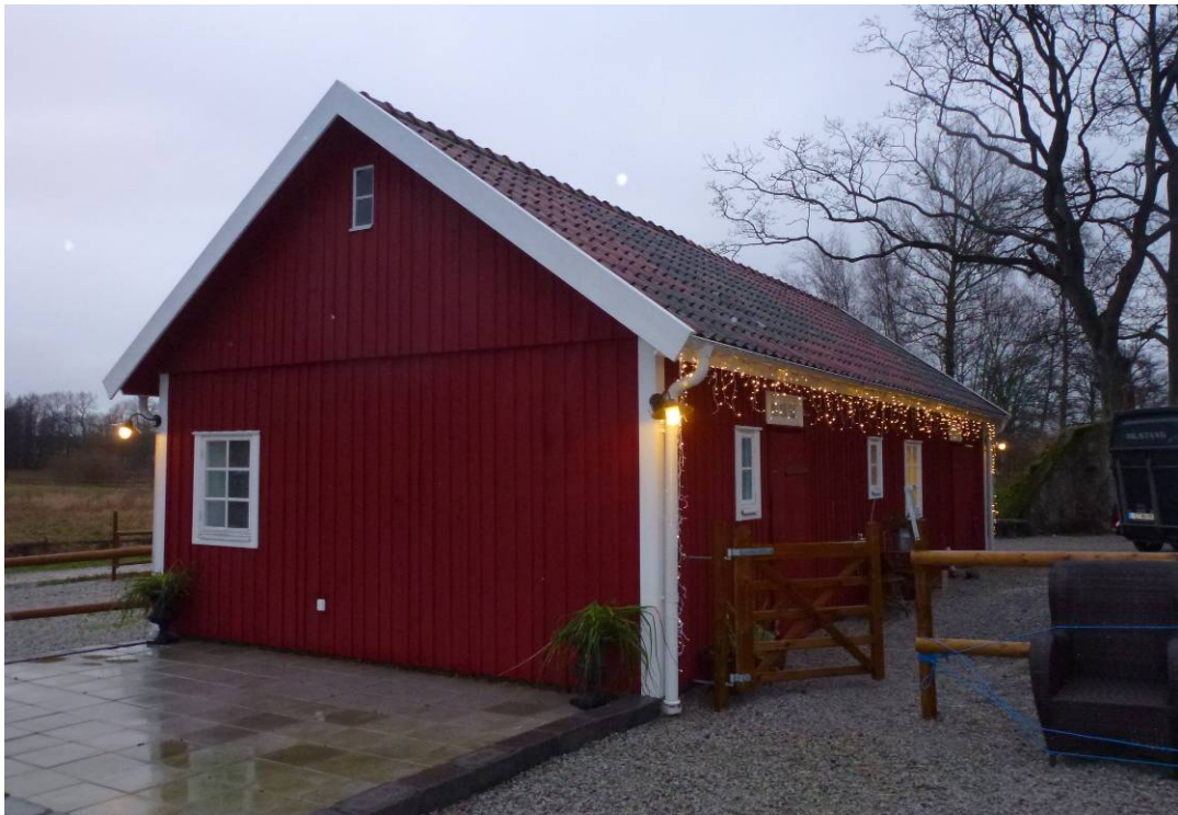
Efter åtgärder. Västra gavelfasaden med två återanvända fönster. Södra fasaden med återanvända dörrar och fönster samt ett nytt fönster. Ny fasadpanel och återlagda takpannor.
