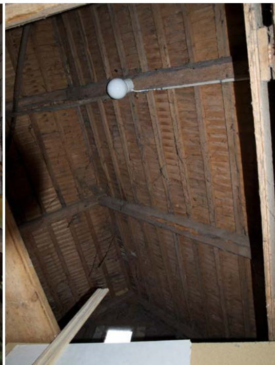
Före åtgärder ekonomibyggnaden. Vänster: Nordvästra rummet. Höger: Takstolar och stickespån.
