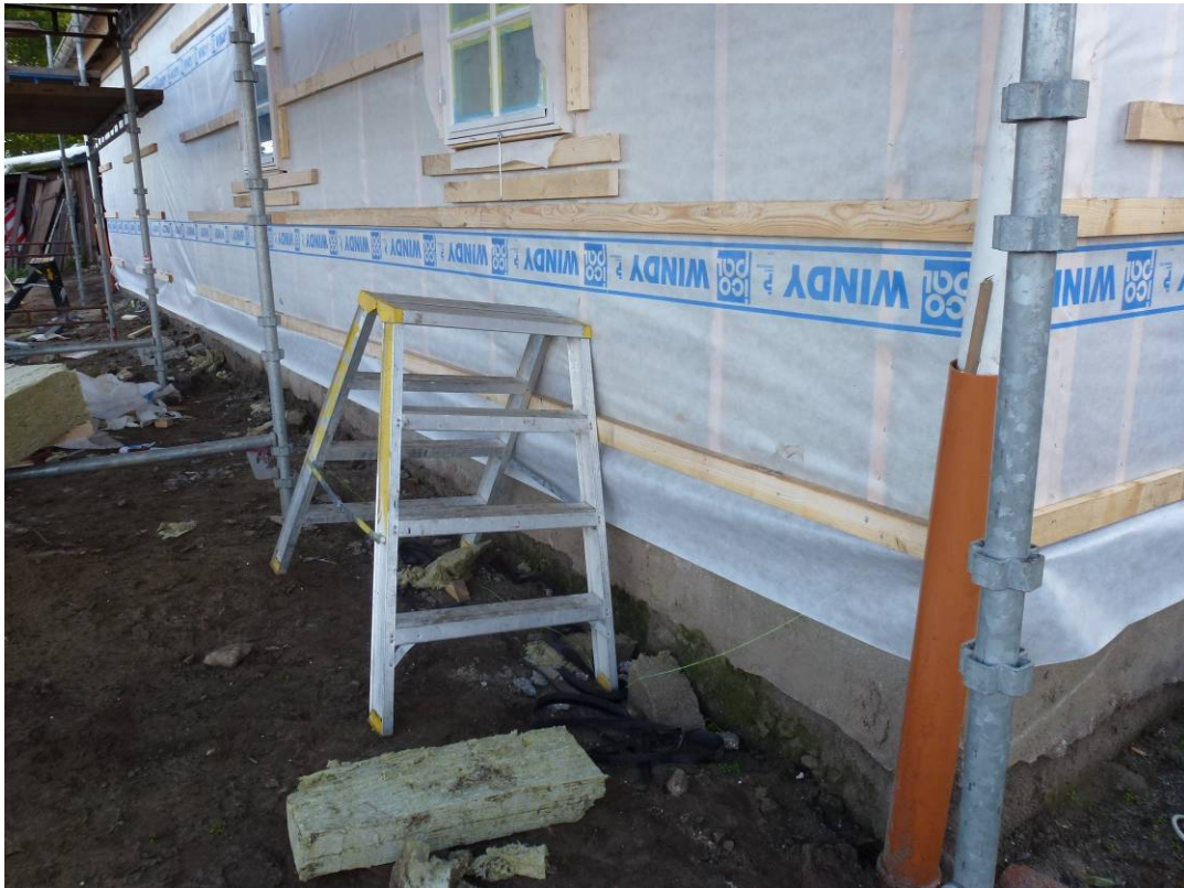
Under arbete med ny stomme.
