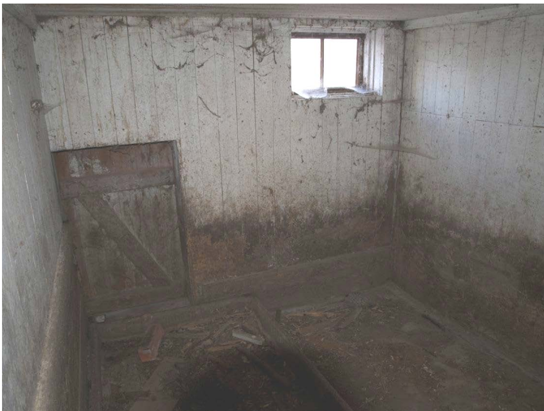
Före åtgärder. Ekonomibyggnaden interiör, rum mot norr.
