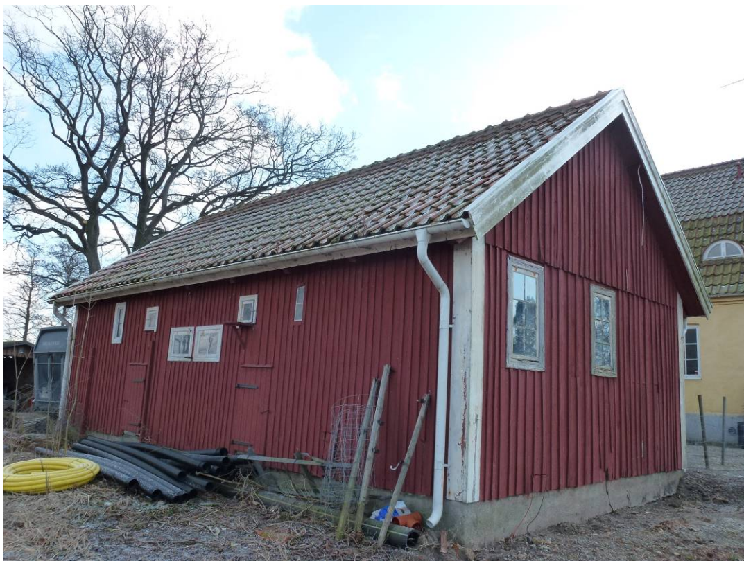
Ekonomibyggnaden före åtgärder. Norra och västra fasaderna.
