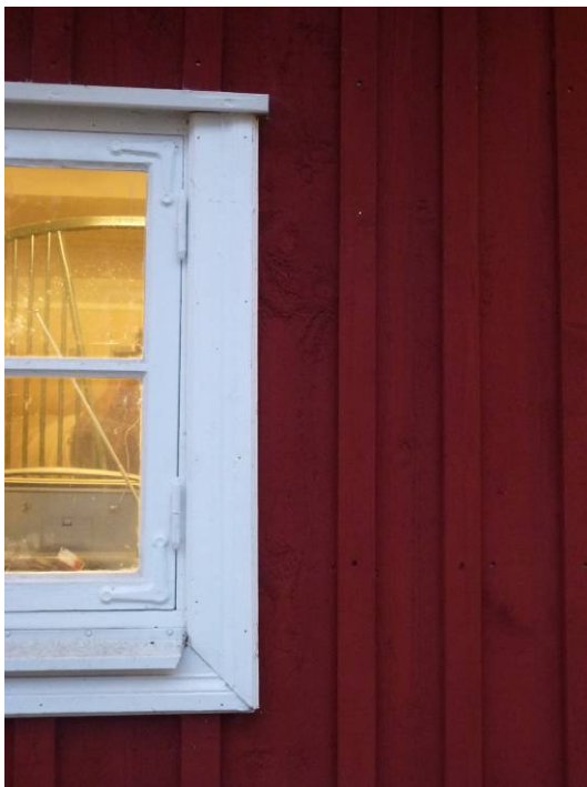
Efter åtgärderna. Återanvända dörrar och fönster med profilerade foder Locklistpanel i varierade bredder.
