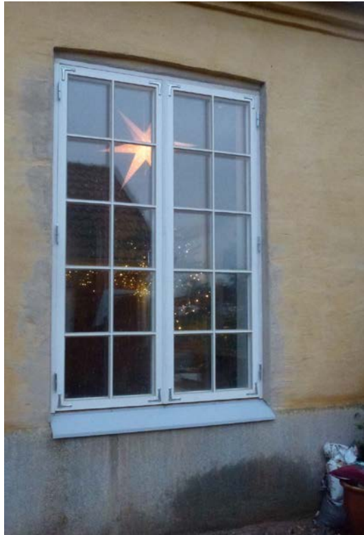
Vänster: Under arbete, håltagning i fasaden inför inmontering av ny dörr. Höger: Efter åtgärder. Fönsterdörren är inmonterad. Återstår att slutstryka dörr och gångjärn samt dörrsmyn.
