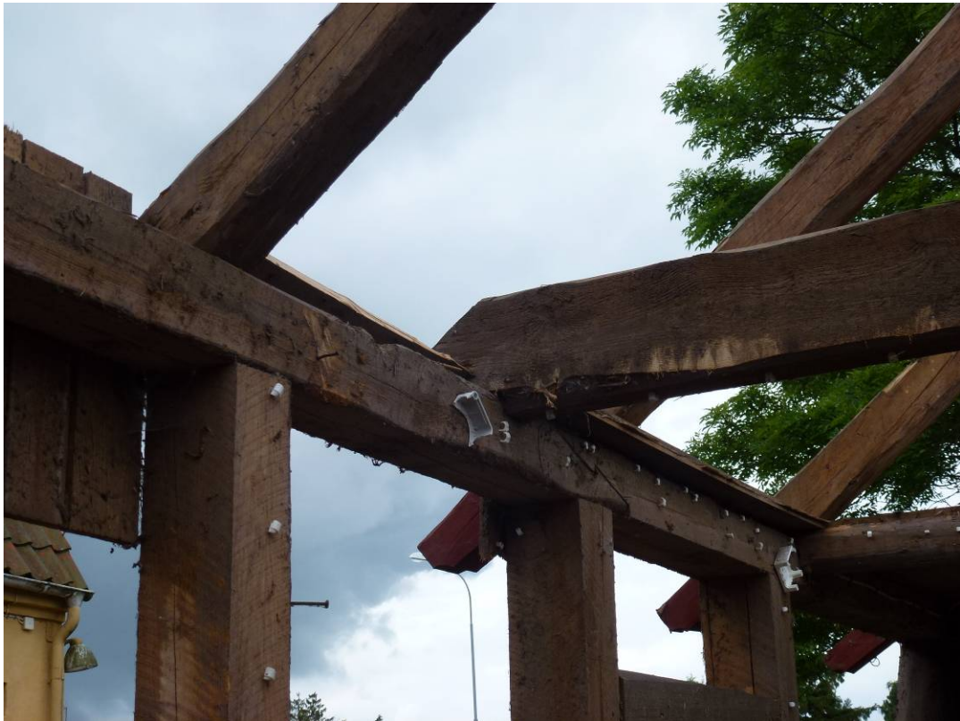
Stommen är frigjord, före rivningen. Hammarband, takbjälke och takstol.
