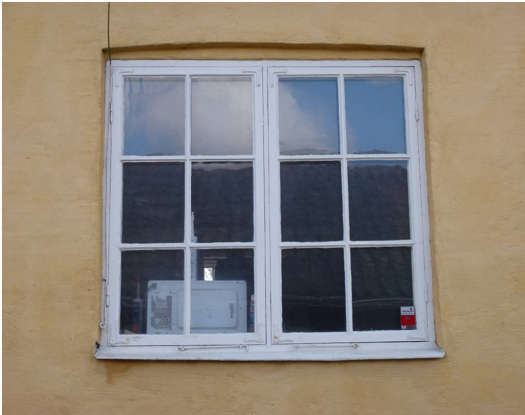
Före åtgärder bostadshuset. Fönstret som ersattes med dörr.
