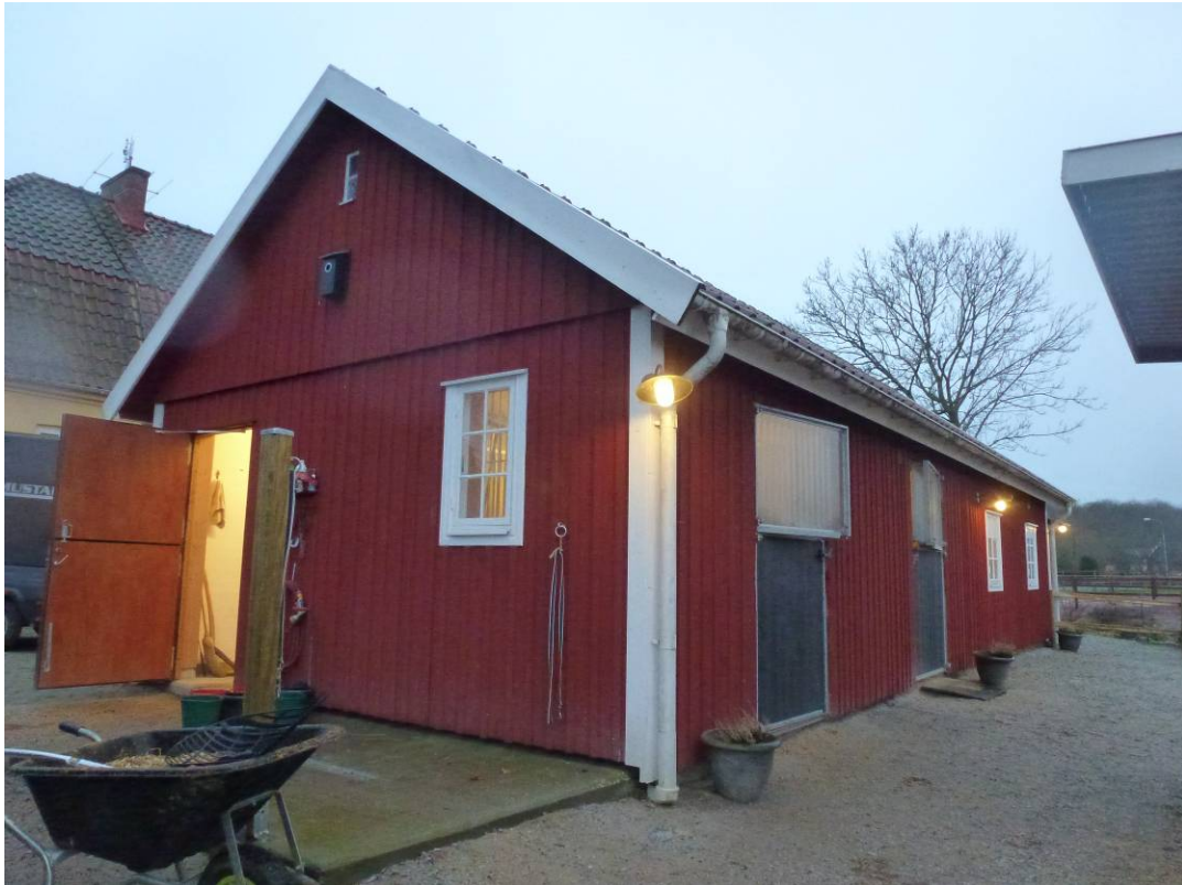
Efter åtgärder. Östra gavelfasaden och norra fasaden med återanvända fönster och nya dörrar.
