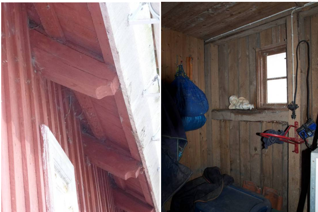
Före åtgärder. Vänster: Taktassar mot söder. Höger: Ekonomibyggnaden interiör.
