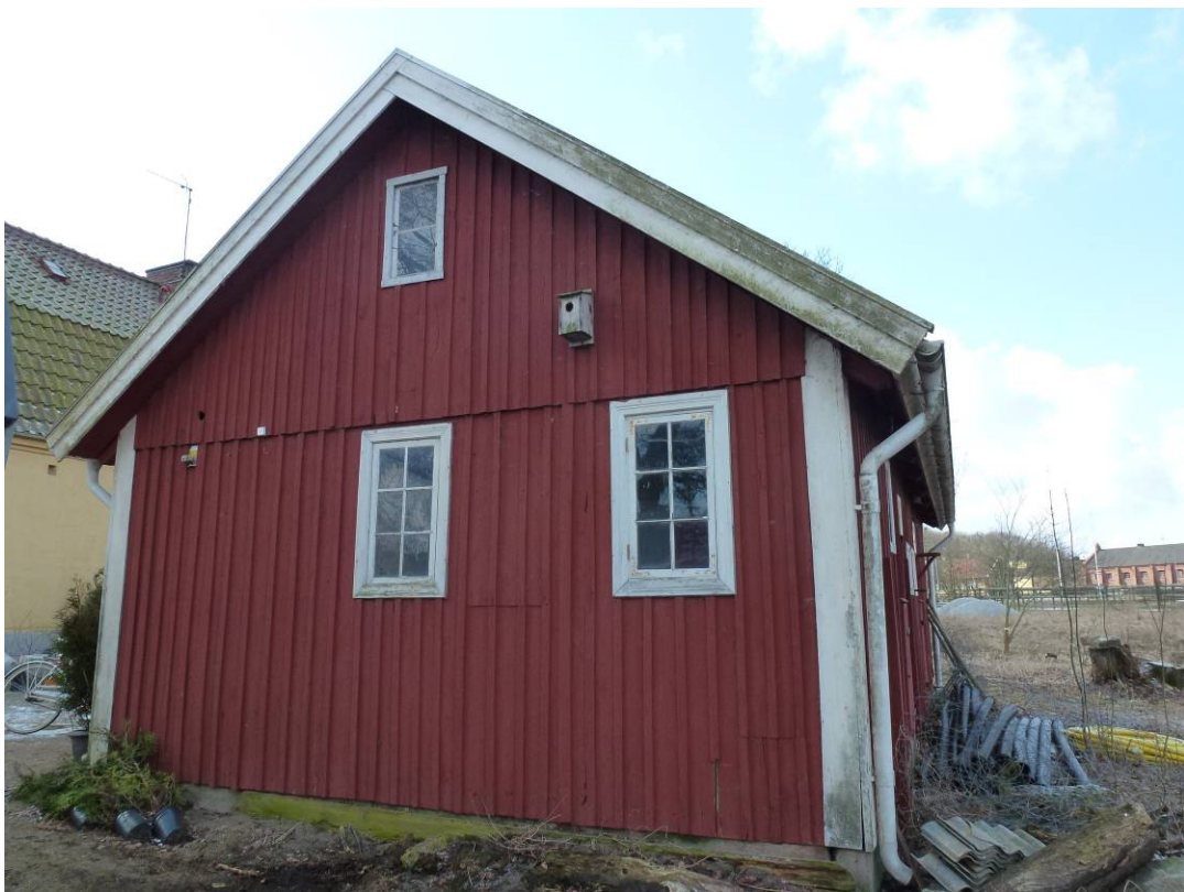
Före åtgärder. Östra gavelfasaden.
