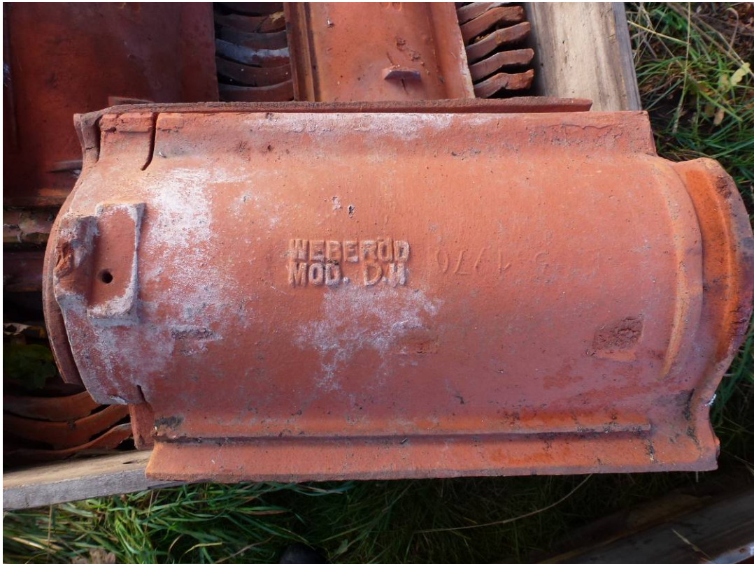
Befintliga tegelpannor som återlagts.
