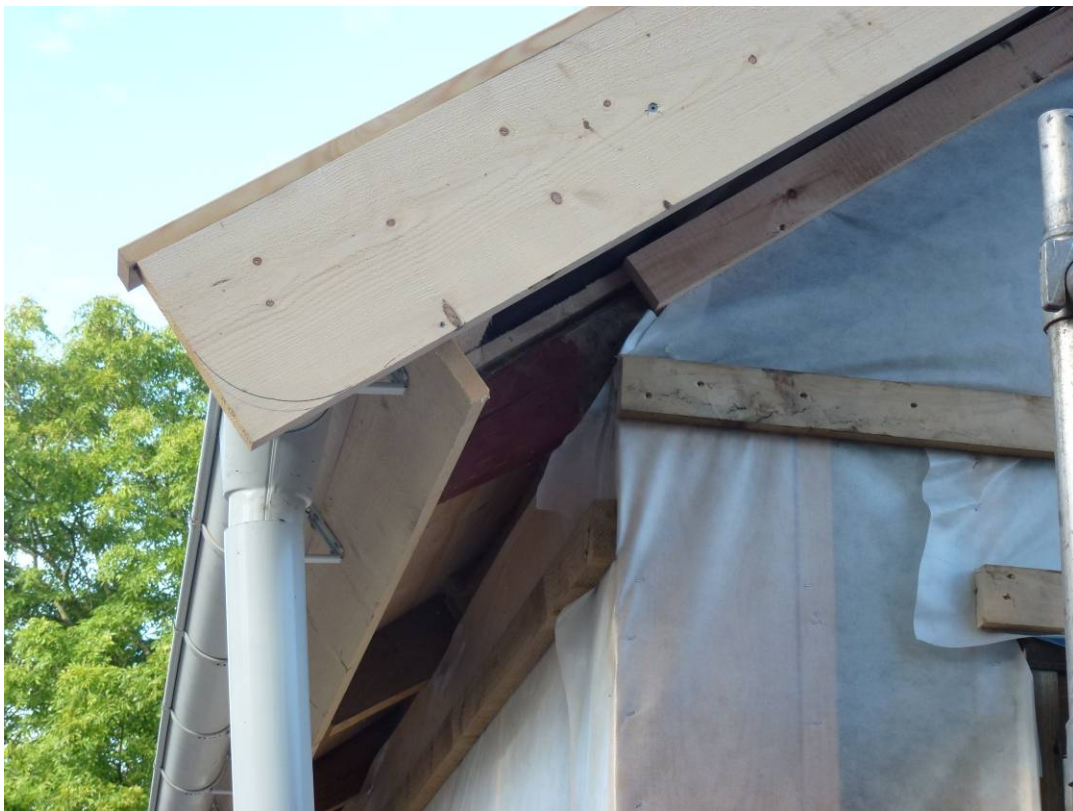
Under arbete med ny stomme.
