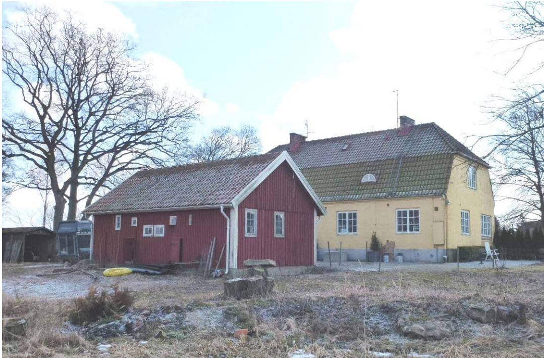
Före åtgärder. Ekonomibyggnaden och bostadshuset sett från gårdssidan och norr.
