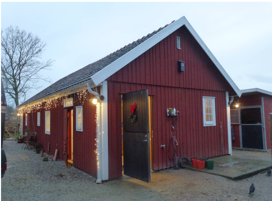
Efter åtgärder. Östra gavelfasaden med två återanvända fönster. Södra fasaden med återanvända dörrar och fönster samt ett nytt fönster.
