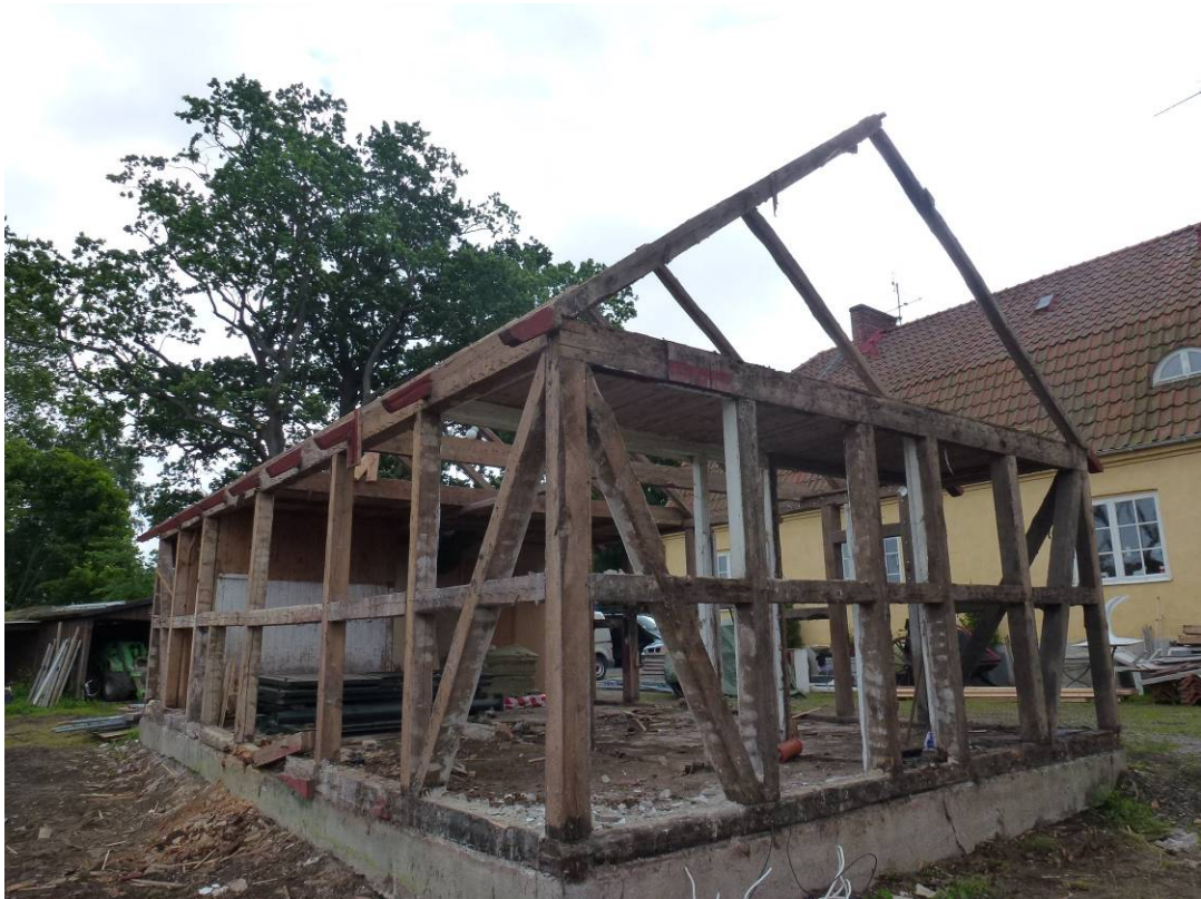
Stommen är frigjord, före rivningen. Norra och västra sidan.
