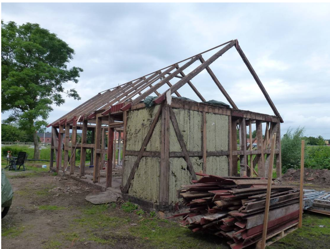
Stommen är frigjord, före rivningen. Södra och östra sidan.
