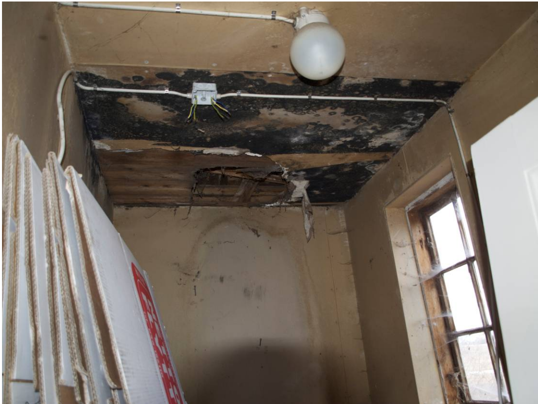
Före åtgärder. Ekonomibyggnaden. Nordöstra rummet var skivklätt och isolerat.
