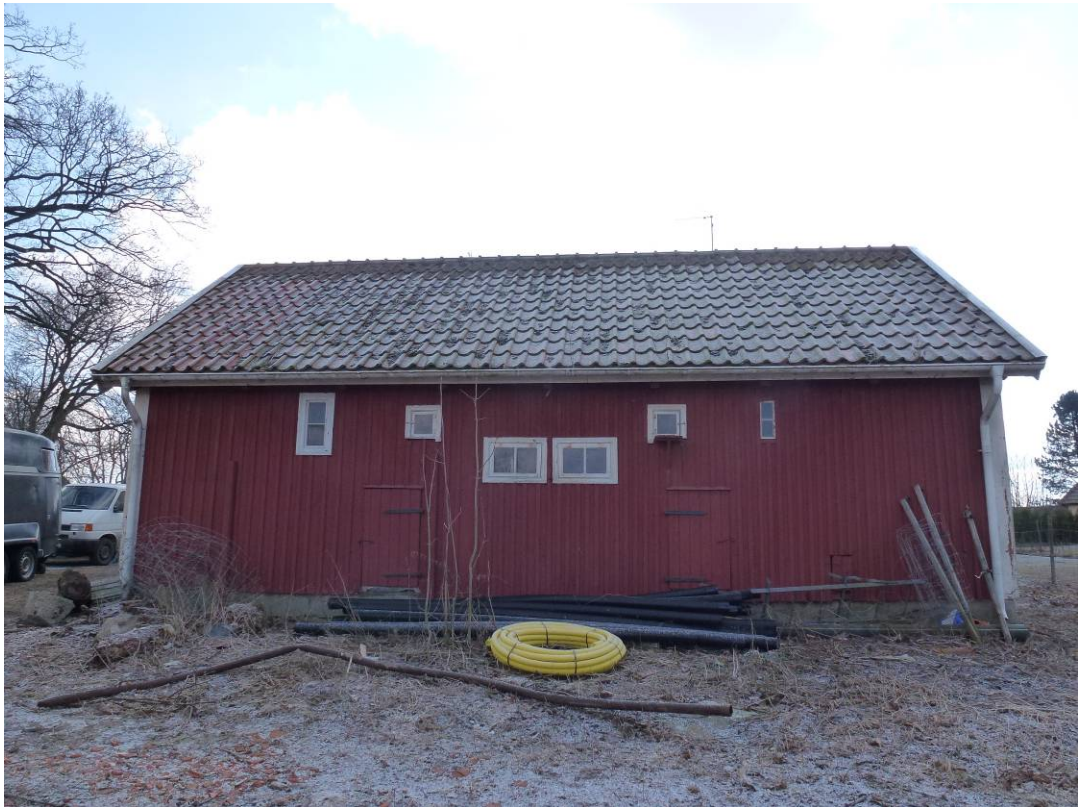
Före åtgärder. Norra fasaden.
