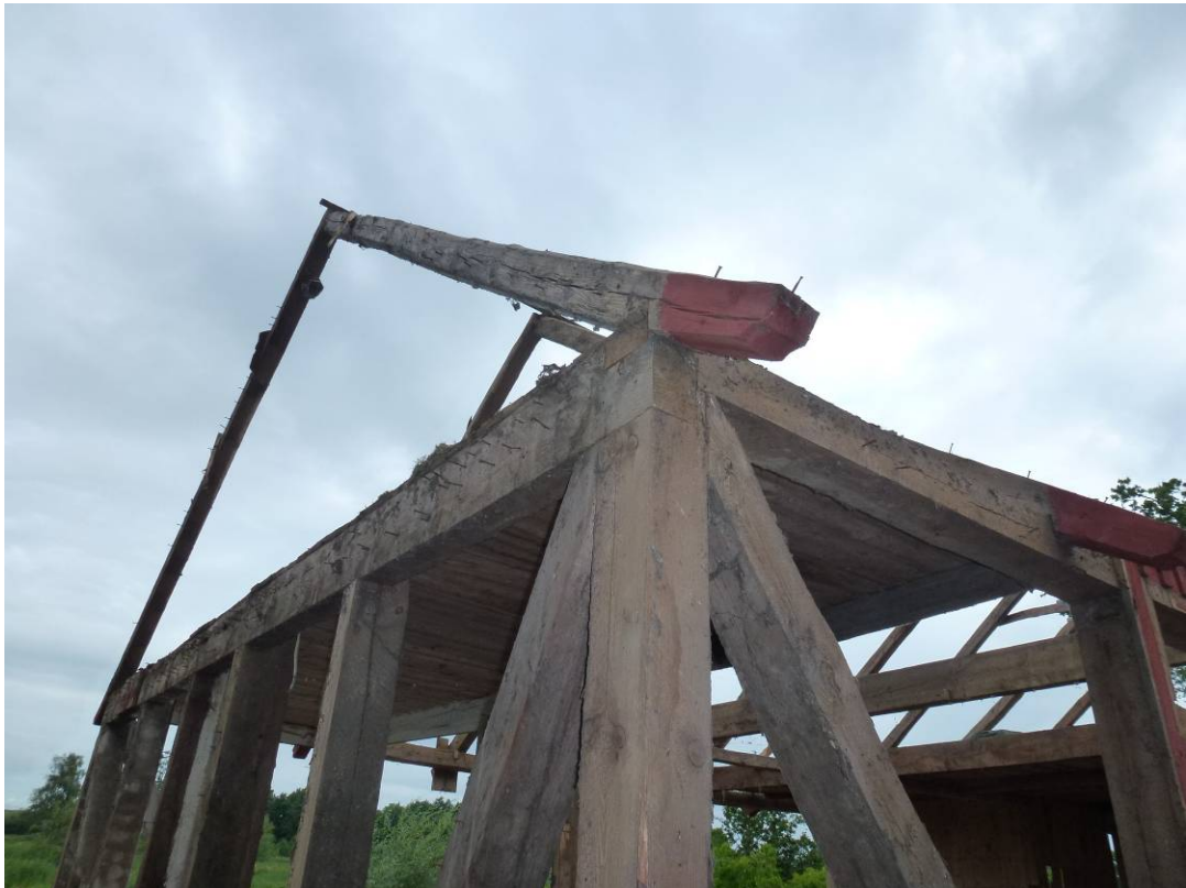
Stommen är frigjord, före rivningen. Västra gaveln.
