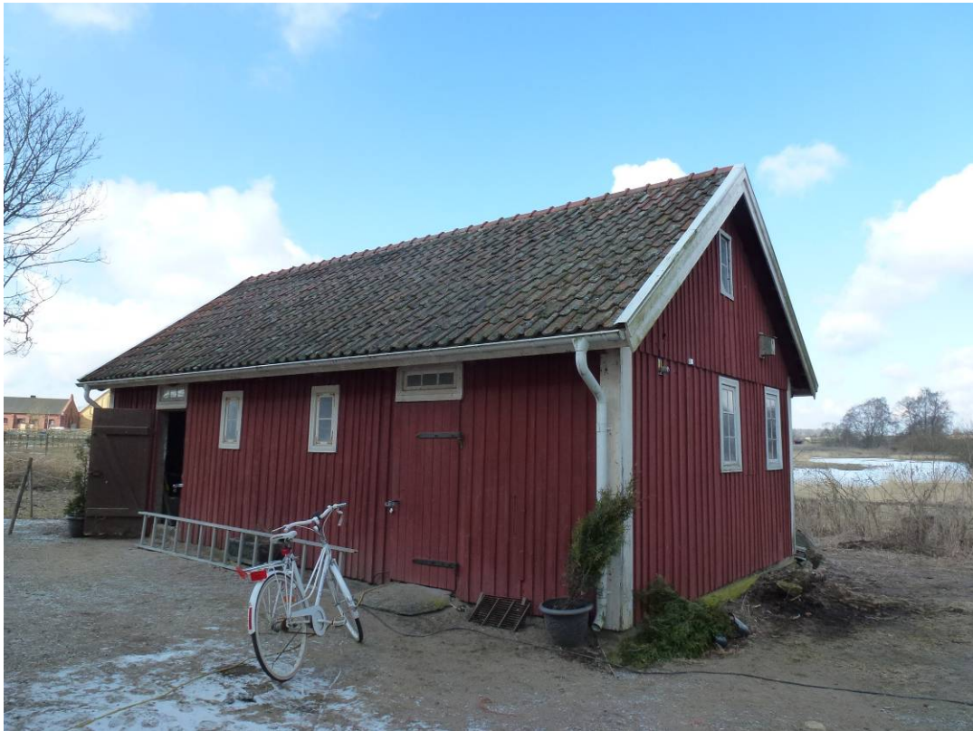
Före åtgärder. Södra fasaden och östra gavelfasaden.
