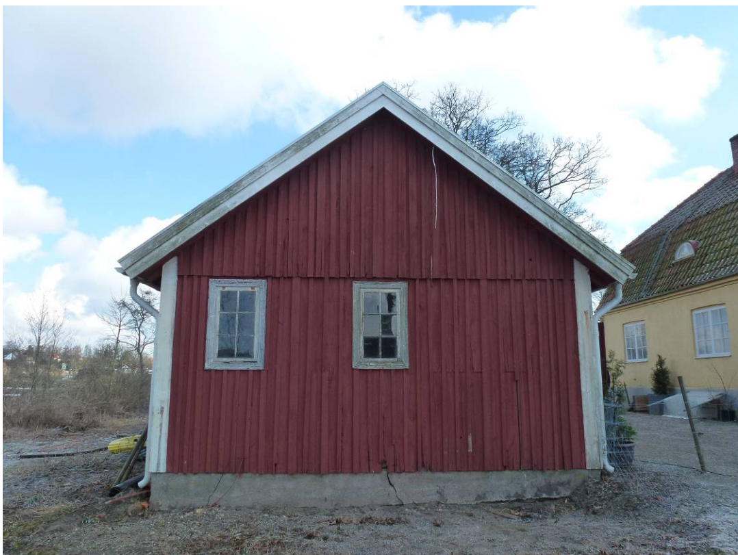
Före åtgärder. Västra fasaden.
