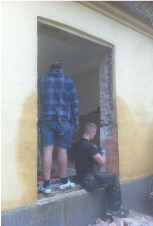
Vänster: Under arbete, håltagning i fasaden inför inmontering av ny dörr. Höger: Efter åtgärder. Fönsterdörren är inmonterad. Återstår att slutstryka dörr och gångjärn samt dörrsmyn.
