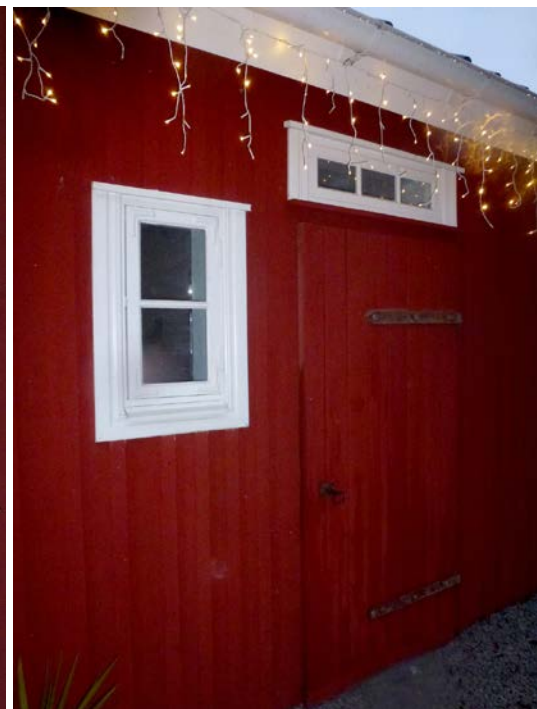
Efter åtgärderna. Återanvända dörrar och fönster med profilerade foder Locklistpanel i varierade bredder.
