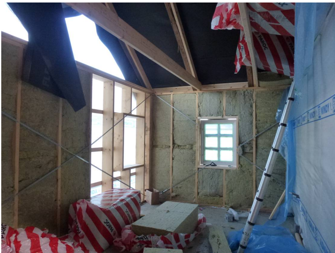
Under arbete med ny stomme. Interiör. De gamla takstolarna återanvändes och kompletterades i tillbyggnaden.
