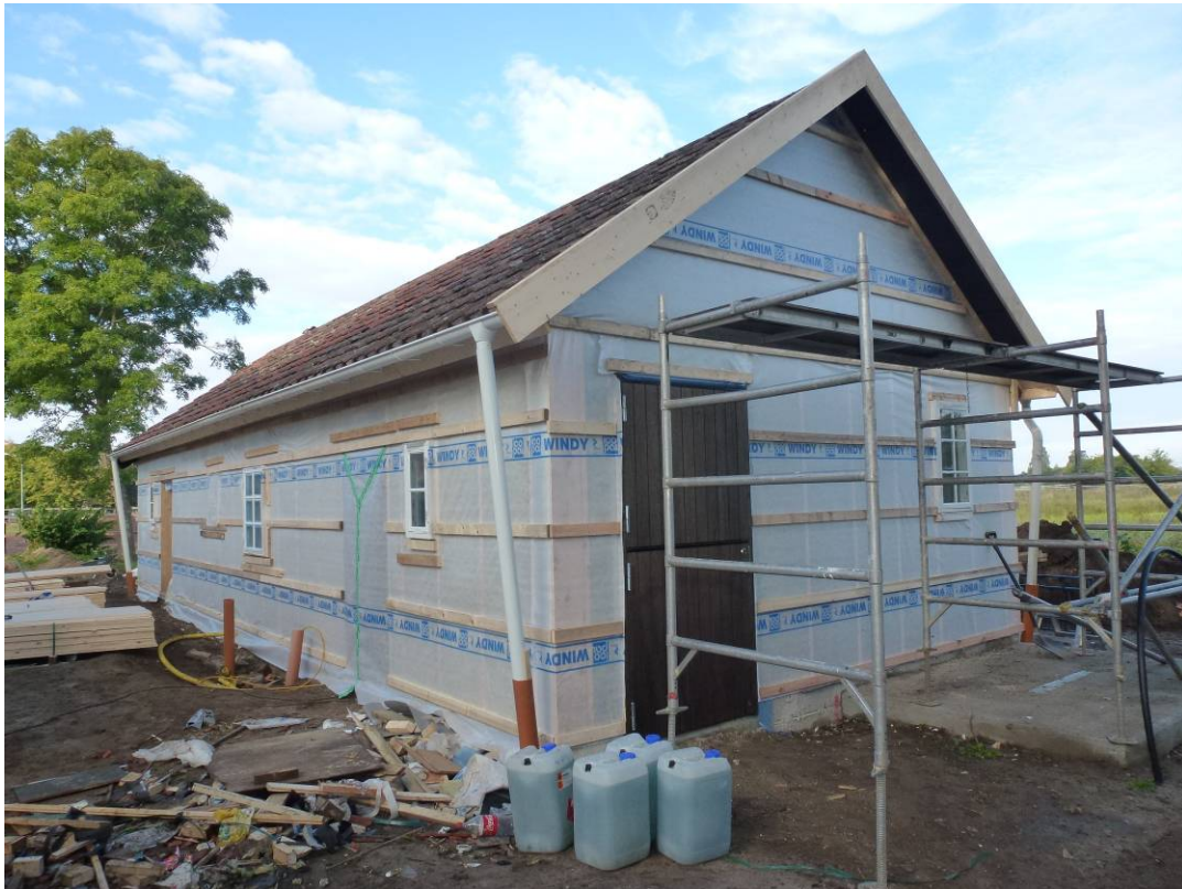
Under arbete med ny stomme. Södra och östra fasaderna.
