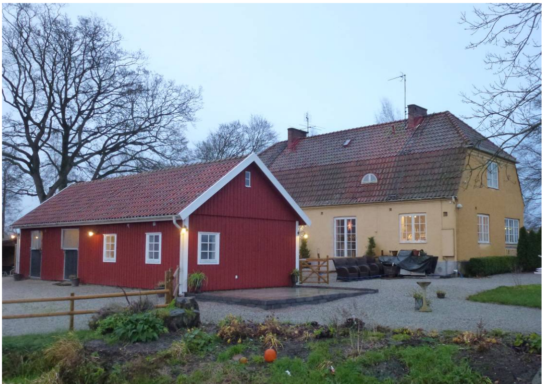
Efter åtgärder. Samma vy som ovan.
