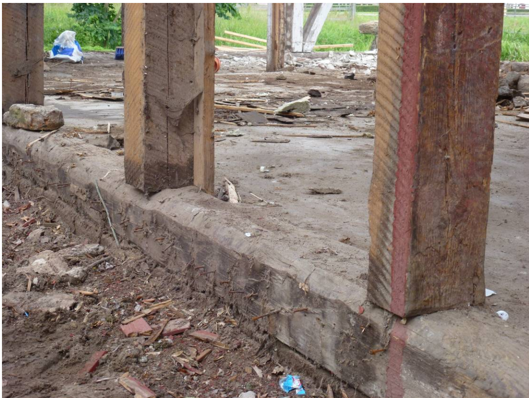
Stommen är frigjord, före rivningen. Bilad syll och sågade stolpar. Syllen var upprutten på undersidan där den legat dikt mot grundplattan.
