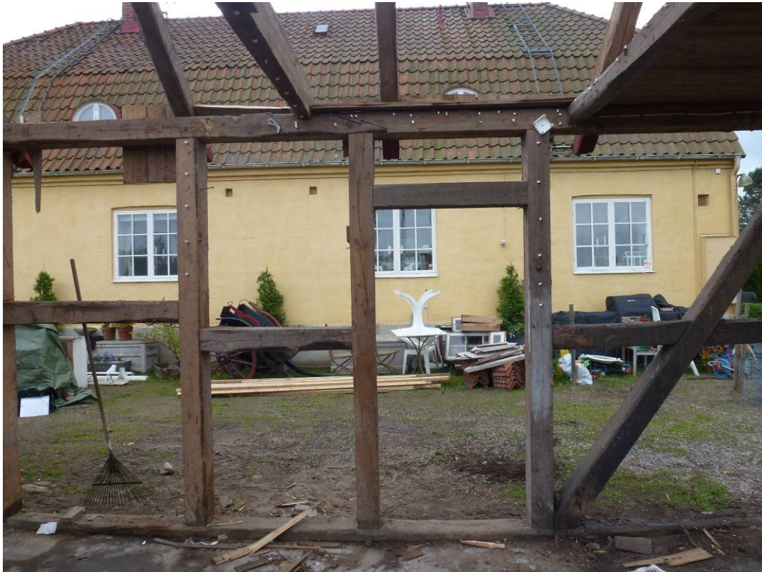
Stommen är frigjord, före rivningen.
