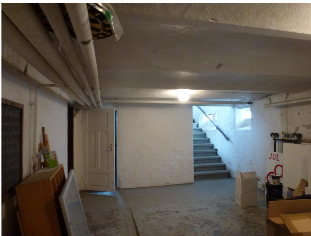
I bjälklaget mellan källare och bottenvåningen kan de tidstypiska bremervalven ses.
