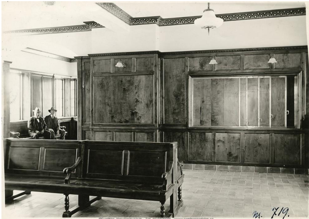
Interiörbild från den då nyligen ombyggda väntsalen i stationen. Boaseringen på väggarna är troligen utförda i lackerad kryssfaner. Skjutluckorna till höger i bild innehöll tidtabeller. Idag har en målning satts i skjutpartiet. Bilden är från Järnvägs museet i Gävle.
