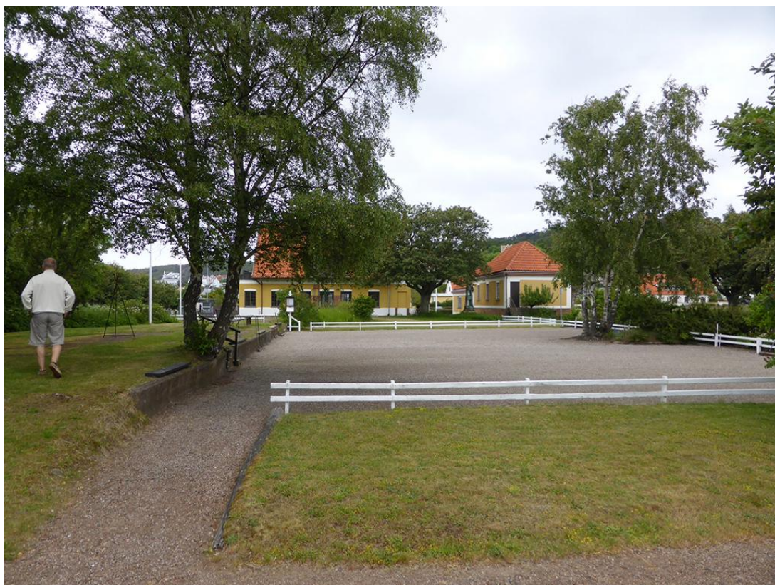
Till vänster i bild syns den gjutna betongperrongen för persontrafiken, spåren löpte fram mot stationsbyggnaden där idag det sentida skär linjen.
