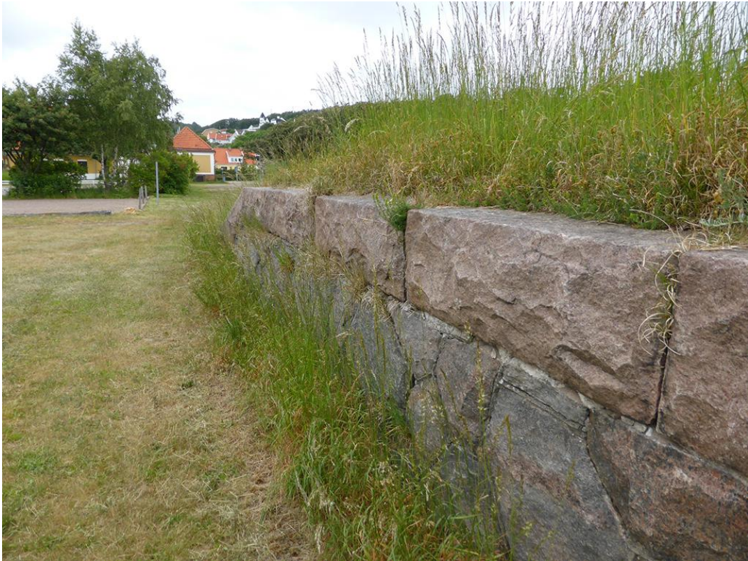
Perrongen för godshantering som ligger längs med spåret är uppförd i tuktade naturstensblock med omsorgsfull tillpassning.
