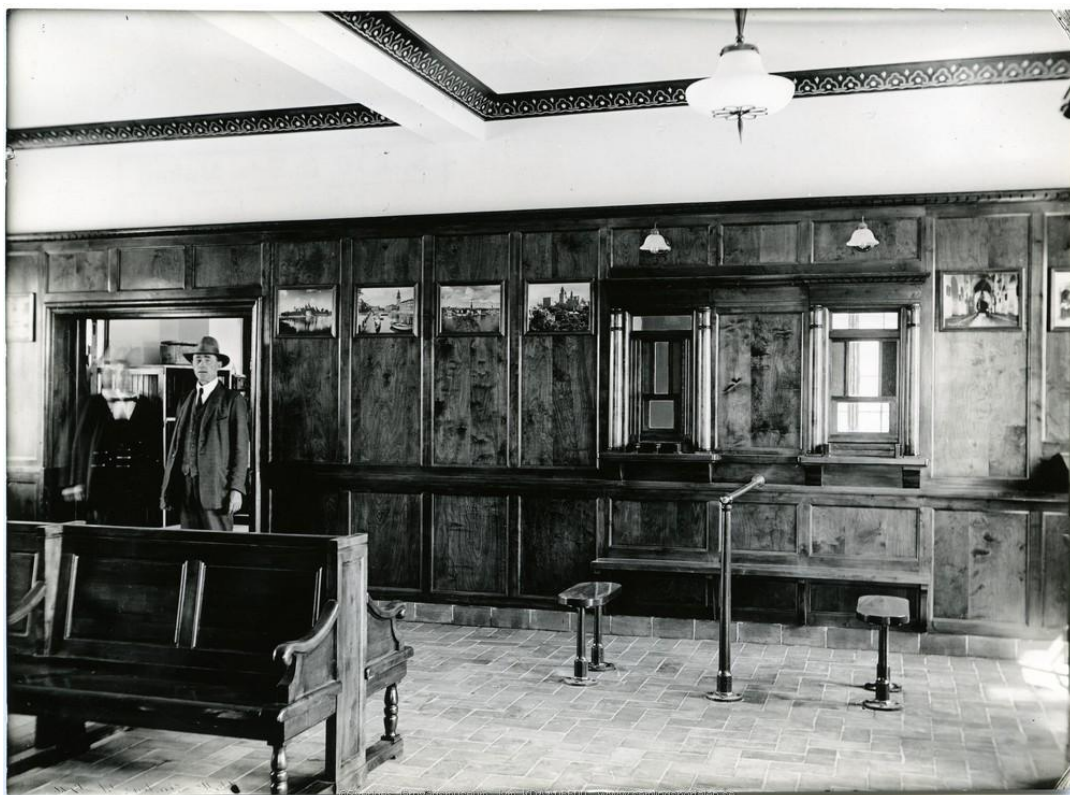
Interiörbild från den då nyligen ombyggda väntsalen i stationen. Idag finns boaseringen till stor del kvar medan biljettluckorna satts igen och delar av bänkarna tagits bort, de lokalt producerade golvplattorna är bevarade. Ett av de låga stöden för bagage framför biljettluckorna är bevarade. Järnvägs museet i Gävle.
