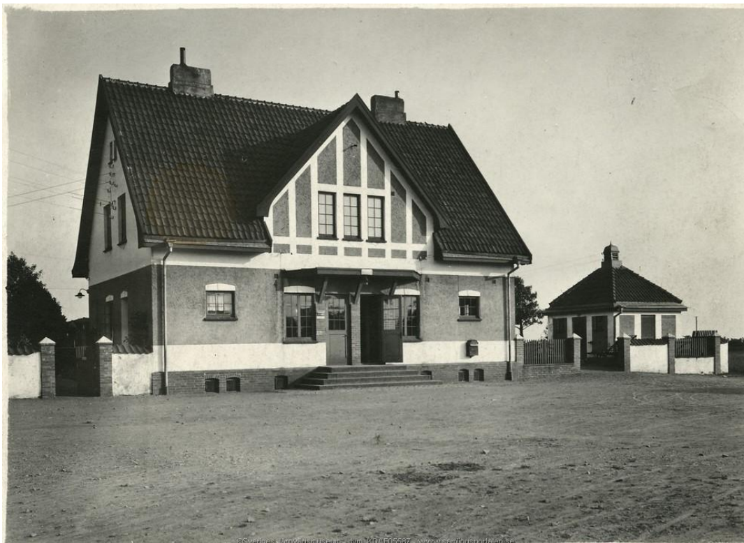
Foto från tiden före ombyggnaden 1927, som visar att huvudentrén ändrats något, murpelaren som skiljer dörrarna åt på bilden togs bort 1927 och ersattes med en dubbeldörr. Järnvägmuseet i Gävle.
