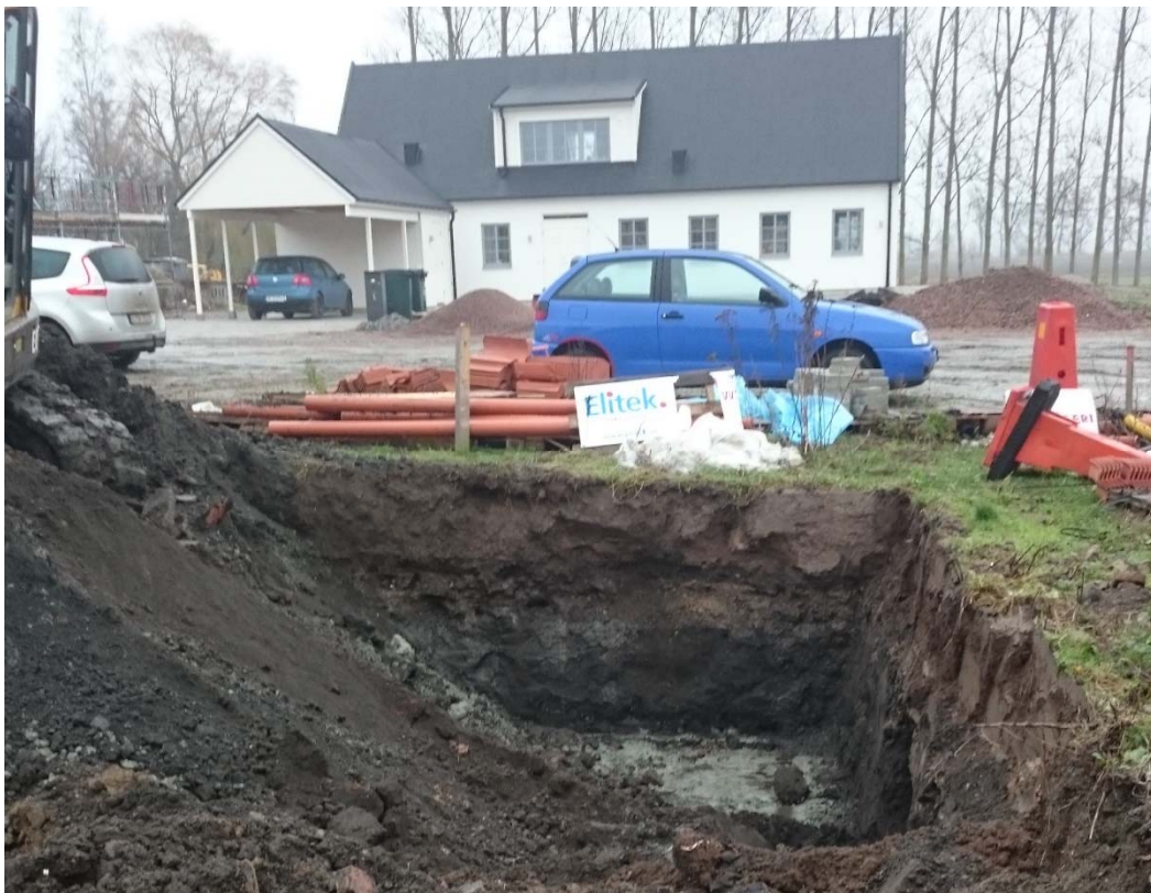
Figur 6. Stora Råby 34:39. Ytan för huskroppen schaktades av ned till morän, tvärt emot Länsstyrelsens beslut på ett schaktningsdjup om 0,50 m. Längst i söder var schaktdjupet 1,70 m. Centralt i schaktet fanns en stor dumphög med omrörda kulturlager. Fotografiet taget från väster.
