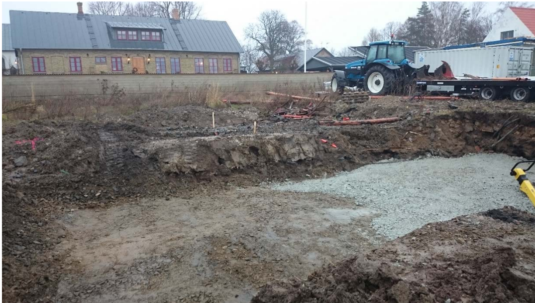
Figur 5. Stora Råby 34:39. Ytan för huskroppen schaktades av ned till morän, tvärt emot Länsstyrelsens beslut på ett schaktningsdjup om 0,50 m. På delar av ytan låg makadam vilket försvårade den antikvariska dokumentationen då schaktningen uppdagades. Fotografiet taget från söder.
