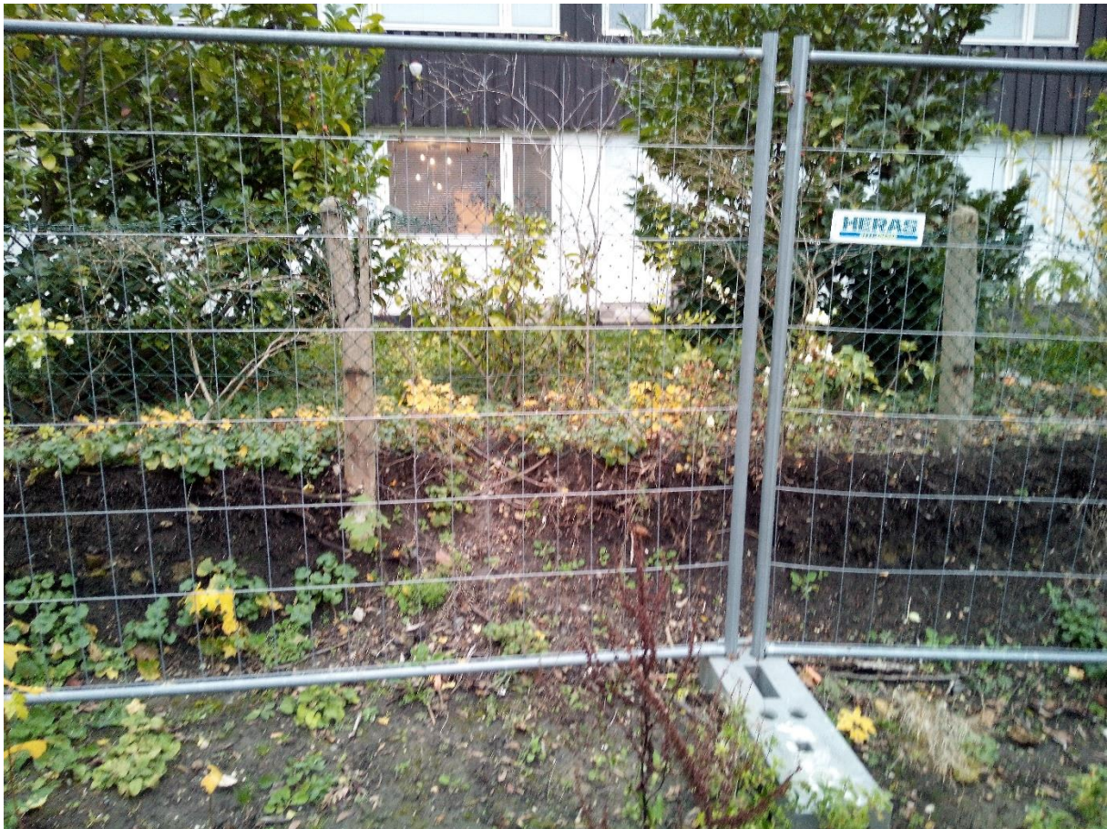
Figur 11. Del av den norra schaktkanten mot fastigheten Gylleholm 15.
