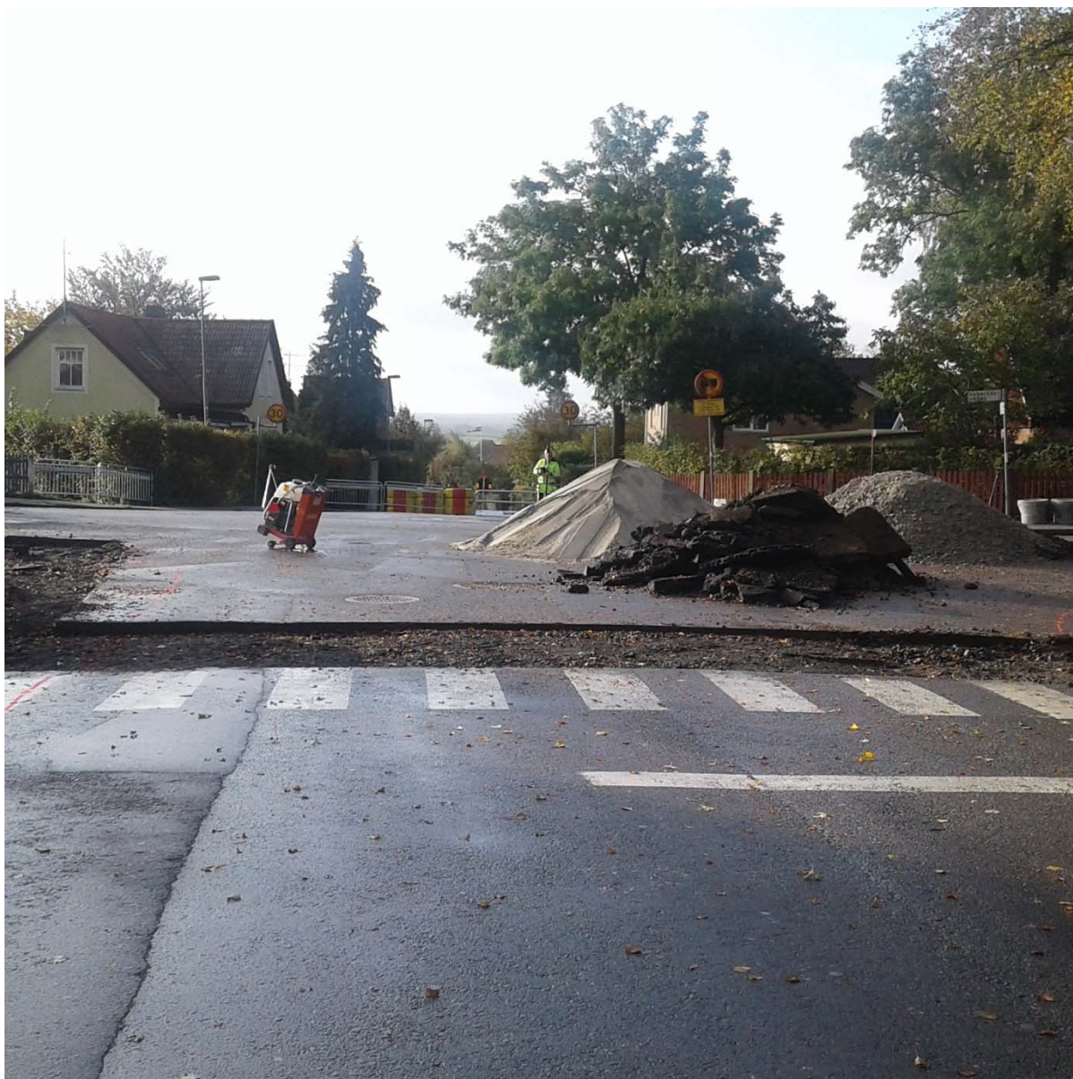
Figur 3. Översiktsbild från norr. Arbetet med att sätta ut fixpunkter har påbörjats. I bakgrunden syns hur mycket topografin sluttar mot söder.
