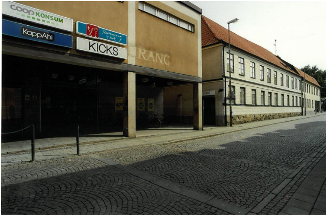
Figur 5. Östra Mårtensgatan och bebyggelsen i kvarteret Brunius. De äldre byggnaderna till höger i bild är de som på innergården byggs till med ny byggnad utförd med alternativ grundläggning. Foto Claes Wahlöö 2003, Kulturens arkiv L3636:16.
