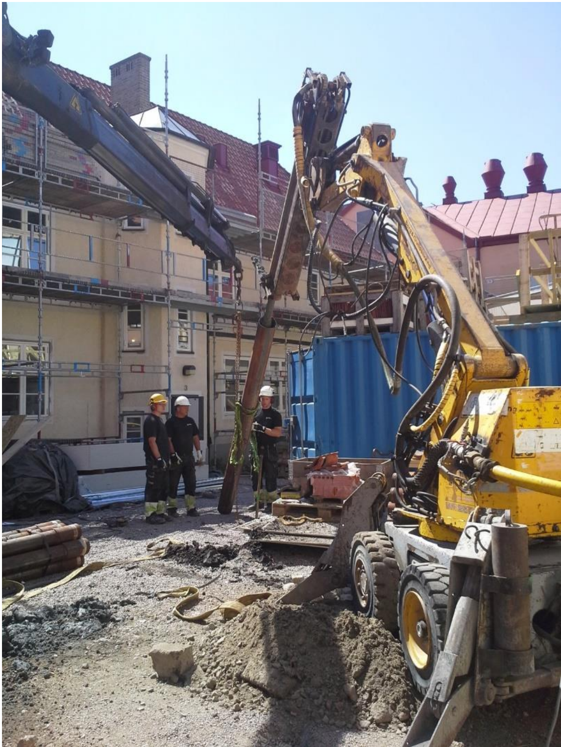
Figur 7. Borring av foderrör inför borring av stålplålar i rören.
