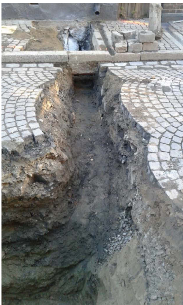
Figur 10. Fotografi över schaktet på Västergatan. Sett åt norr.
