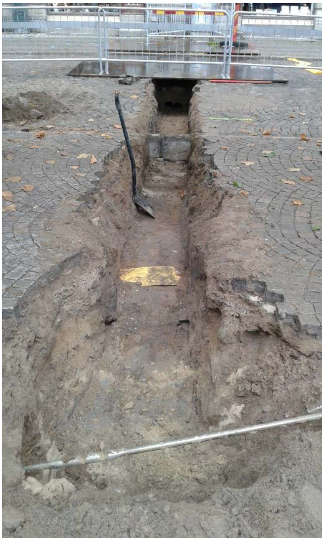
Figur 16. Fotografi över det större schaktet på Clemenstorget sett åt öster.
