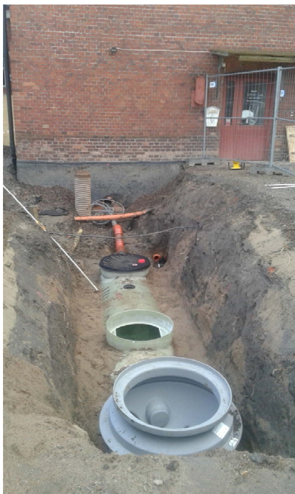
Figur 3. Bild över schaktet med fettavskiljaren på plats.
