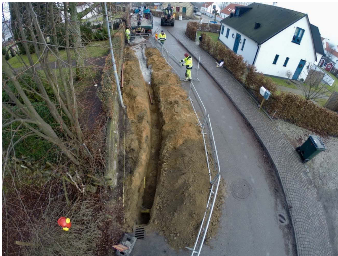
Figur 4. Översikt av schaktet på Stora Råby Byaväg. Fotografiet taget från väster.
