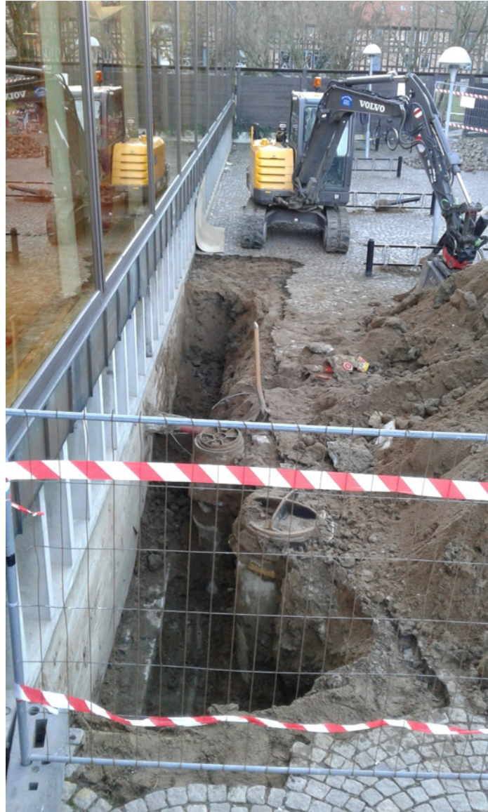
Figur 4. Översikt över västra delen av schaktet.
