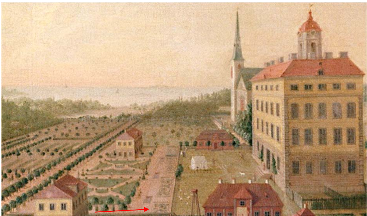
Figur 9. På målningen från år 1751 som skall visa 1740 års parkanläggning kan en stödmur anas (röd pil). Möjligen är det tegel som har använts för uppbyggnaden då en frostskadad tegelmur påträffades i Schakt 2 under 2019 års dokumentation.
