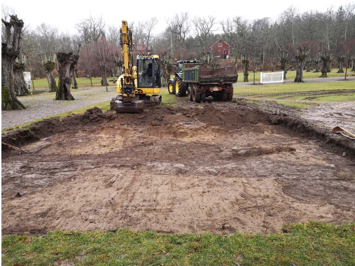
Figur 11. Schakt 3 där gångar och rundel schaktas fram. Brunbeige sand låg som ett täckande underlag över hela ytan. Ovanpå och delvis nedgrävt framkom ett brungrått grus som var något mer grovkornigt än underlaget. Rundeln låg som högsta punkt dit gångarna löpte stigande. Fotografiet taget från norr.
