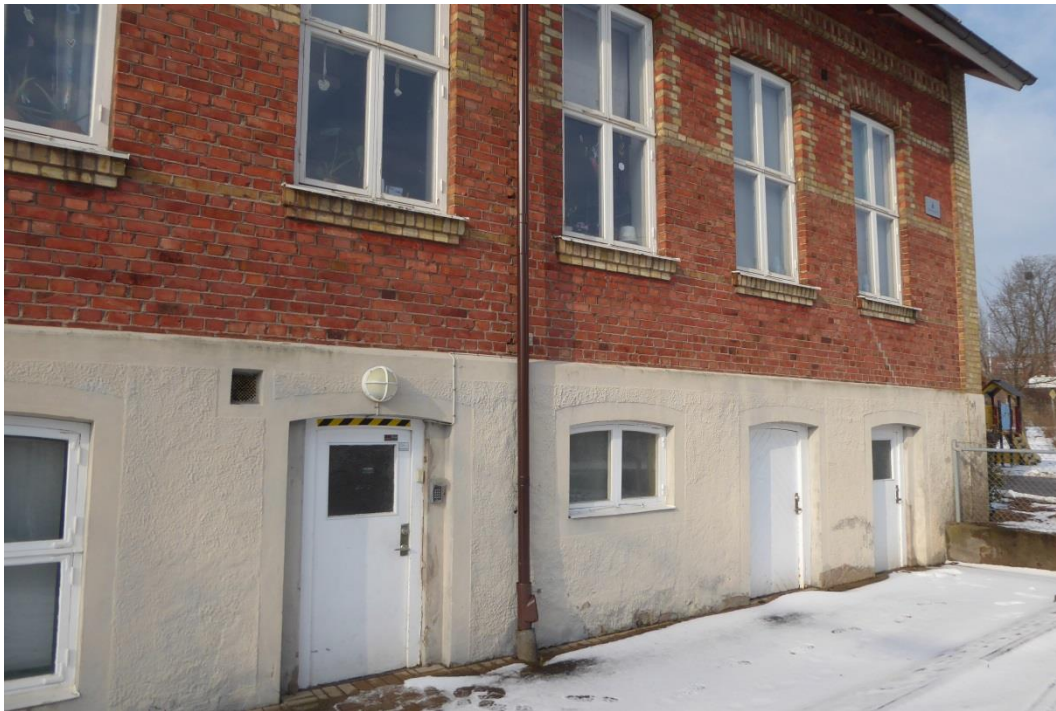
Före åtgärder ovan, efter åtgärder nedan. Dörrar i sockelvåningen är ersatta och fönstren underhållna. Sockeln är målad, vita omfattningar i likhet med äldre fotografi.
