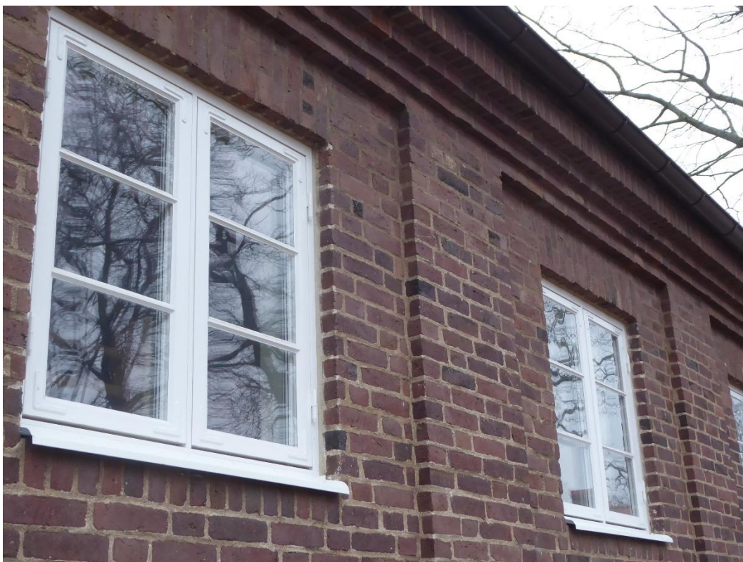
Efter åtgärder. Exempel på nya fönster och fönsterbleck, bruksfog mellan fönster och fasad, partiella små lagningar av fog.
