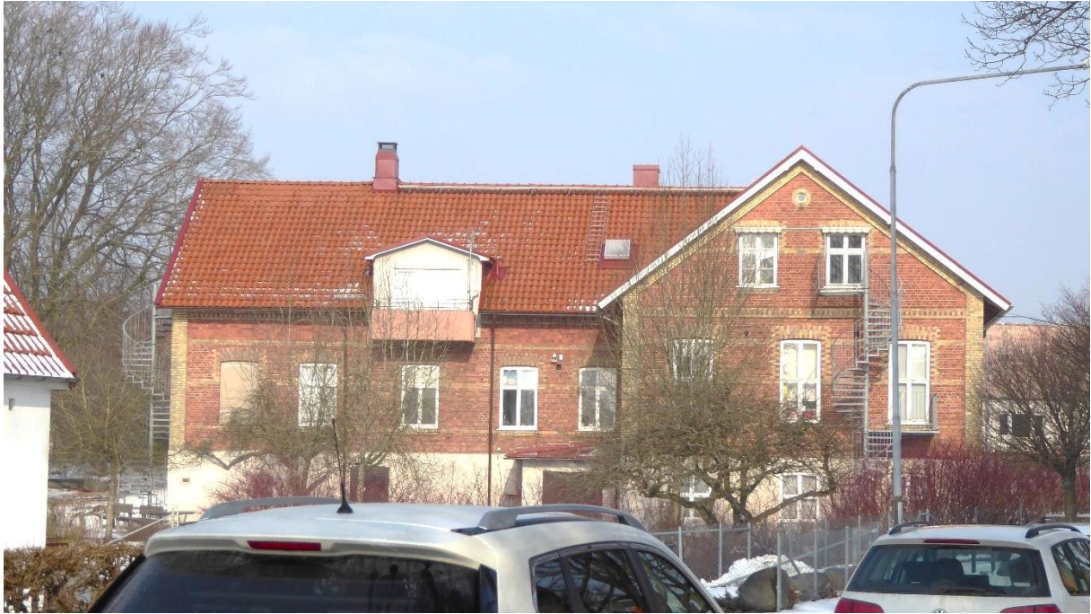
Före åtgärder ovan, efter åtgärder nedan. Fönster i fasad är nya, observera blindfönster längst till vänster i fasaden. Nya takpannor, plåtgärningar, avvattning.
