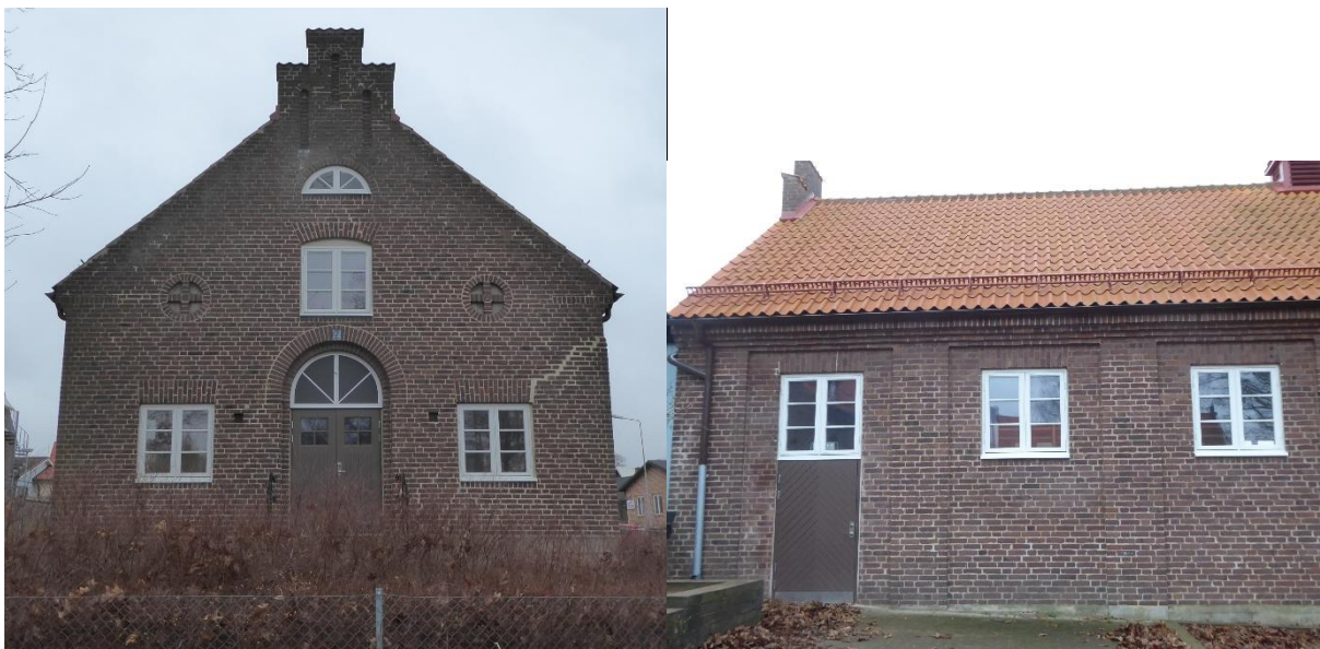
Efter åtgärder. Vänster: Västra gaveln. Höger: ny dörr, fönster, taktäckning norra långsidan.
