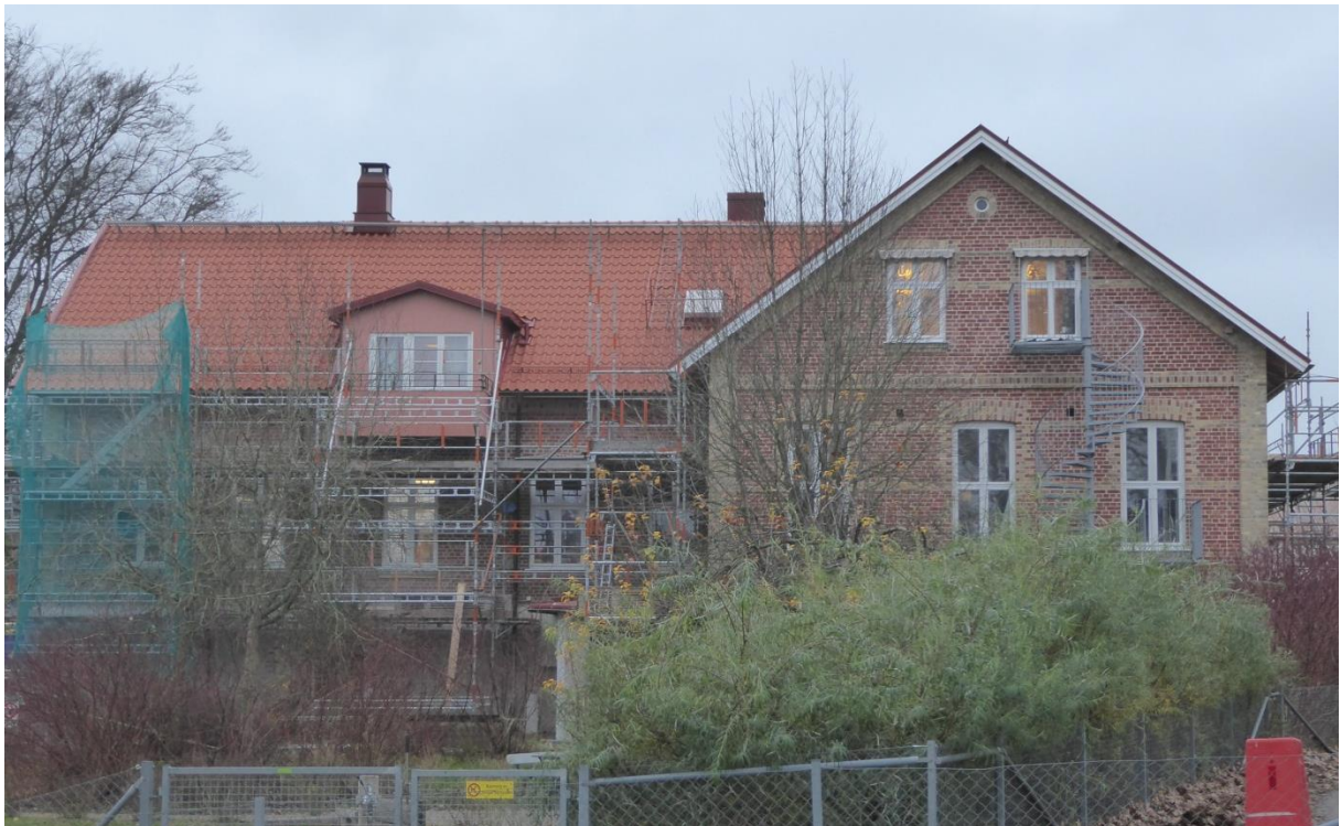
Före åtgärder ovan, efter åtgärder nedan. Fönster i fasad är nya, observera blindfönster längst till vänster i fasaden. Nya takpannor, plåtgärningar, avvattning.
