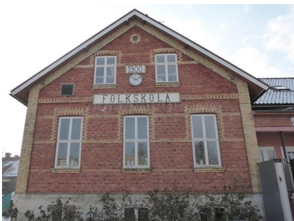
Före åtgärder ovan, efter åtgärder nedan. Fönster i fasad är nya och underhållna i sockelvåningen.
