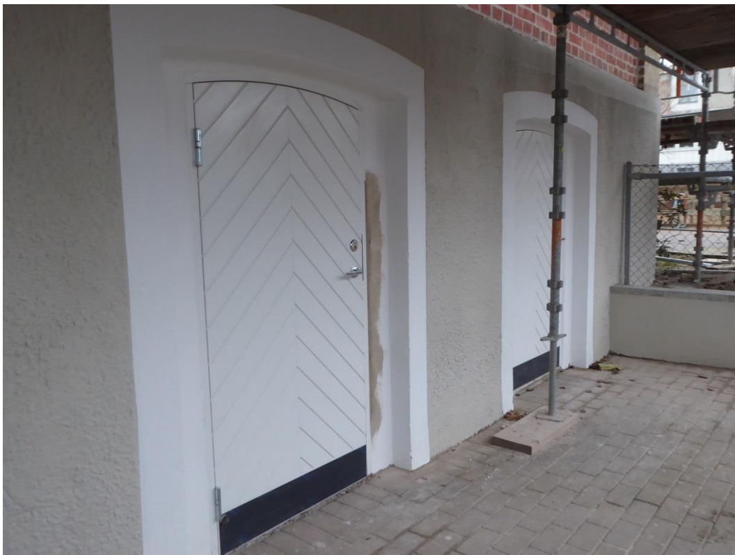
Nya dörrar i sockelvåningen, återstår att komplettera målning i omfattning.
