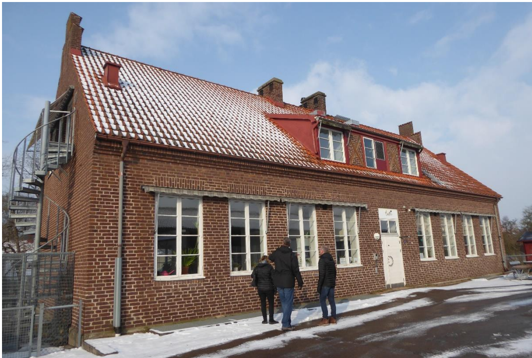
Före åtgärder ovan, efter åtgärder nedan. Dörr, fönster med åtta rutor i fasad, fönster ovan dörr samt i takkupan är nya. Nya takpannor, plåtgärningar, avvattning samt underhållna skorstenar.
