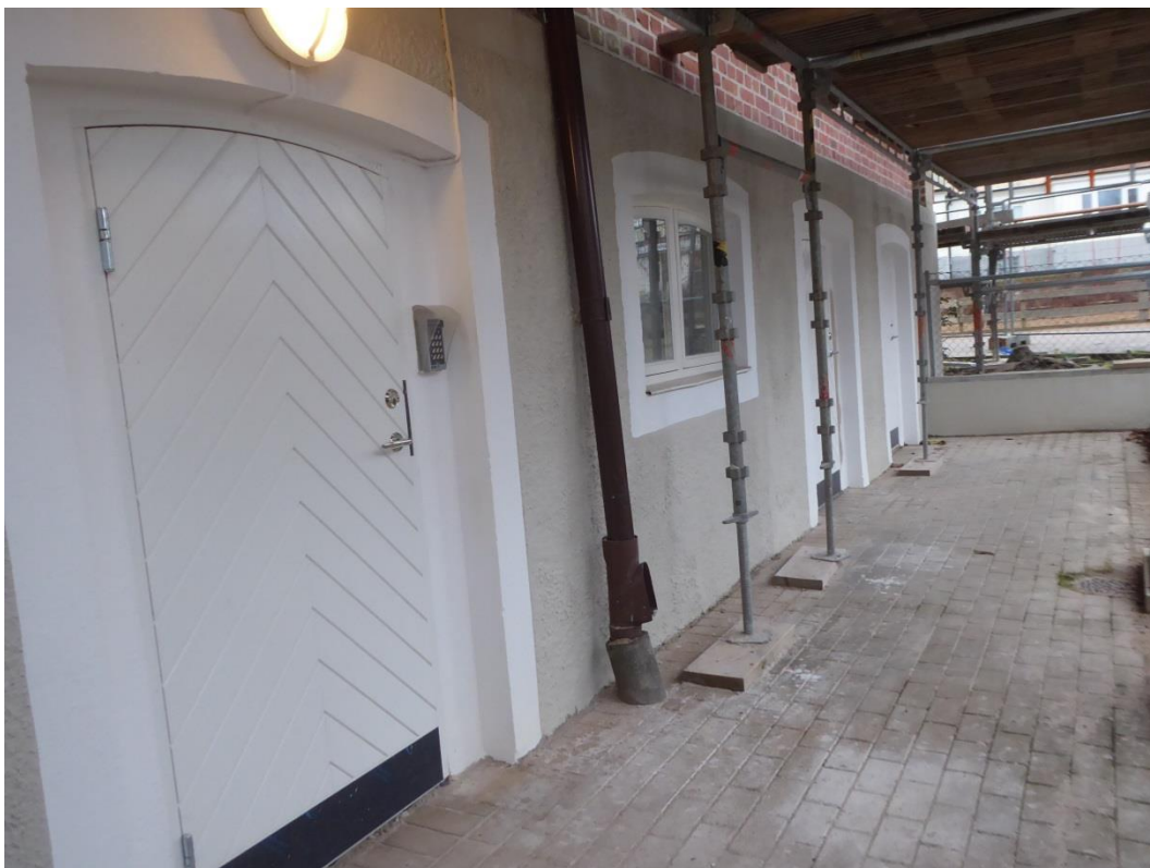
Före åtgärder ovan, efter åtgärder nedan. Dörrar i sockelvåningen är ersatta och fönstren underhållna. Sockeln är målad, vita omfattningar i likhet med äldre fotografi.
