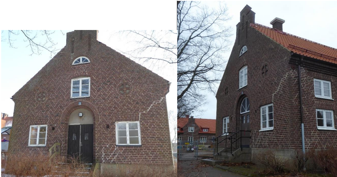
Före åtgärder till vänster, efter åtgärder till höger. Fönster och dörrar förutom lunettfönster i gavel är ersatta. Blindering målad ovan dörren och trappräcke av trä är ersatt med järnräcke
