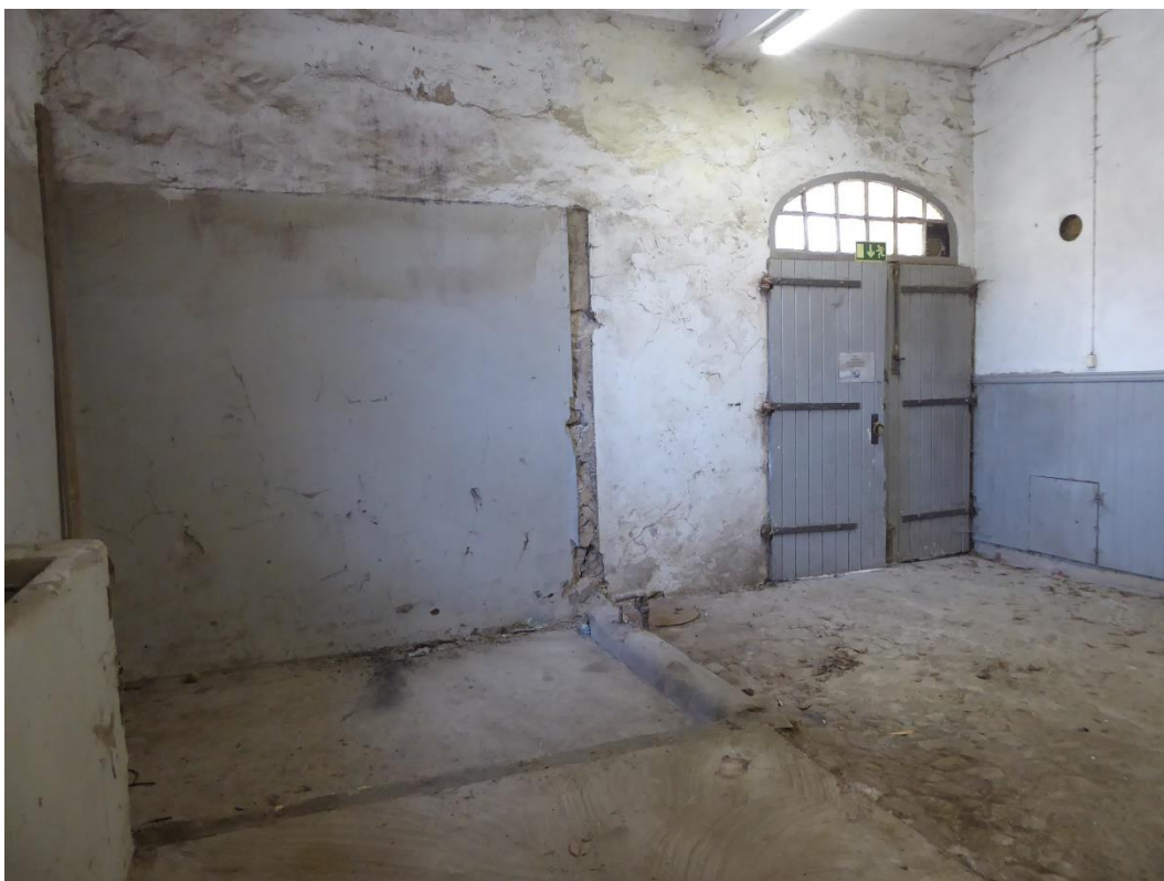
Under arbete. I en vertikal del på norra väggen saknades putsbruk, vilket lagades i. Vy mot norr.
