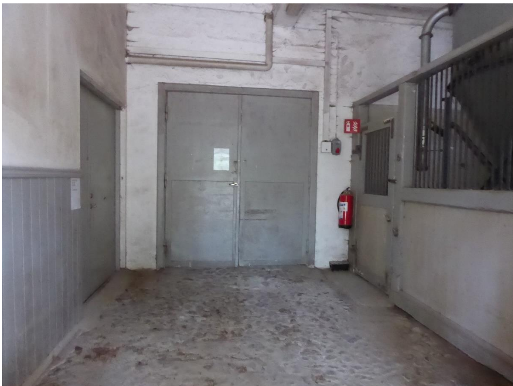
Före åtgärder. Kullerstensgolv och två boxar i Fullblodssallets norra del. Vy mot söder.
