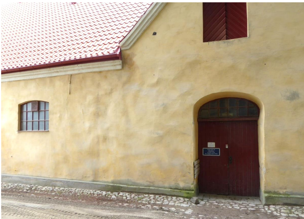
Före åtgärder. Dörren mot norr, i fönsterrutan längst nere till vänster i bild fanns sedan tidigare ett galler.
