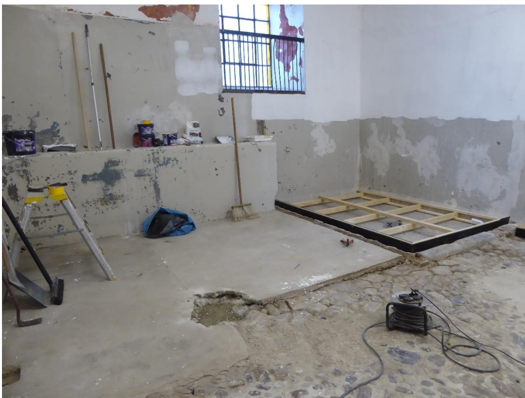
Under arbete. Golvet förbereds för att gjutas på.
