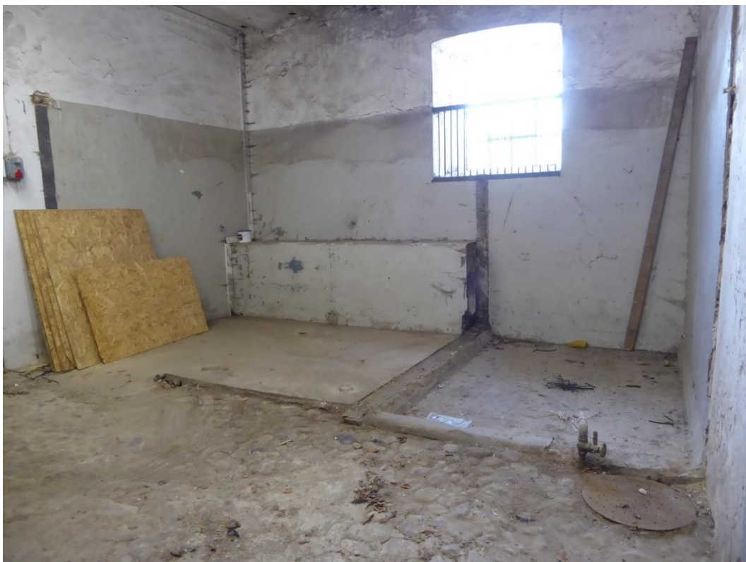
Under arbete. De två äldre boxarna har tagits bort. Notera det försänkta golvet till höger i bild.
