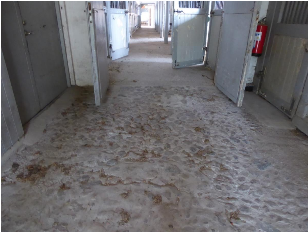
Före åtgärder. Kullerstensgolv och två boxar i Fullblodsstallets norra del. Vy mot söder.
