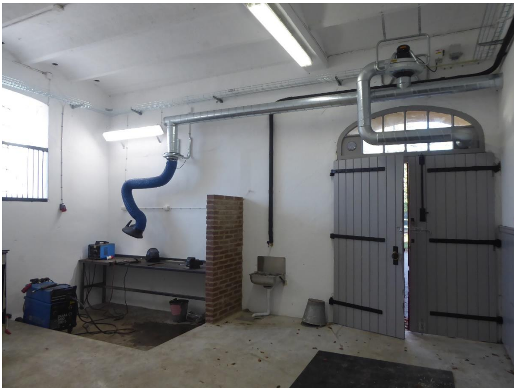
Efter åtgärder. Vy mot nordväst.
