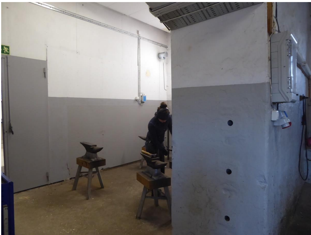
Efter åtgärder. Borttagen sentida box i Norra unghäststallets västra del.
