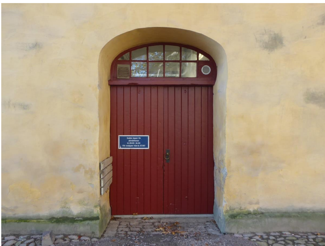
Efter åtgärder. Nytt galler i högra nedre fönsterrutan.
