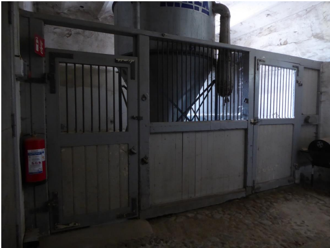
Före åtgärder. Kullerstensgolv och två boxar i Fullblodssallets norra del. Vy mot nordväst.
