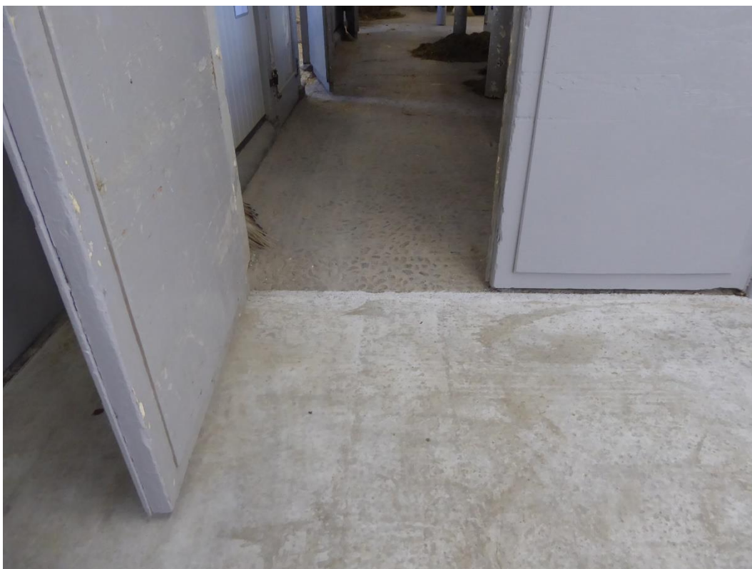
Efter åtgärder. Möte mellan det nygjutna golvet och golvet i Fullblodsstallet.
