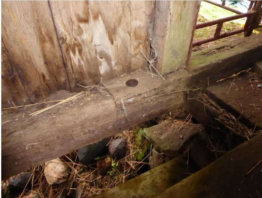
Efter åtgärder. Syllen stabiliserades med smidd spik av kraftig dimension. Inga åtgärder gjordes på virket.
