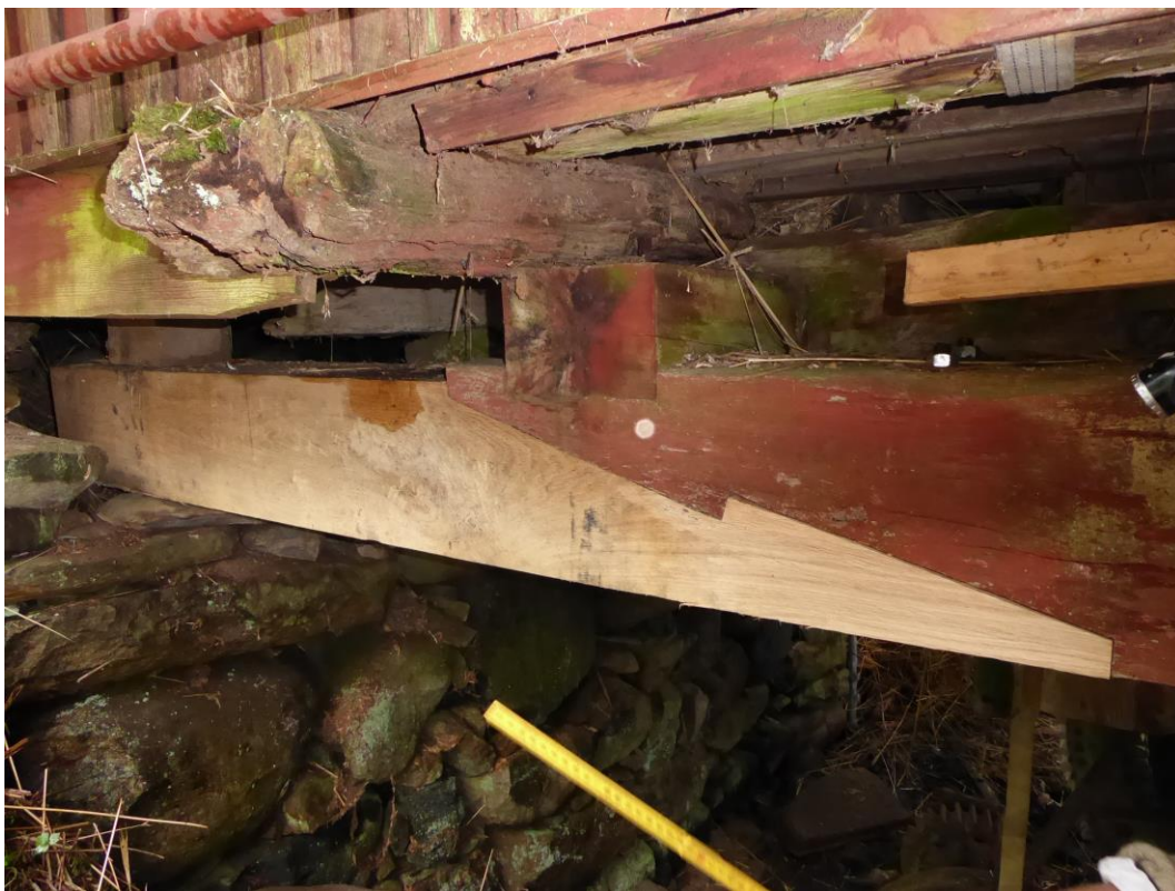
Efter åtgärder. Syll blixtskarvades i och fästes med två genomgående bultar.
