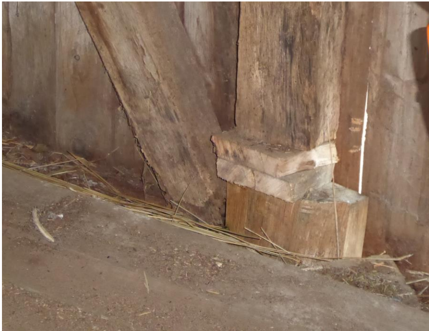
Efter åtgärder. Gliporna stämpades upp så att stolpar och lejd hamnar i rätt nivå. skarvningen är alltså inte traditionellt utförd utan bara tillfällig och ingick inte i projektet, detta bör åtgärdas permanent vid ett senare tillfälle.
