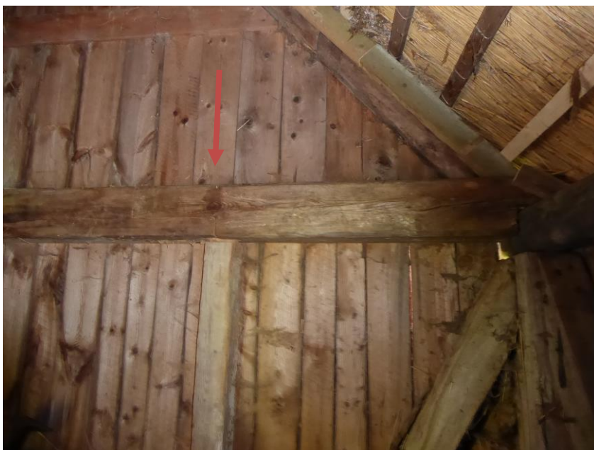
Efter åtgärder. Lejd skarvades i halvt i halvt, glipan mellan stolpen och lejden behölls.
