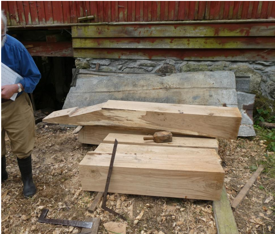
Under arbete. Syllen oxhyvlades.
