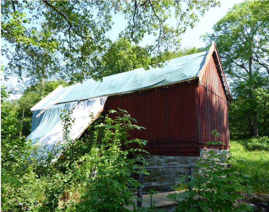
Före åtgärder. Taket är klätt med presenning.
