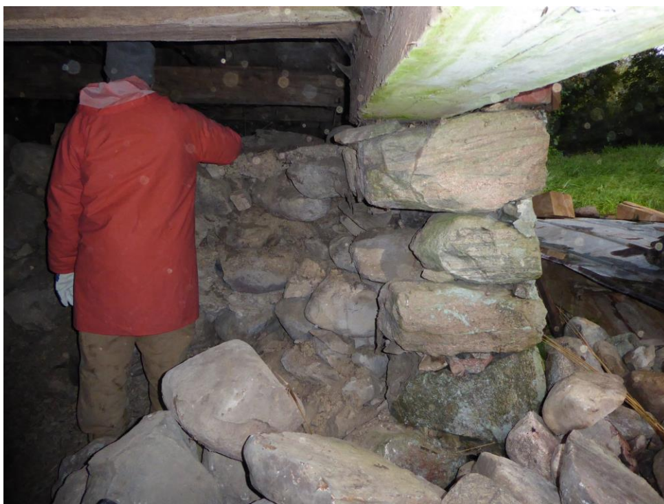
Under åtgärd. När stenen plockades bort visade det sig att delar av muren var fogad med lerbruk.
