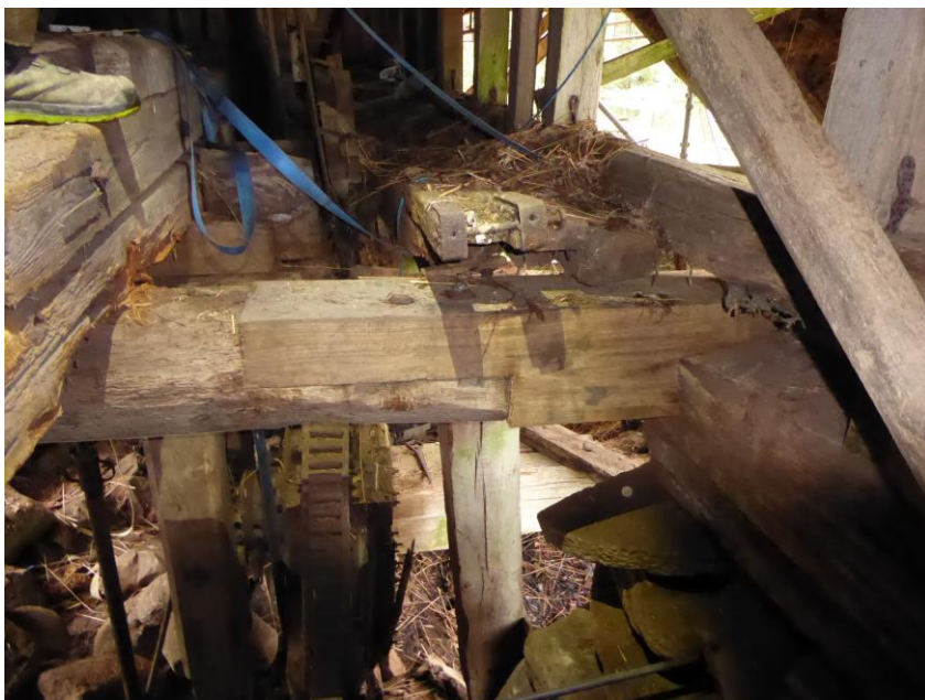
Efter åtgärder. Lejd skarvades i halvt i halvt och fästes med genomgående bult
