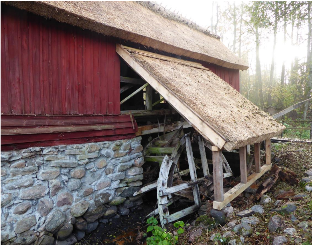
Efter åtgärd. Skärmtaket lades med vass och större delen av stommen ersattes med friskt, äldre virke.
