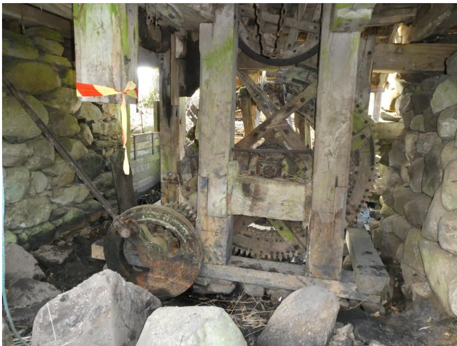
Efter åtgärd. Nya bitar skarvades i stolparna och en underkonstruktion för stolparna att stå på gjordes.
