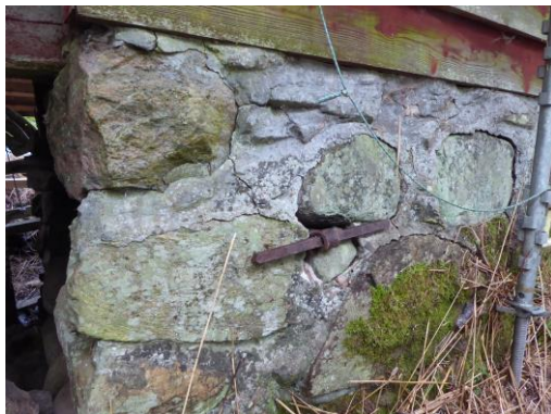
Efter åtgärd. Ankarjärn av smidesjärn med ankarslut på den östra långsidan och kryssavslut på den västra sidan sattes i stensockeln och anpassades sedan i stenmuren.
