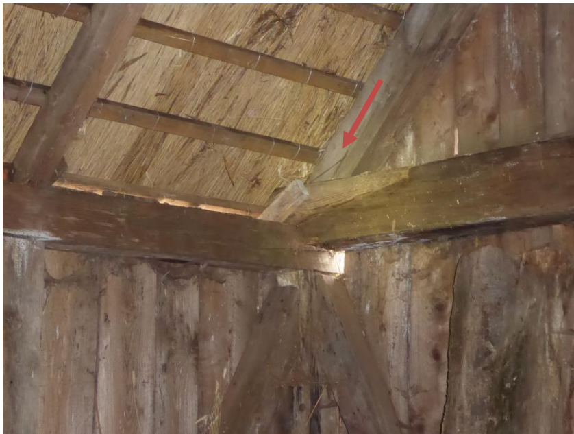
Efter åtgärder. Bit av friskt, äldre virke skarvades i.
