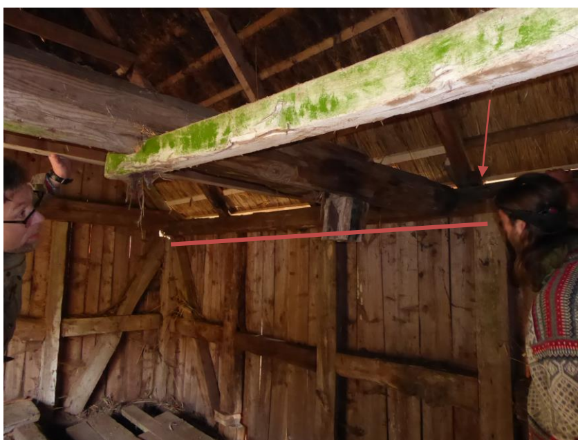
Efter åtgärder: Västra långsidan. Skadad del byttes mot friskt, äldre virke. Pilen markerar skarv.
