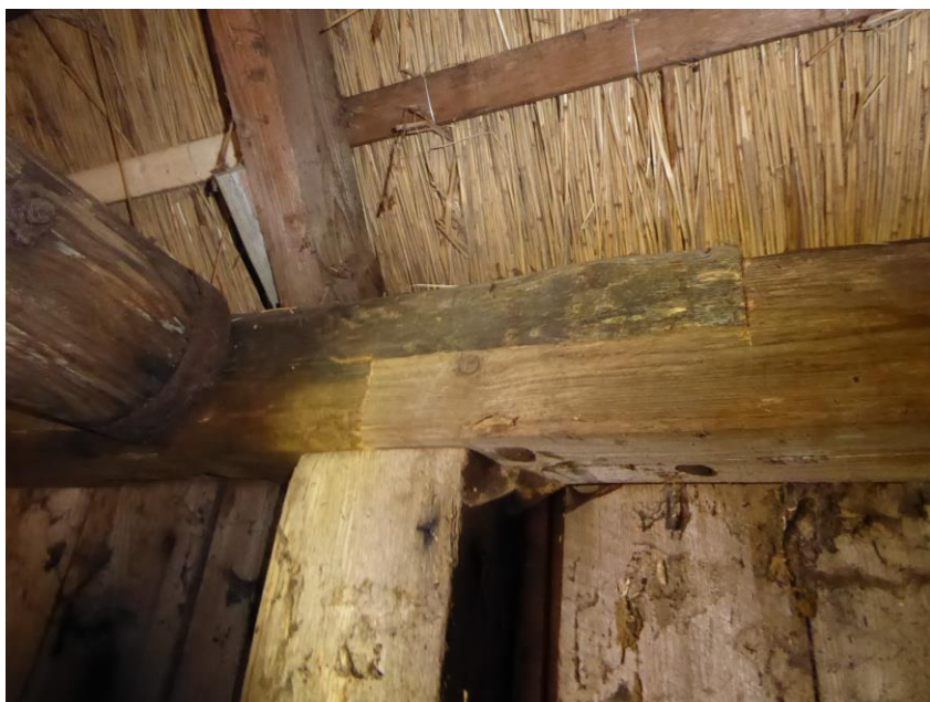
Efter åtgärder. Lejd skarvades i halvt i halvt och fästes med kraftig, smidd spik.
