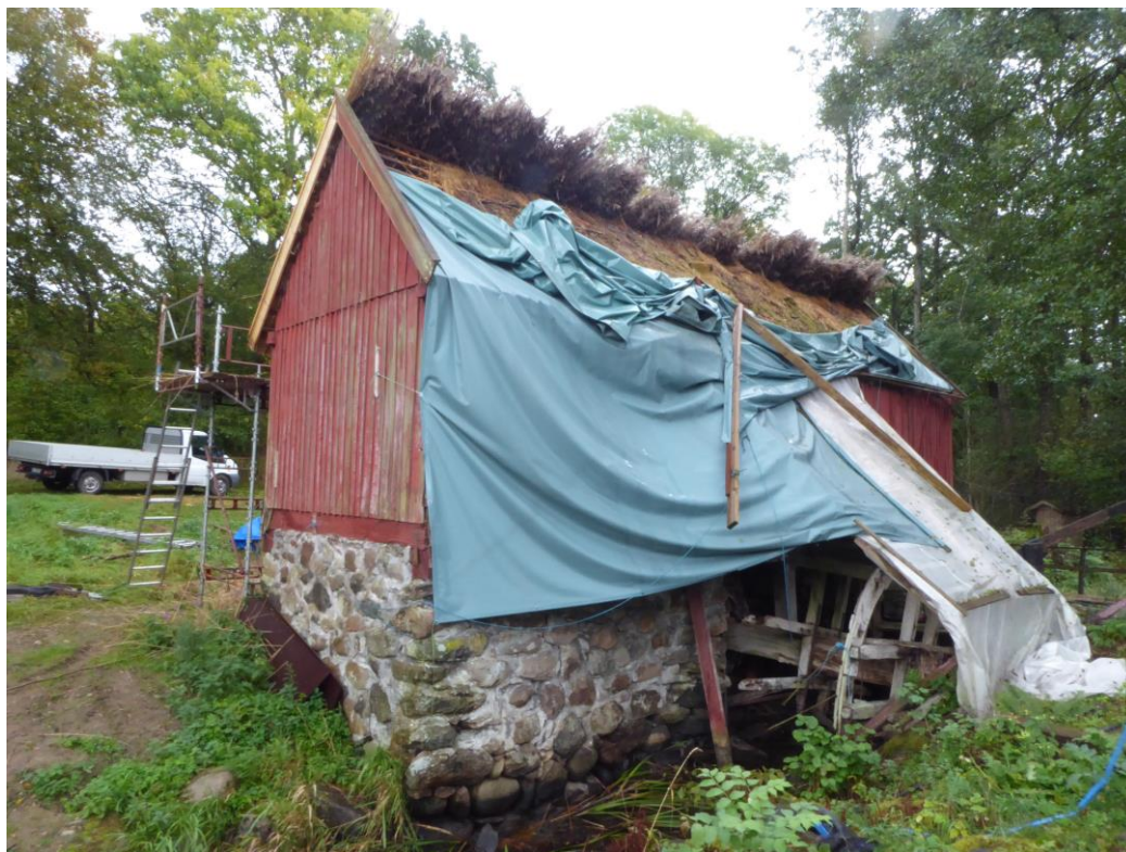
Under åtgärd. Taket läggs med vass.
