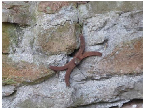
Efter åtgärd. Ankarjärn av smidesjärn med ankarslut på den östra långsidan och kryssavslut på den västra sidan sattes i stensockeln och anpassades sedan i stenmuren.
