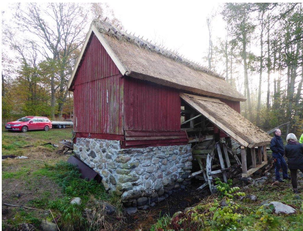
Efter åtgärd. Taket lades med vass med ryggning av löspressad råghalm.
