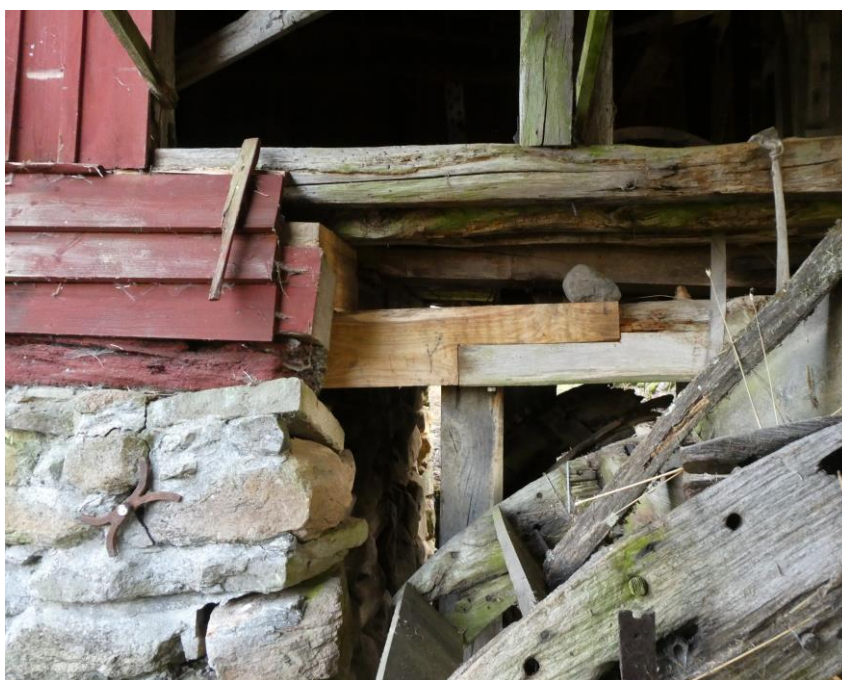
Efter åtgärder. Syllen anpassades från utsidan och ny bit av friskt, äldre virke skarvades i halvt i halvt.
