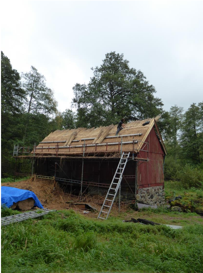
Under åtgärd: Sågmöllans tak lades med vass.
