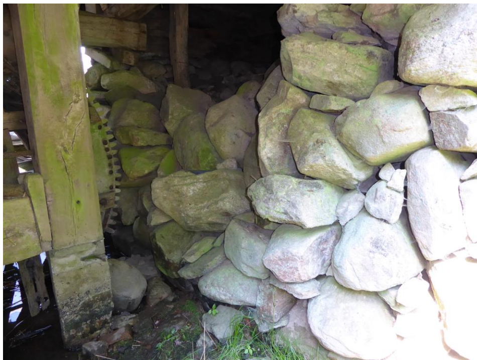
Före åtgärder. Kallmur vid maskingropen.
