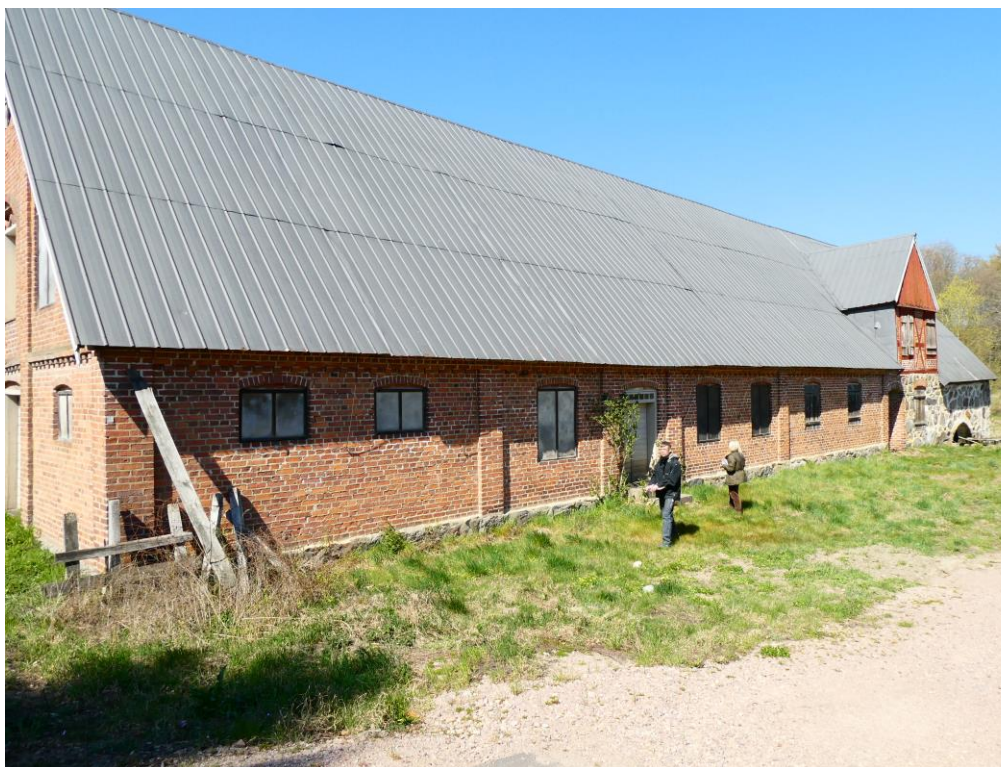
Före åtgärd. Sydöstra sidan. Fogen är det aktuella.
