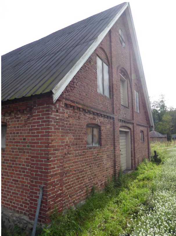
Före åtgärder. Sydvästra sidan, frontespisen, fogen är det aktuella.
