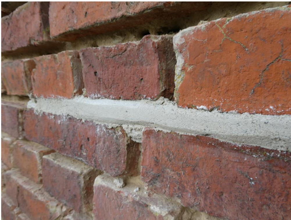
Under åtgärd. Provfogning med åsfog som granskades av antikvariskt medverkande. Provfog utfördes på nordvästra sidan.
