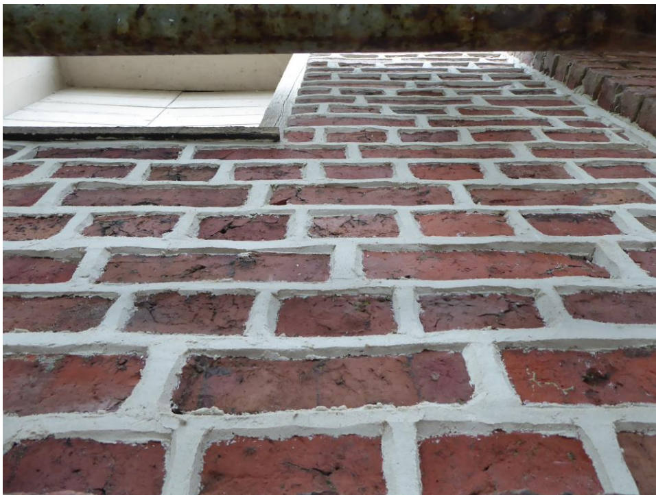
Under åtgärd. Fogen är det akutella.
