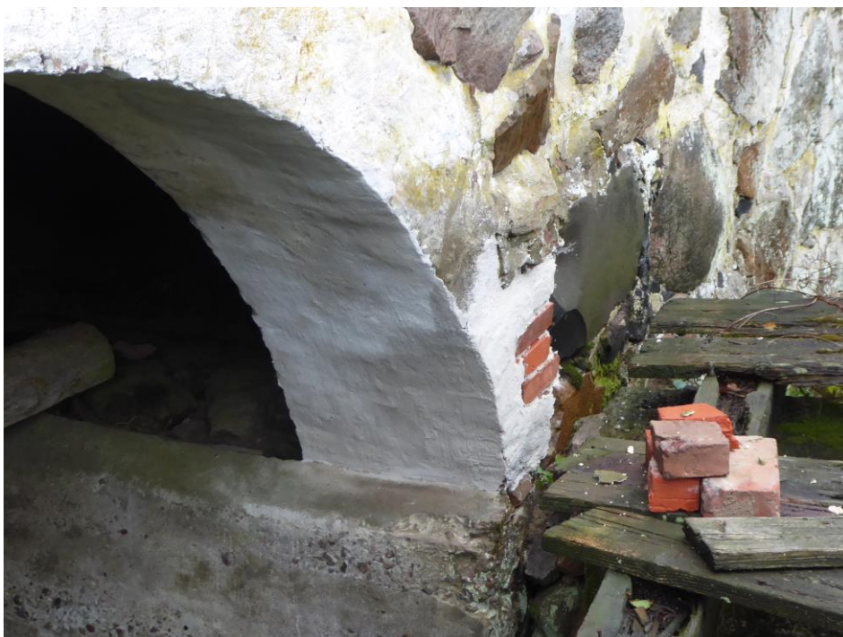
Efter åtgärd. Cementbruket togs bort och valvet murades med handslaget rött tegel från Bålamöllan och kalkbruk NHL 5.
