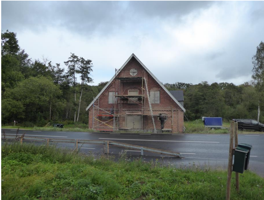
Under åtgärder. Ställning sattes upp och fogarna rensades från gammalt bruk.
