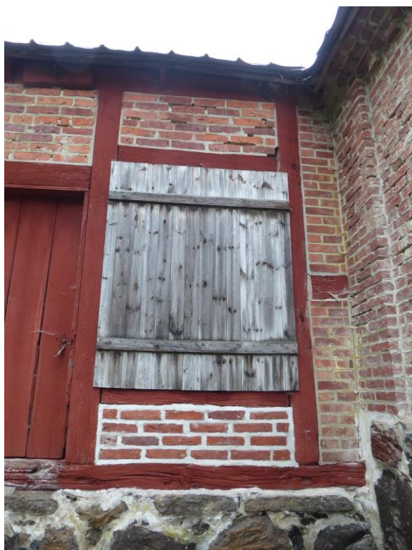
Efter åtgärd. Lös cement togs bort utan att skada tegelstenar och facket säkrades i sidled med spik och fogades med lufthärdande bruk.
