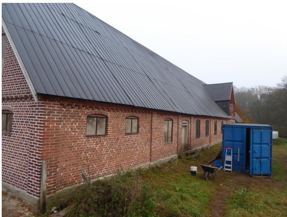
Efter åtgärd. Sydöstra sidan. Fogen är det aktuella. Foglagning utfördes på särskilt åtgångna partier. Slätfog utfördes.
