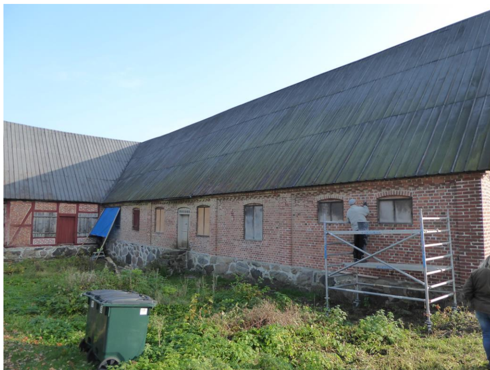
Under åtgärd: Foglagning utfördes på särskilt åtgångna partier. Slätfog utfördes.
