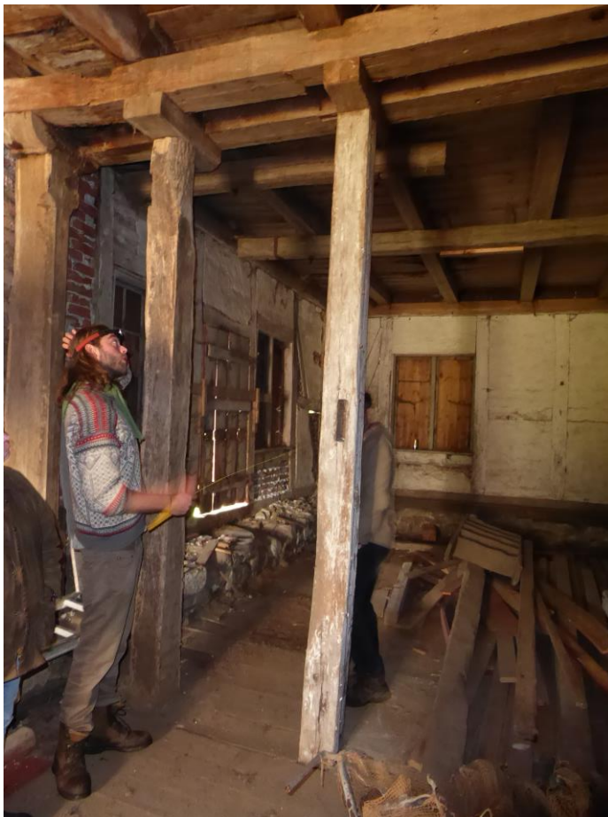
Efter åtgärd: Uppsättning av stolpe för att säkra konstruktionen. Urtag i brädgolv utfördes så stolpen kan stå på stabil grund.
