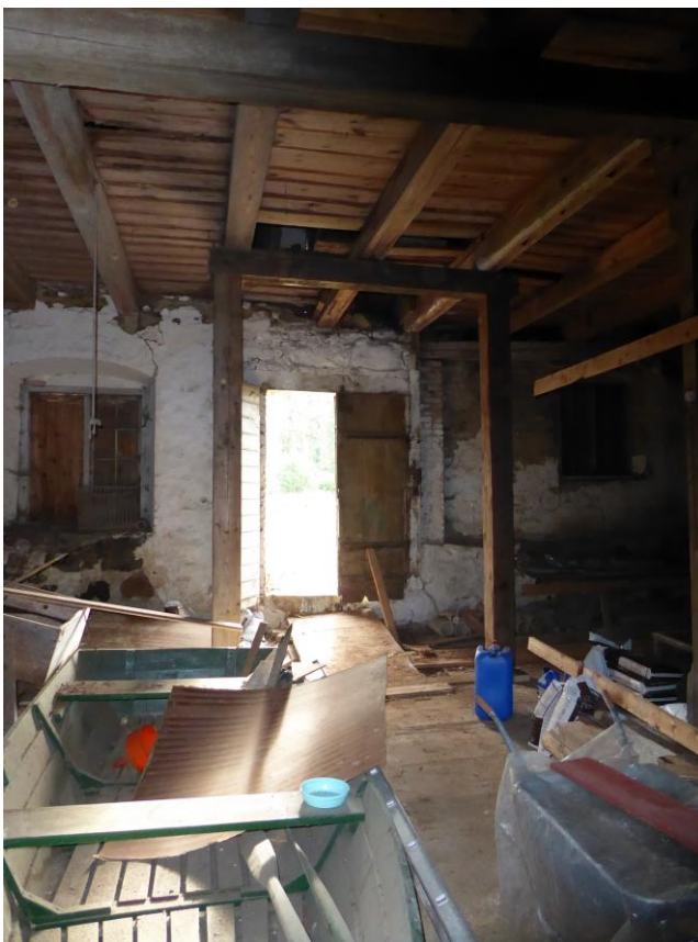
Efter åtgärd. Bjälkar stämpades upp med handbilade, äldre stolpar.
