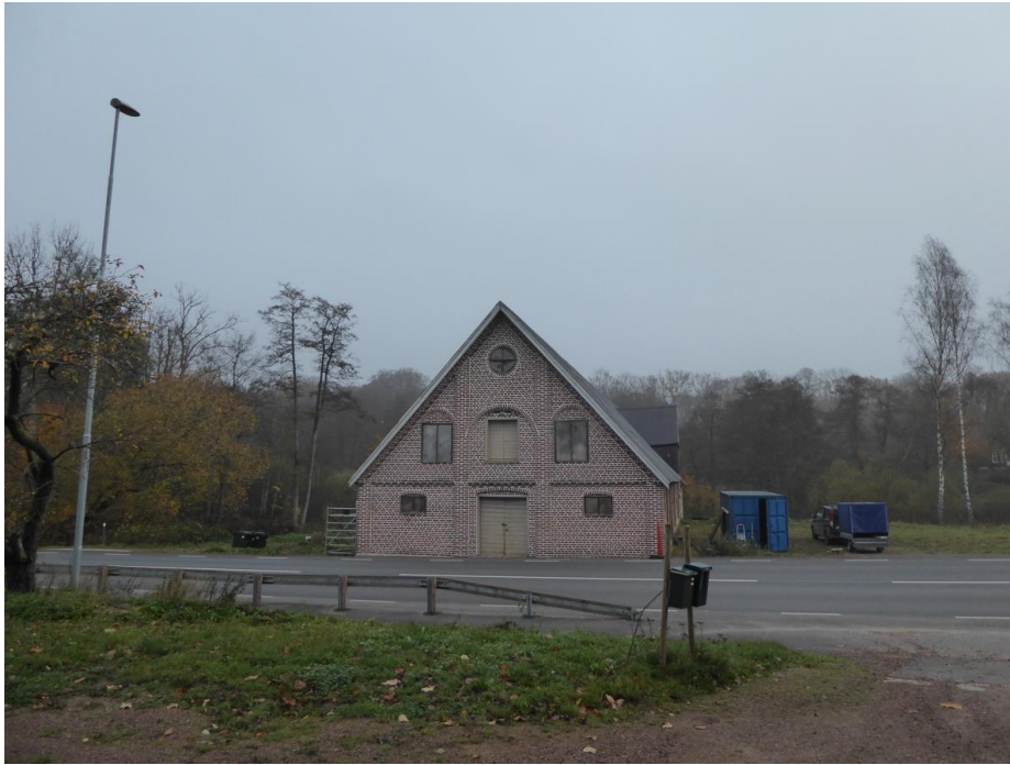
Efter åtgärd: fogen är den aktuella.
