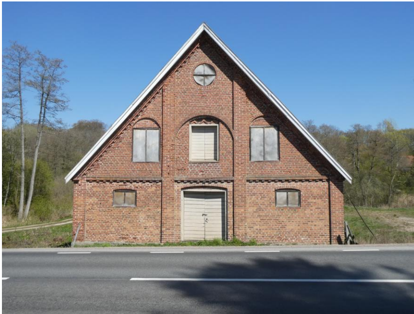
Före åtgärder. Sydvästra sidan, frontespisen, fogen är det aktuella.
