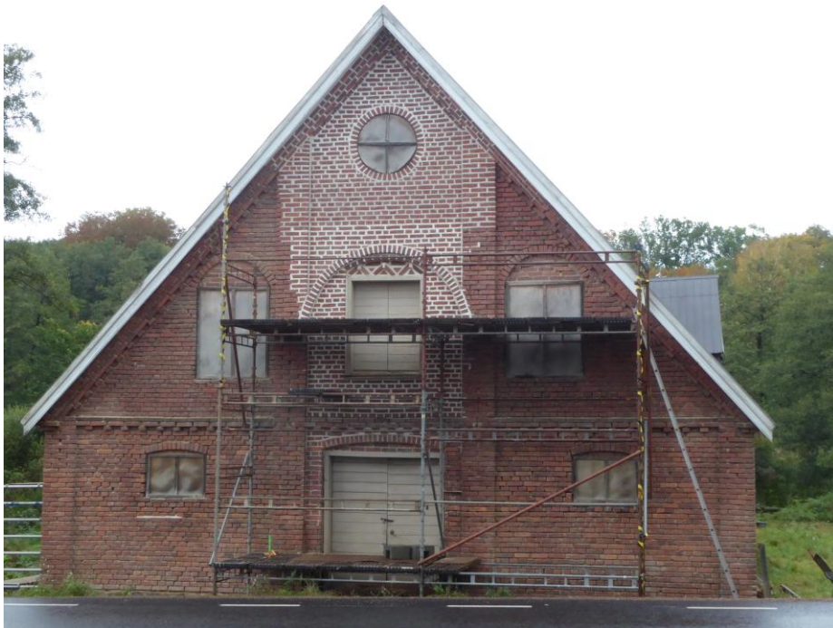
Under åtgärd. Sydvästra gaveln fogas med åsfog.
