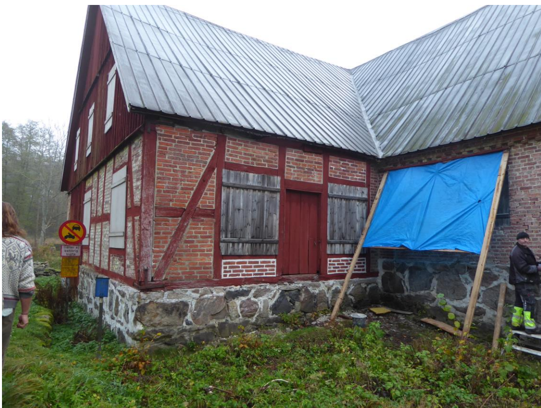
Efter åtgärd: Facken fogades med slätfog.
