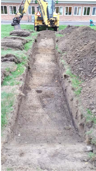
Figur 8. Schakt 46. Närmast i bild nedgrävning K121.
