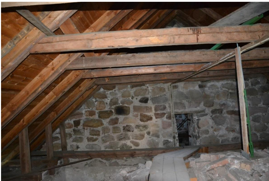
Figur 55. Långhusets östra vägg består av natursten lagda i jämna skift. Öppningen har en överliggare i trä.
