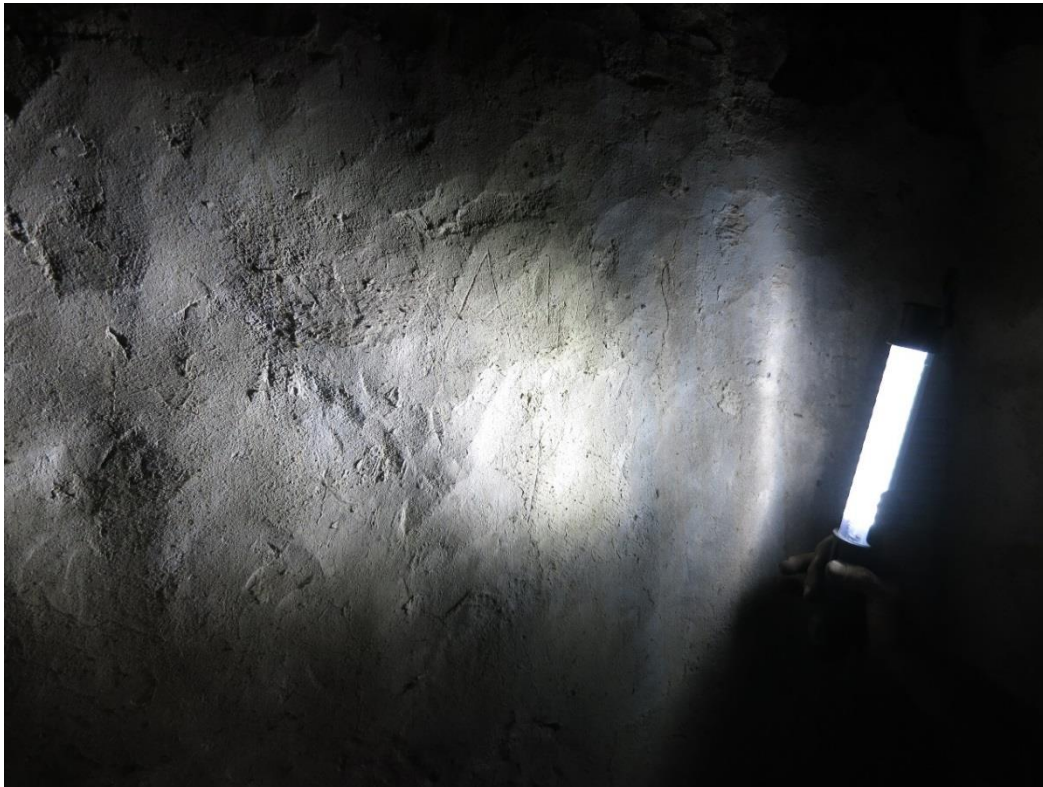
Figur 51. Putsen är slättdragen och spåren efter i putsen vittnar om hur en murarslev använts för att dra ut putsen.
