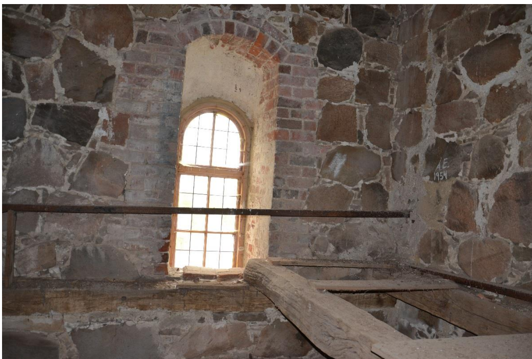
Figur 71. Fönstret i tornvindens första våning har invändigt en stickbågig form och utvändigt en rundbågig form och en omfattning i tegel. Ursprungligen har öppningen fungerat som en ingång till tornet via ett utvändigt trapporn av tegel som är rivet (Wikerstål arkitekter 2008, s 49).
