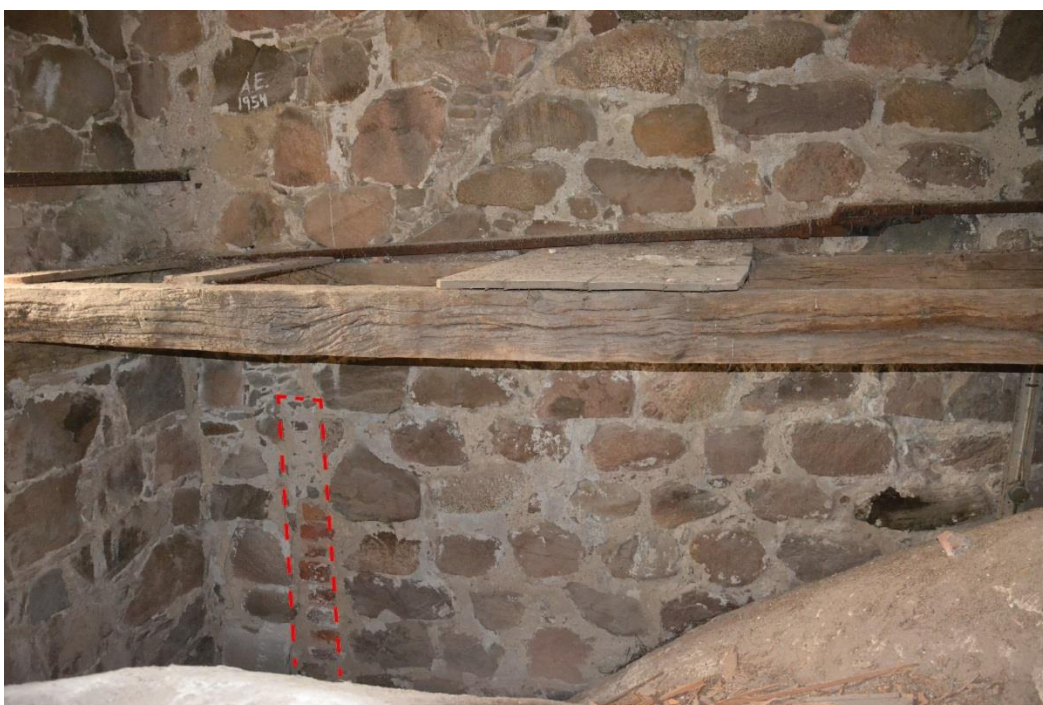
Figur 73. I tornets östra vägg mot norr finns ett med tegel igenmurat avtryck efter en vertikalt stående konstruktion.
