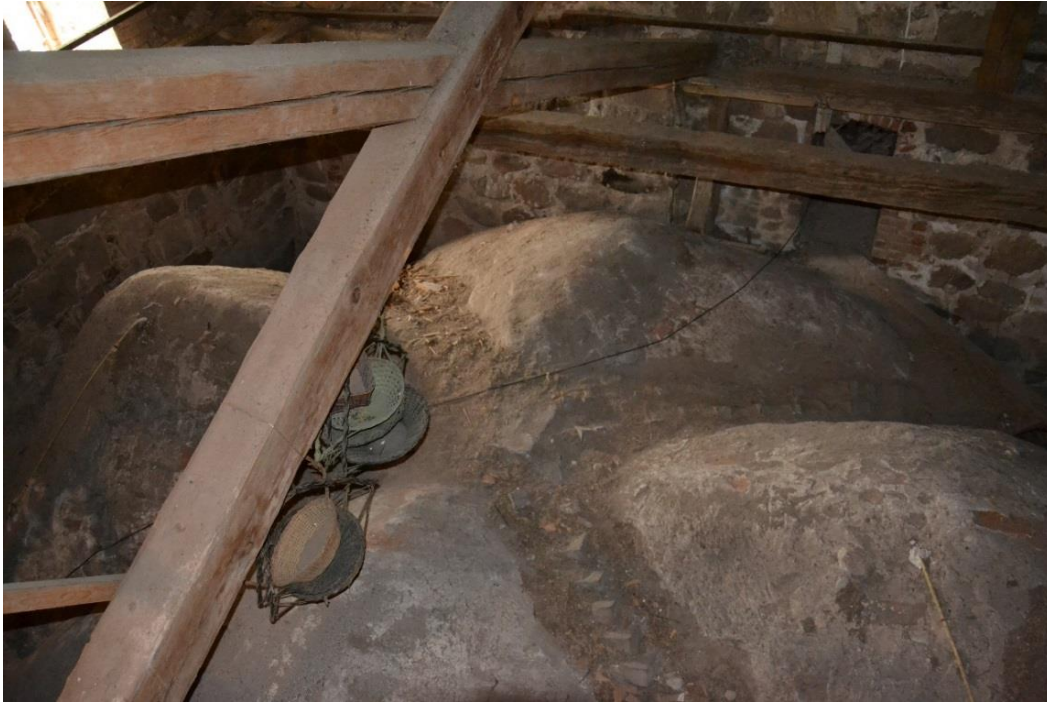
Figur 76. Ribbvalven i tornet sett från den invändiga trappan i väster.
