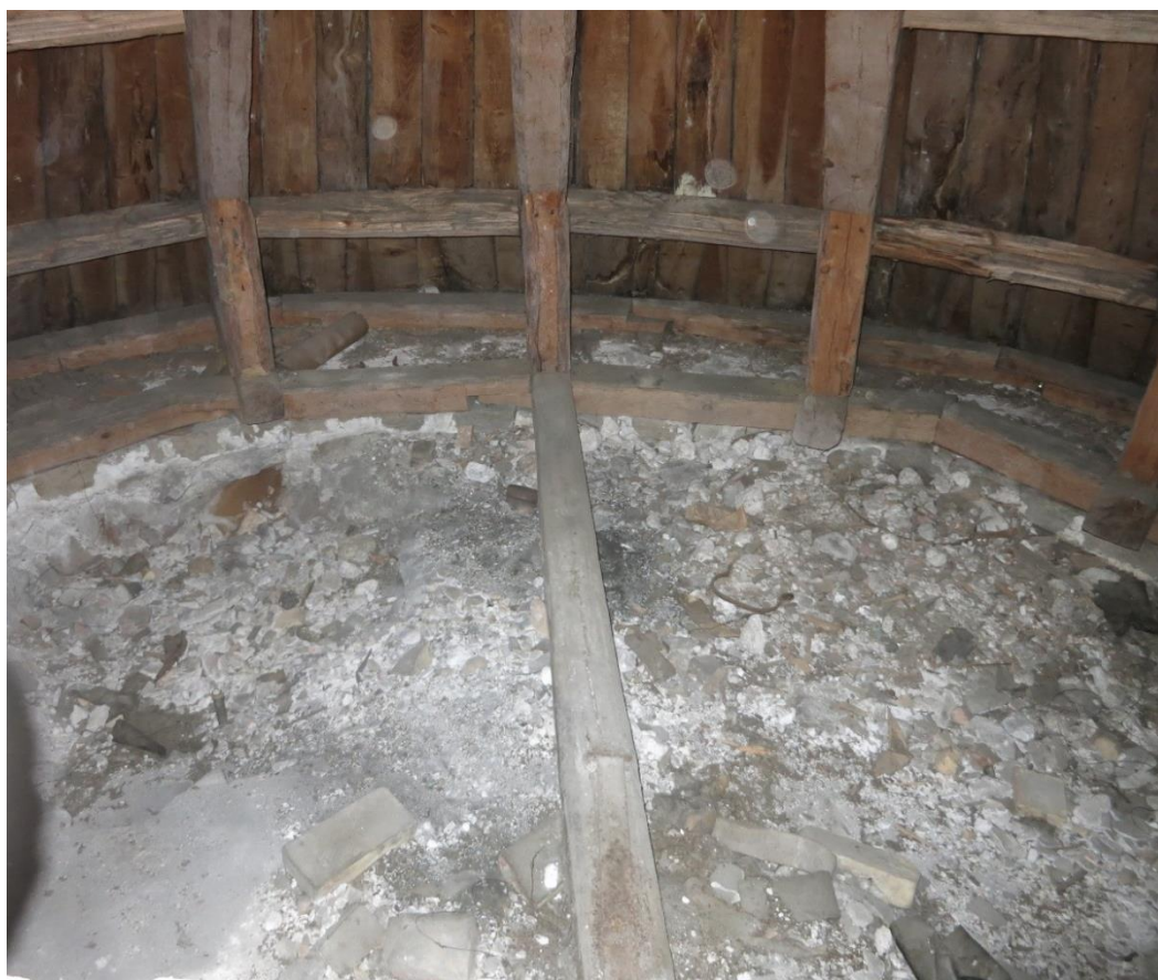
Figur 43. Absiden. Foto före städning.
