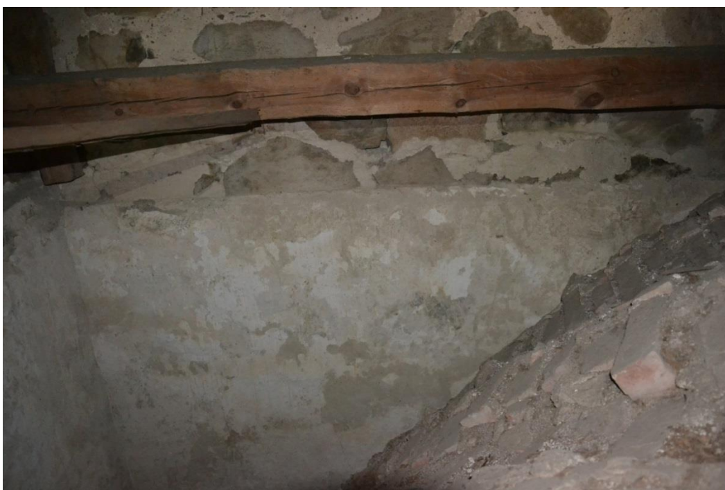
Figur 58. I långhusets väggar kan man se hur putsen slutar tvärt där det före valvslagningen på 1400-talet funnits ett innertak i trä.
