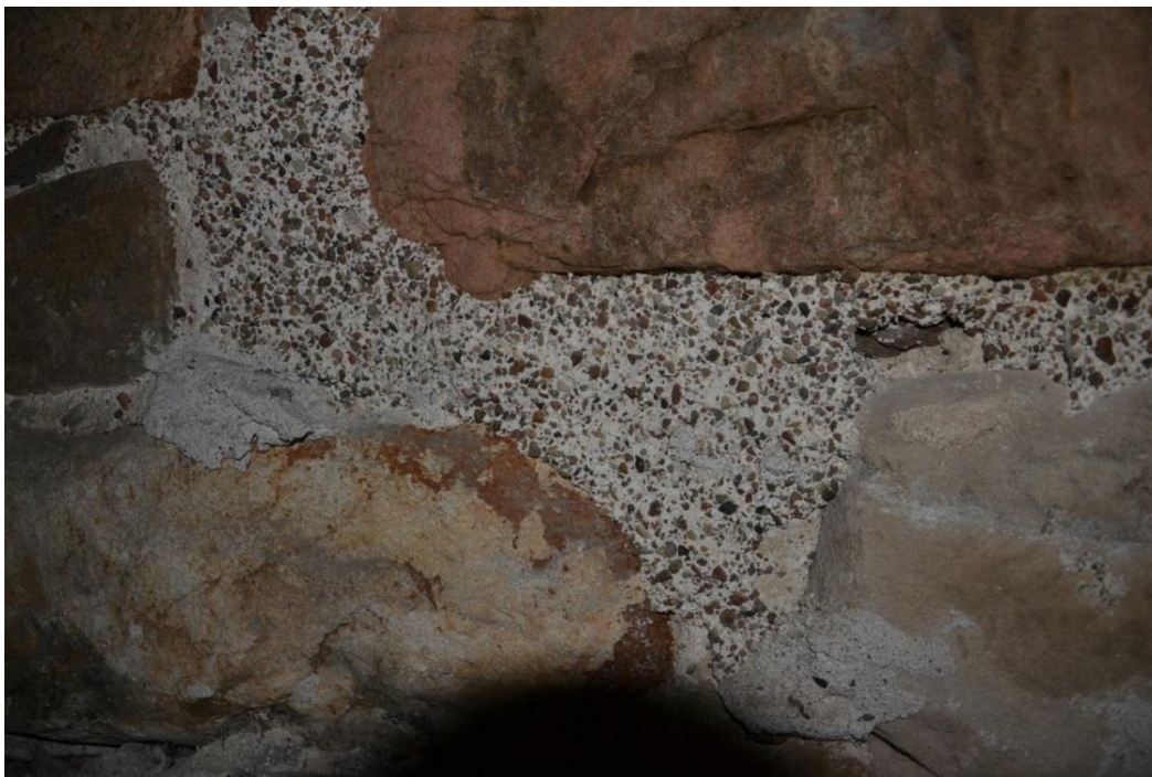
Figur 48. Kalkbrukets som använts för att foga samma stenar i det ursprungliga murverket har ett mycket karakteristiskt utseende med en mycket stor mängd ballast. Detta kalkbruk återfinns i korets och långhusets väggar.
