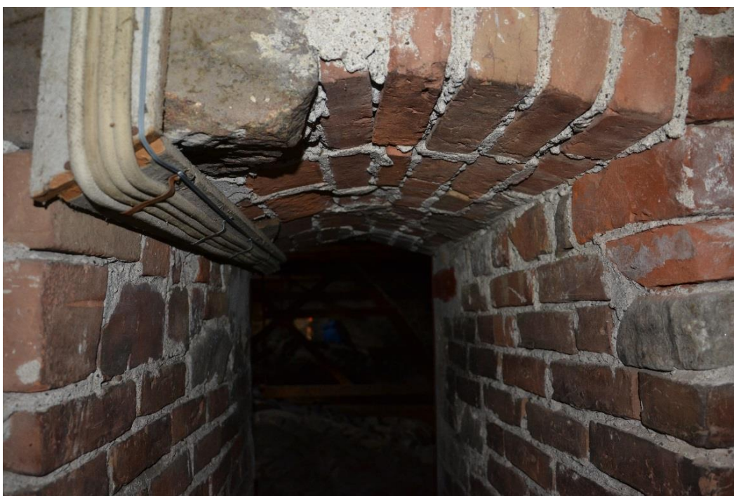
Figur 75. Öppningen mellan torn och långhus har en stickbågig form. Fogarna har inte alltid dragits jämna, särskilt inte i bågen.
