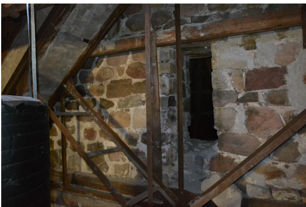
Figur 47. Korets östra vägg. Fackverksramen av järn stödjer rökgången till skorstenen och tillkom vid 1950-51 års restaurering. Till vänster i bild syns delar av ett expansionskärl till en värmeanläggning.
