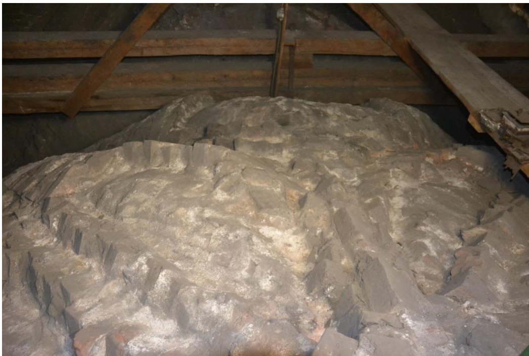
Figur 6. Efter städning var valkapporna fria från smuts och svicklarna rengjorda från ytligt liggande organiskt material.
