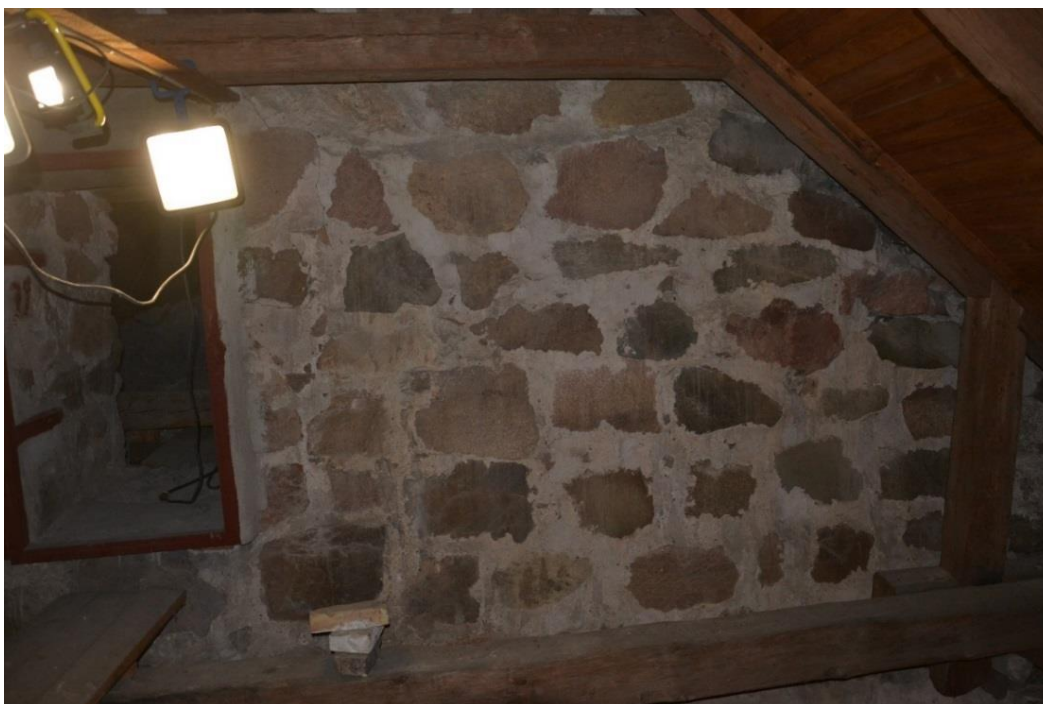
Figur 46. Korets västra vägg. Murverket i koret består av natursten lagda i jämna skift. Kalkbruket har dragits ut över stenarna.
