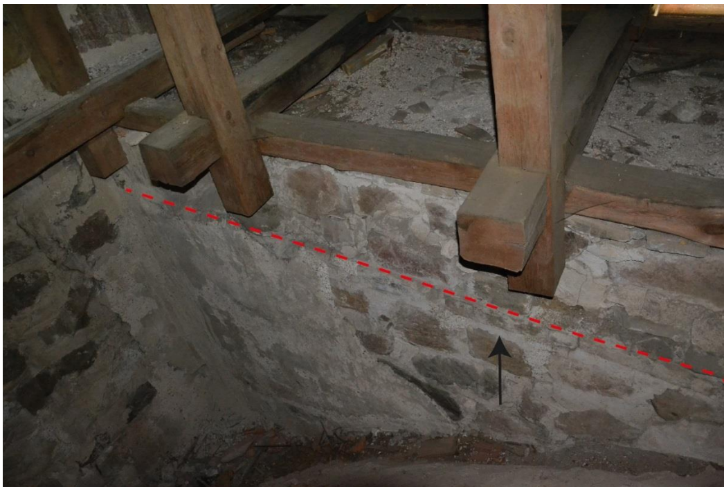
Figur 57. Långhusets ursprungliga murkrön syns på vissa partier tydligt, där tunna skift med sten avlutat murverket. Det är troligen när valven slogs på 1400-talet som murkrönet höjdes.
