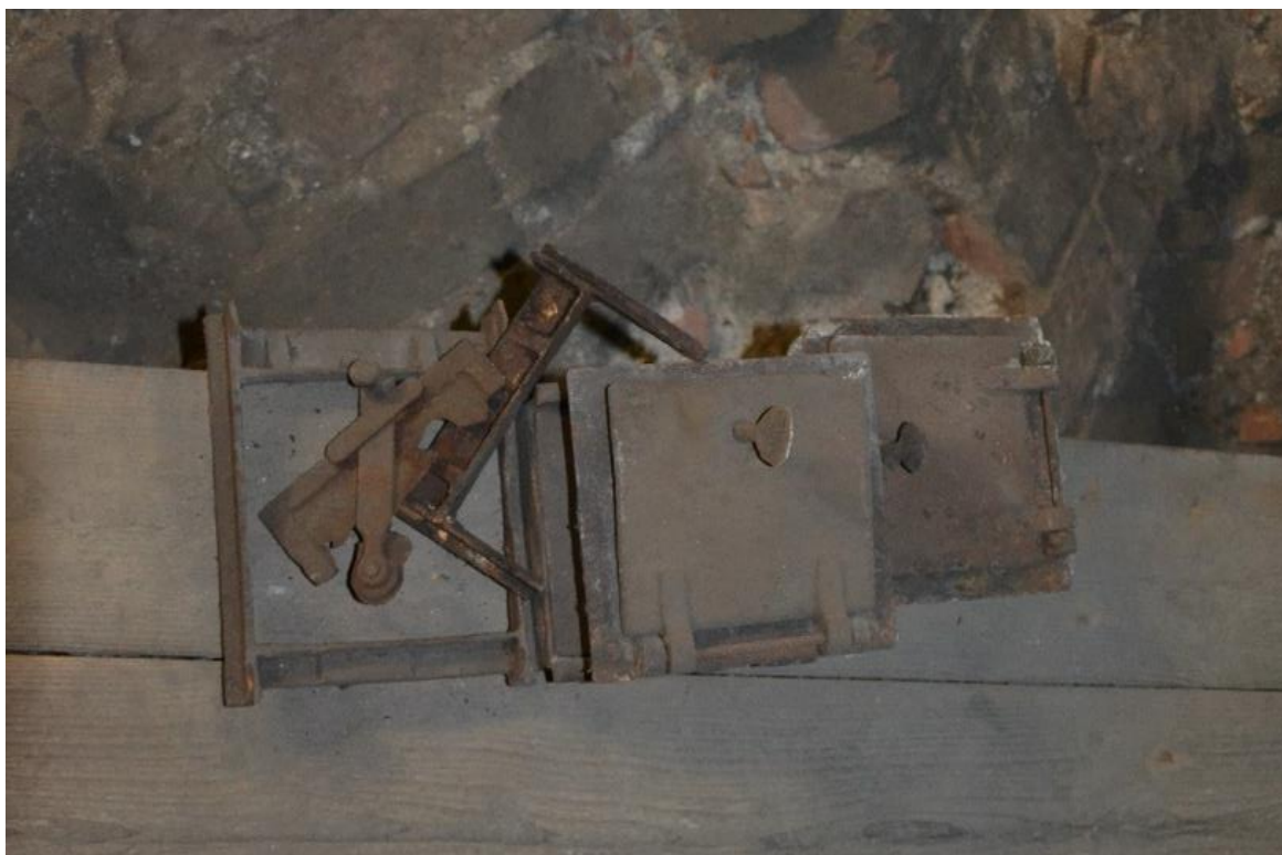
Figur 26. Valv 3, långhuset Sotluckor.
