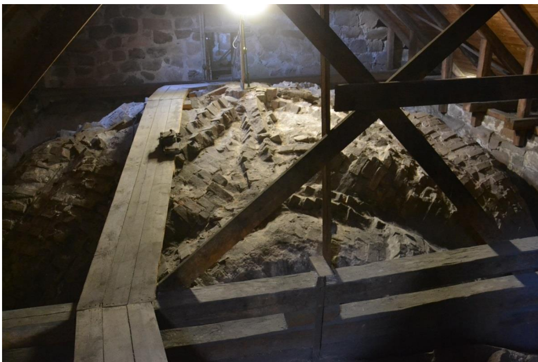
Figur 65. Östra stjärnvalvet i långhuset.
