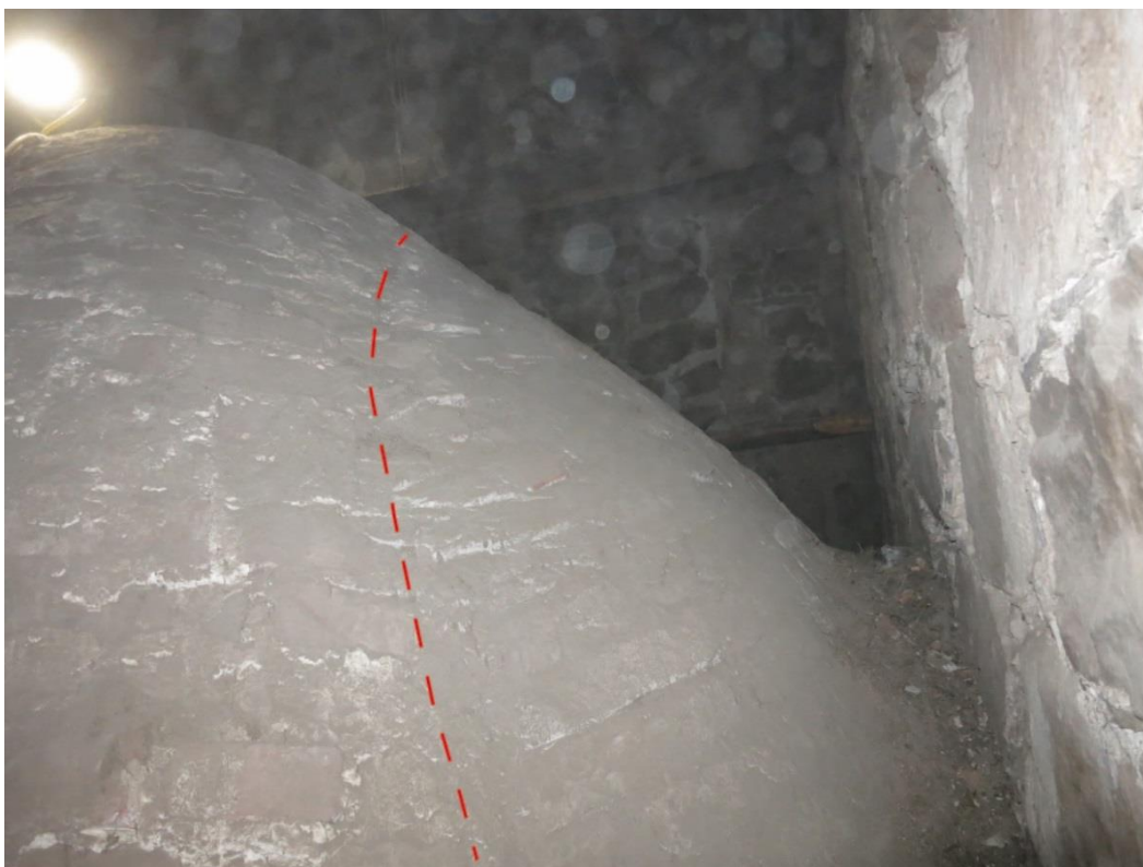
Figur 82. Äldre öppning upp till vinden i tornets södra valvkappa som murats igen, sett från väster.
