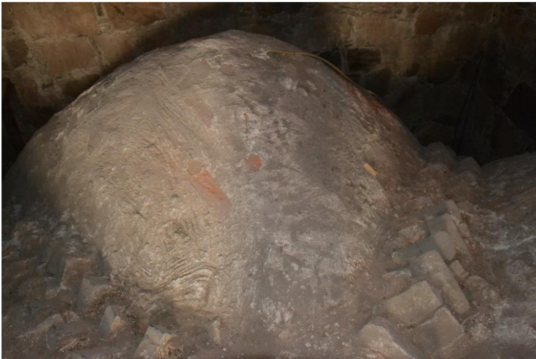
Figur 77. Valven är strukna med kalkbruk och spår efter redskapet som använts syns i bruket.
