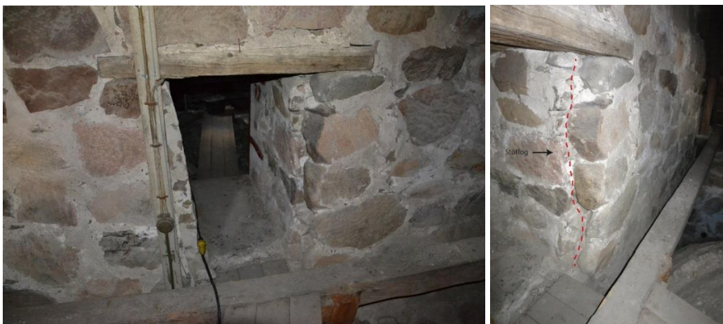
Figur 56. Öppningen mellan långhus och kor har en överliggare i trä. I höger sida finns en stötlog. Kanske har öppningen murats om vid något tillfälle och överliggaren i trä infogats.
