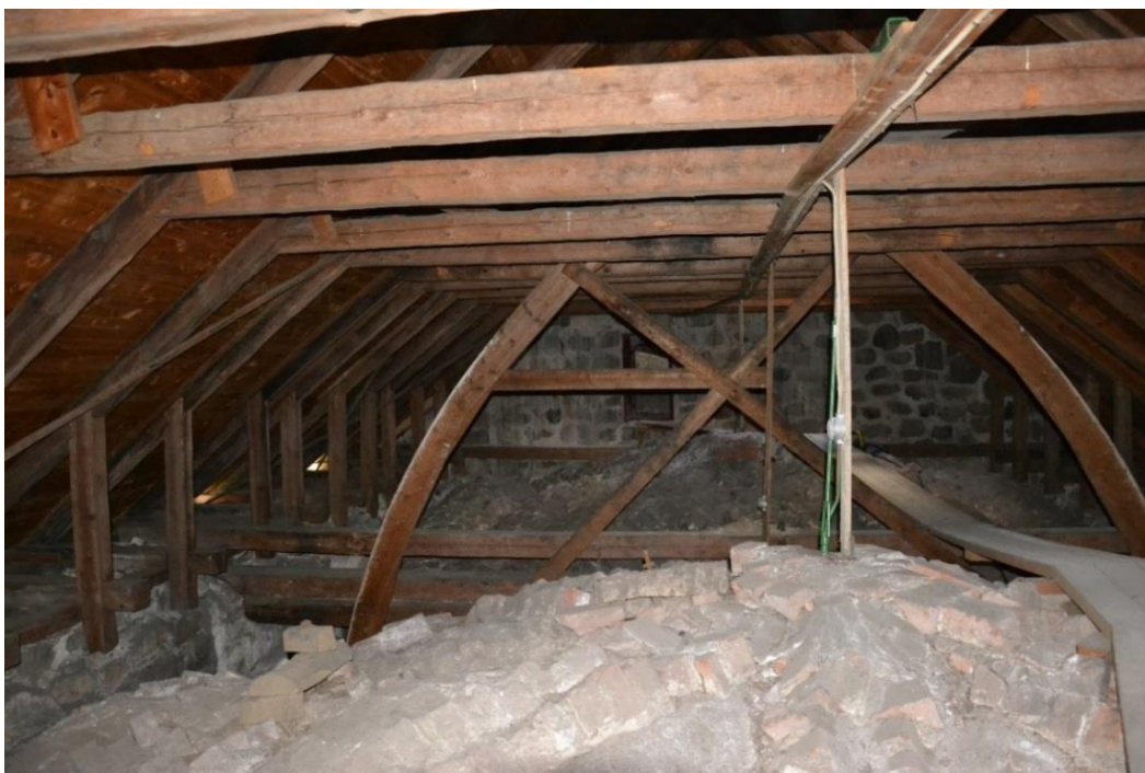
Figur 64. Över långhuset har två stjärnvalv slagits. En återanvänd mall för en båge ingår i takstolen från 1861 och kan ha utnyttjats som stöd för den skorsten som tidigare suttit i denna position.
