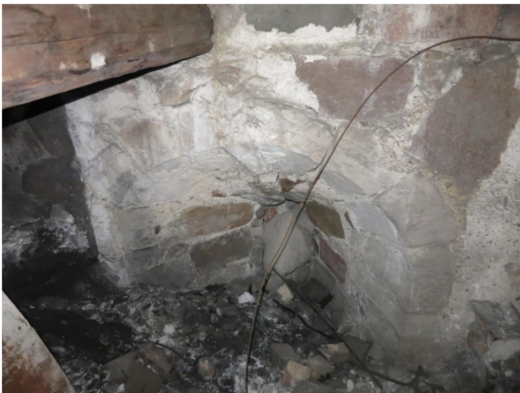
Figur 61. På kyrkvindens kan man se det romanska fönstret i långhusets södra vägg. Fönstret har en omfattning av fint bearbetad sandsten, längre in i fönsternischen är stenen obearbetad. Fönsternischen har invändigt varit putsad, men bågen har varit oputsad.
