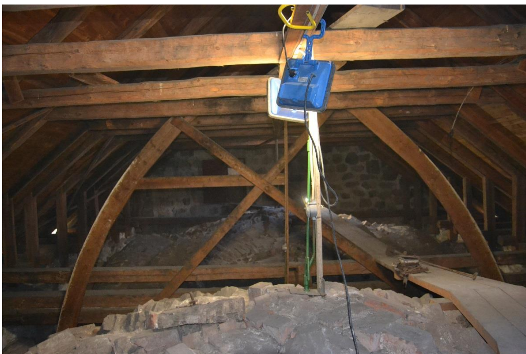
Figur 66. Västra stjärnvalvet i långhuset.
