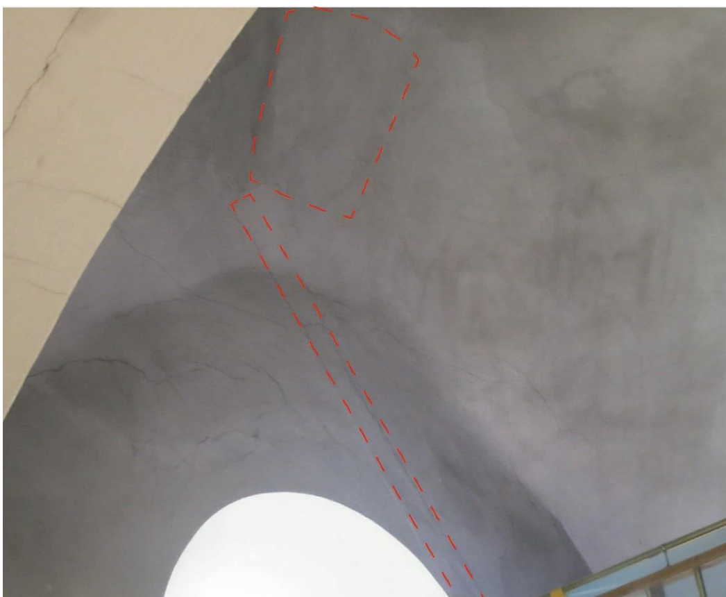
Figur 83. Äldre öppning till vinden sedd inne från kyrkorummet som avtryck i valvet ovan orgelläktaren.
