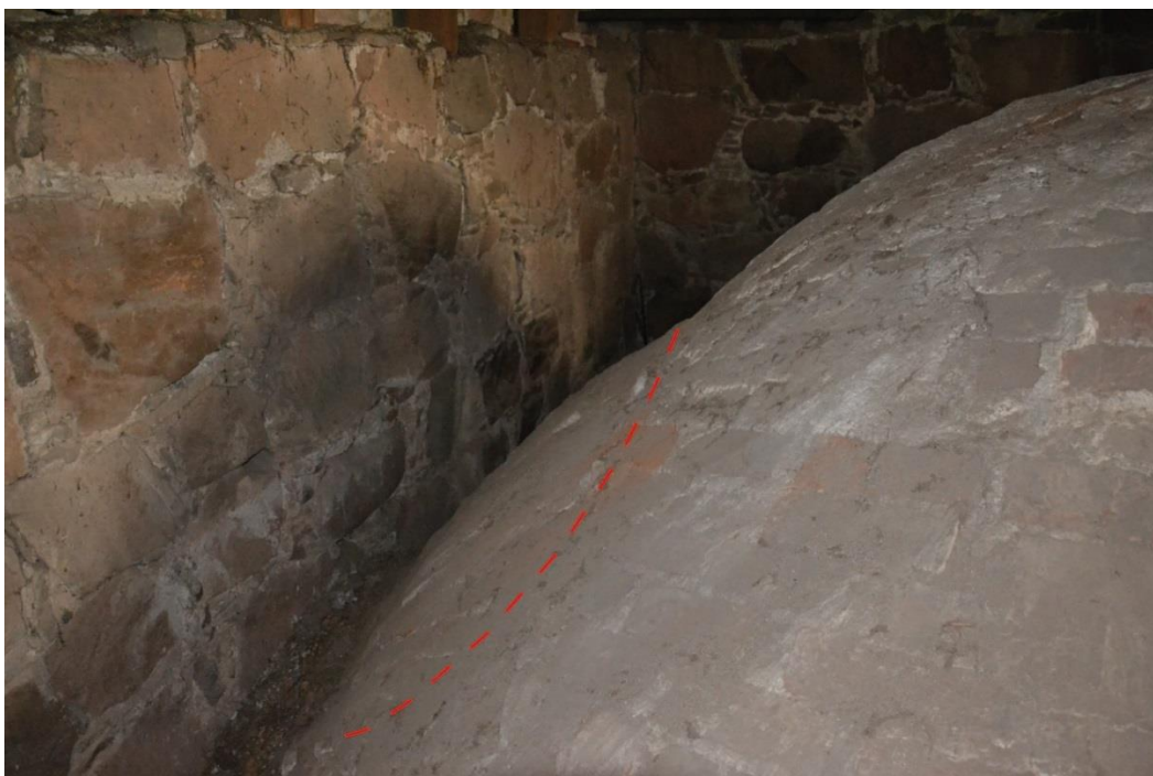
Figur 81. Äldre öppning upp till vinden som lär ha tillkommit år 1926 eller något senare i tornets södra valvkappa som senare murats igen, sett från öster.
