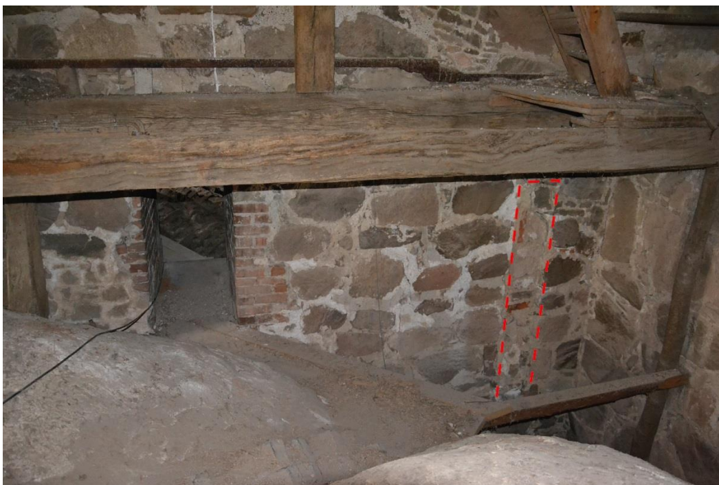
Figur 74. I tornets östra vägg mot söder finns ett med tegel igenmurat avtryck efter en vertikalt stående konstruktion. Öppningen mellan torn och långhus är sekundär och har en omfattning av tegel.
