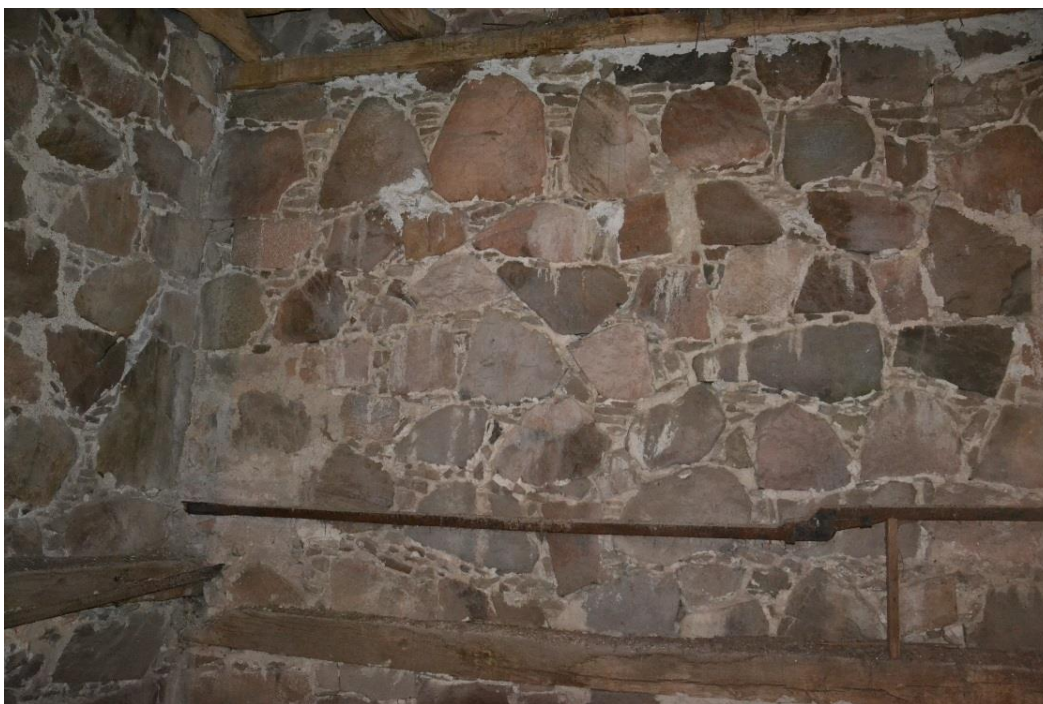
Figur 70. Tornets murverk med natursten i ganska jämna skift och med mycket skolsten i fogarna.
