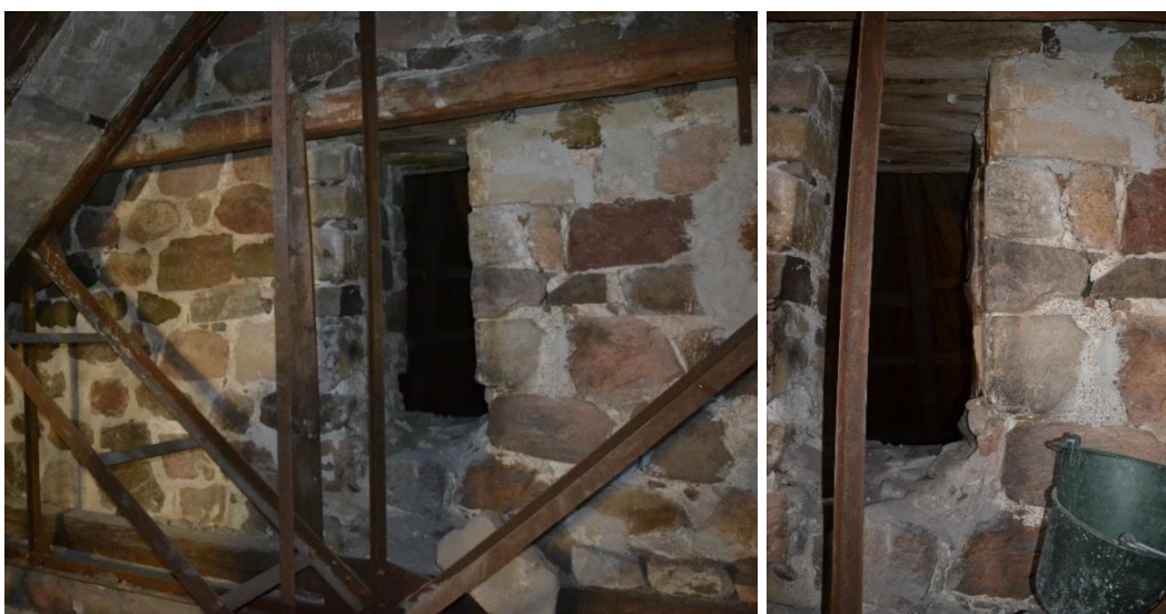
Figur 45. Öppning mellan kor och långhus. Foto mot öster.
