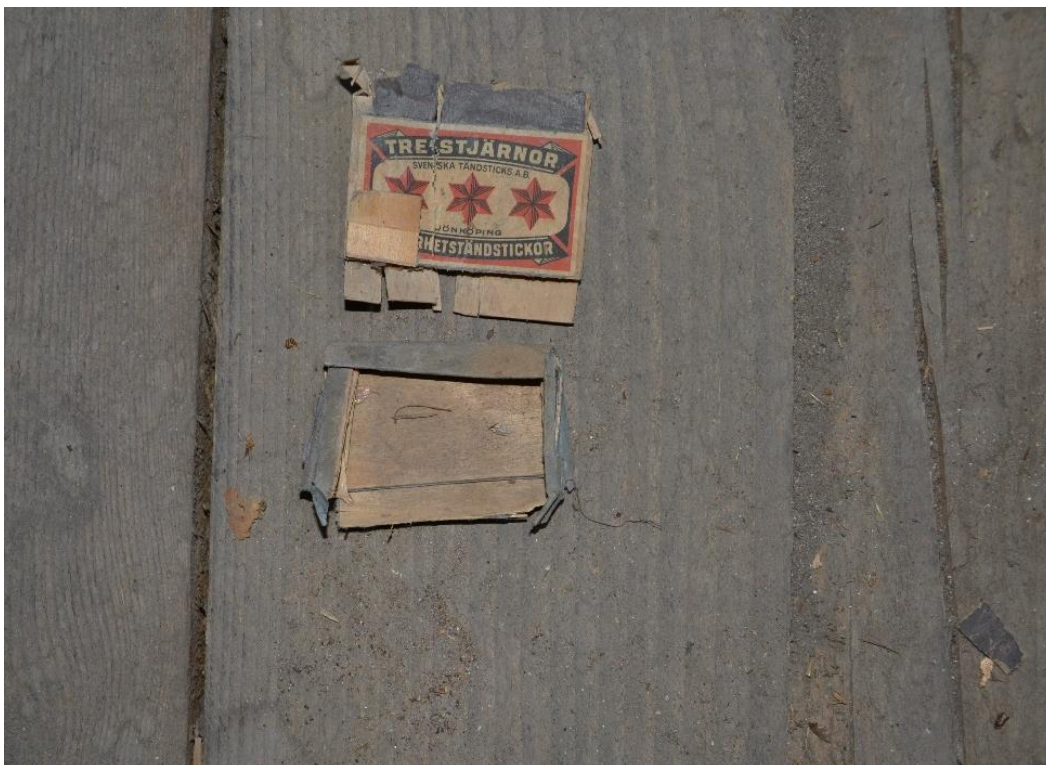
Figur 31. Valv 4, koret. Sotlucka.
