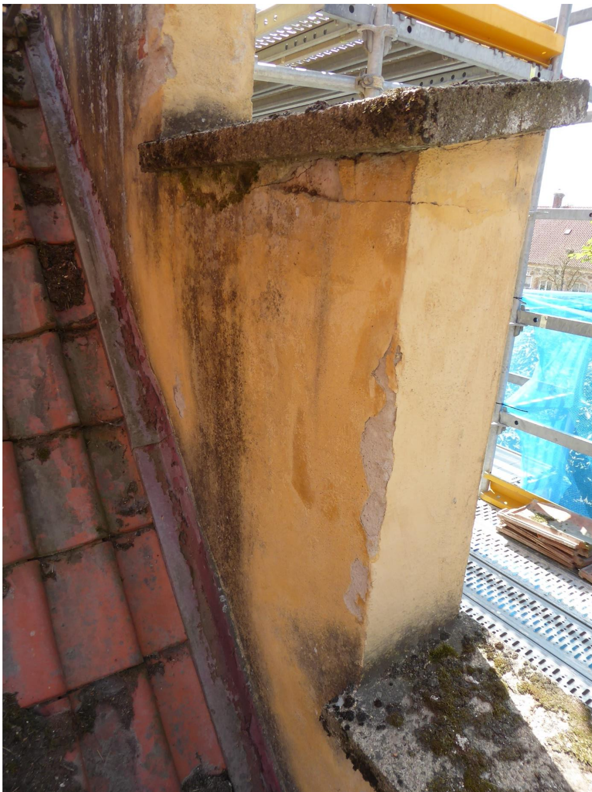
Figur 5. Trappgavel före åtgärderna.
