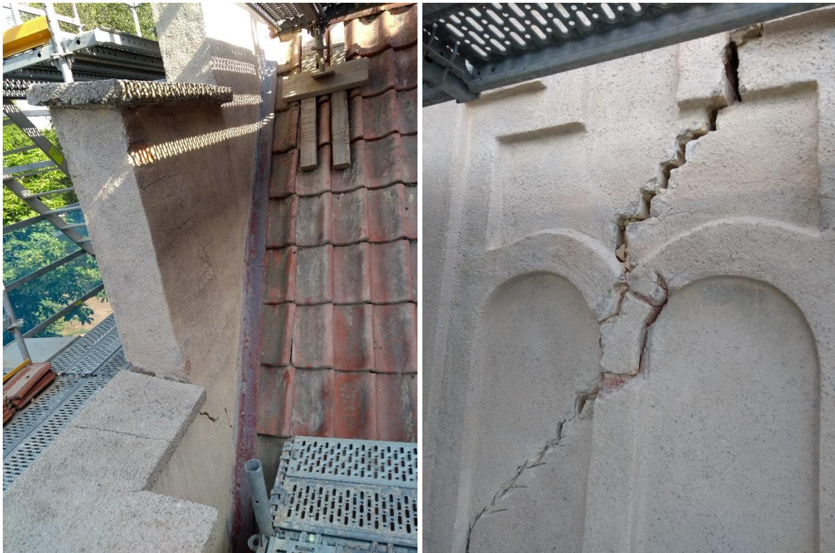
Figur 12. Vänster: Blästrad och rengjord trappgavel. Höger: Blästrad trappgavel och den kraftiga sprickan som var tydlig före åtgärderna har knackats upp.
