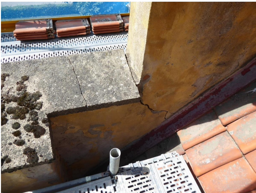
Figur 4. Trappgavel före åtgärderna
