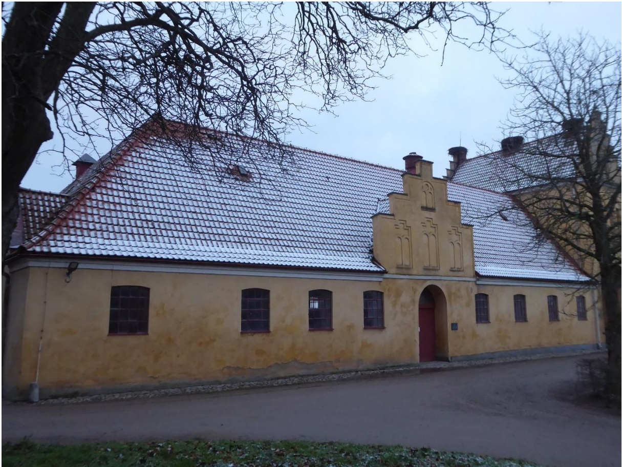
Figur 1. Den aktuella fasaden, Fullblodsstallet, före åtgärderna.
