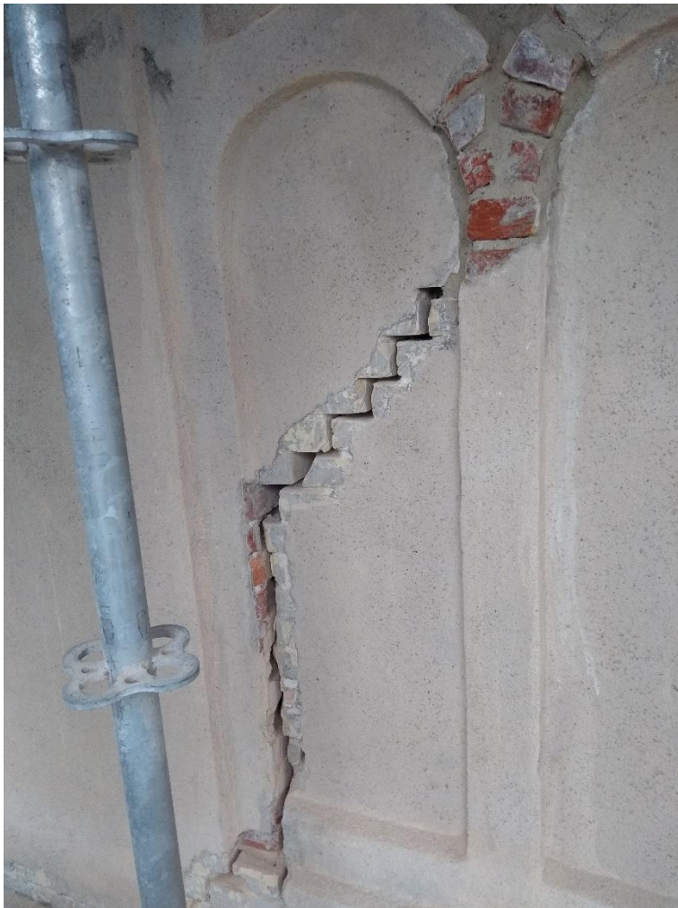
Figur 15. På bilden ser man att blinderingen är i gult tegel och bågen i rött tegel.
