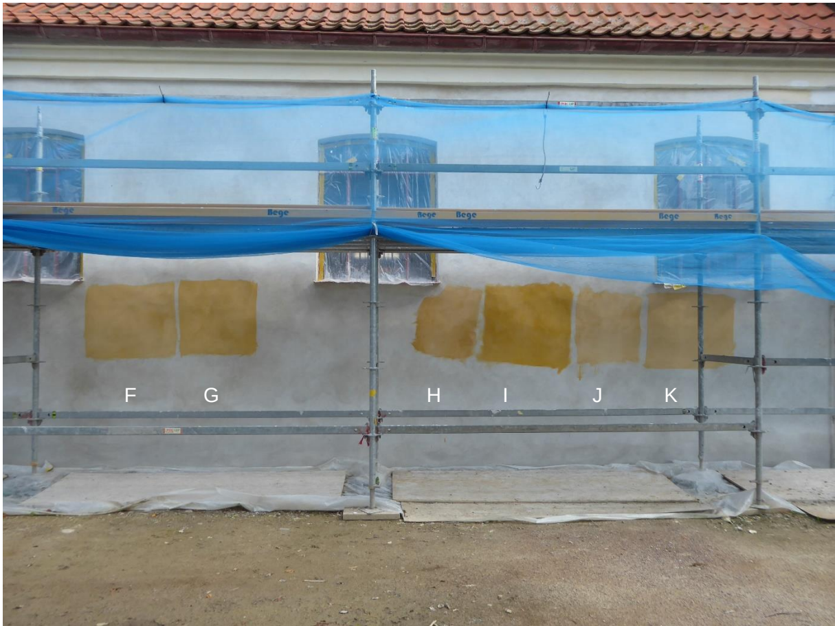
Figur 30 . Uppstrykningsprover på den nya ytputsen. Räknat från vänster:
