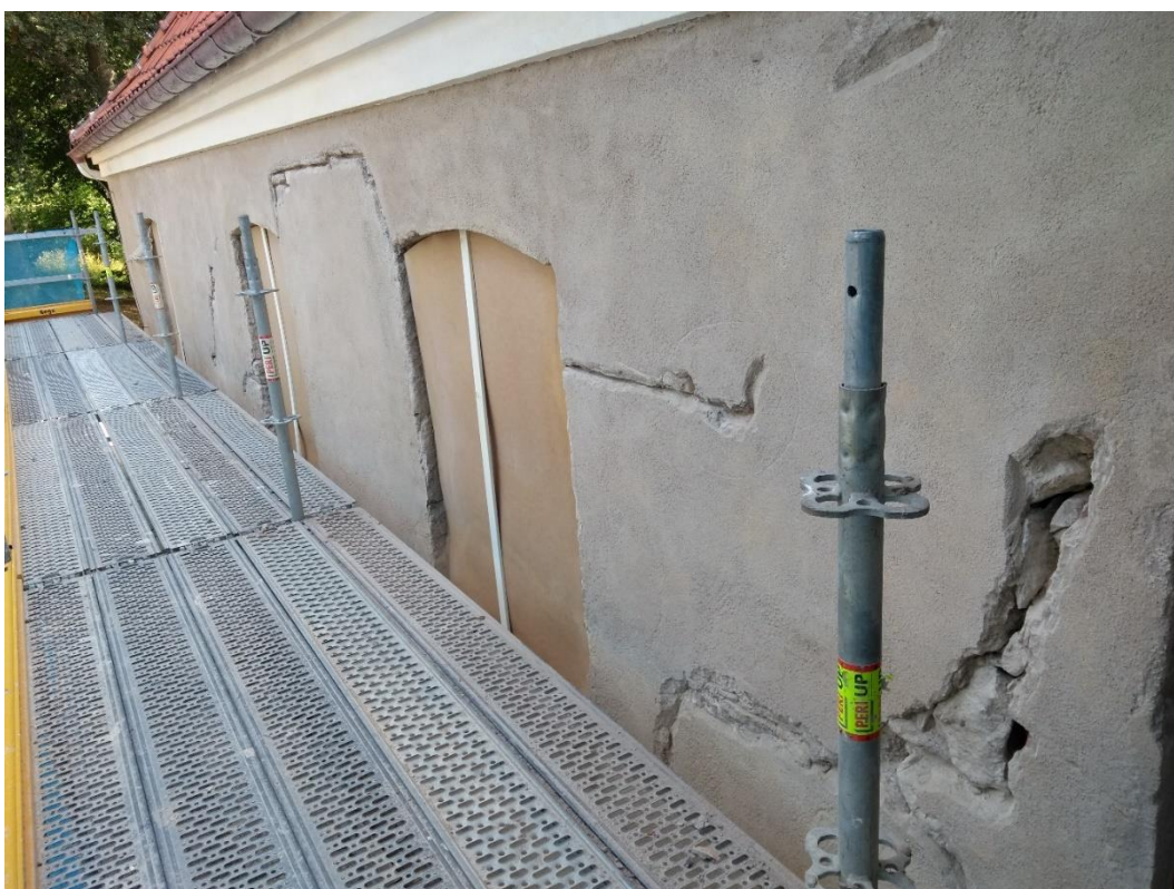
Figur 8. Portomfattningen efter putsnedknackning och rengöring. I fasaden syns en svag sättnings som dock inte påverkat naturstensomfattningen.
