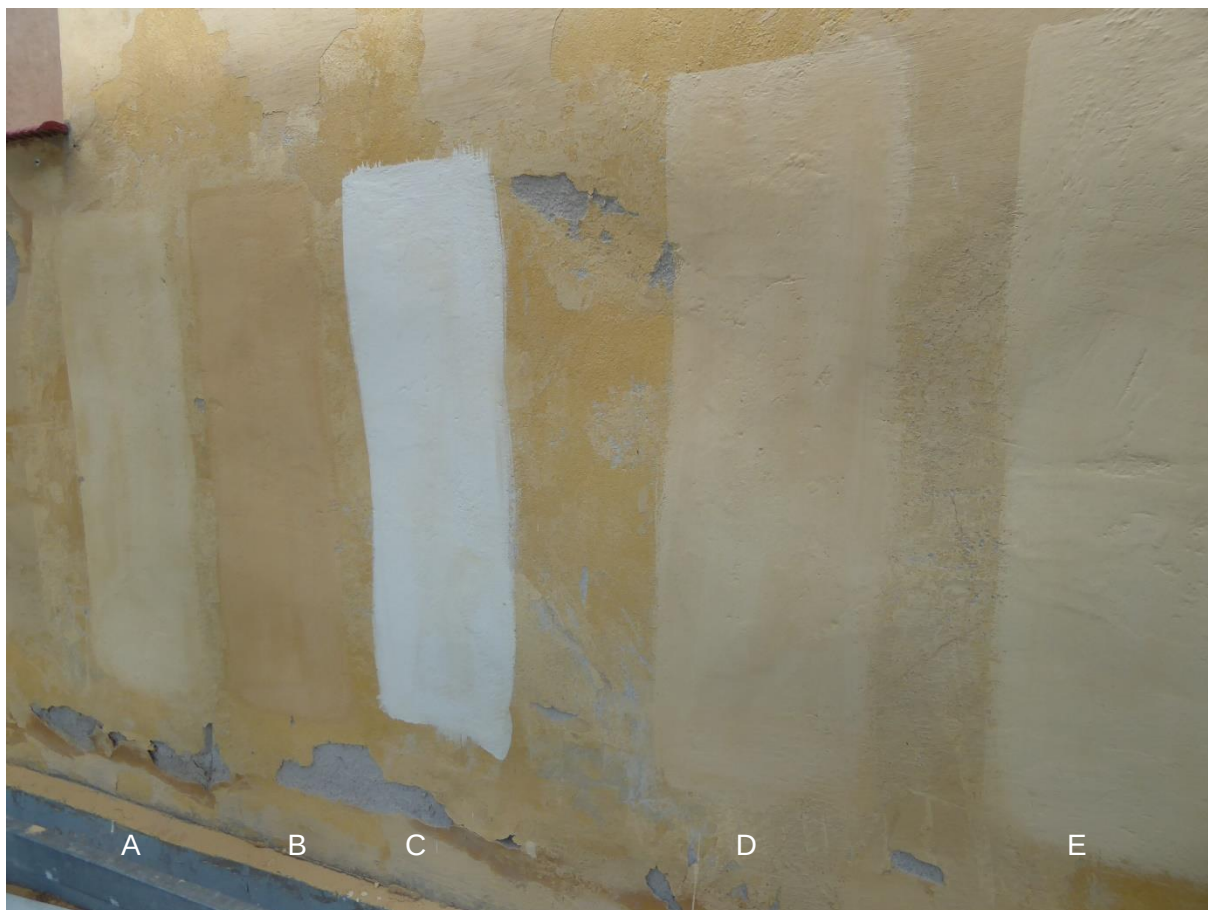
Figur 29 Första uppstrykningsprovet av fasadfärg gult och vitt. Från vänster räknat:
