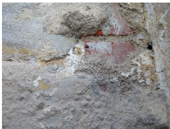
Figur 11. Vänster: Takfotsgesims och listen under trappgavelns blindingar före åtgärderna. Höger: poröst skikt av eventuell stänkrappning samt vita och gula underliggande färgskikt, på trappgavel.
