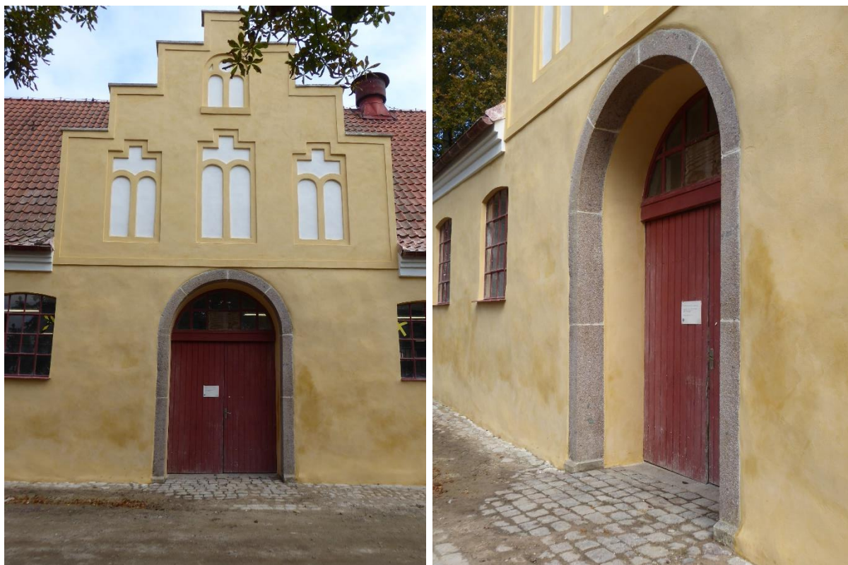
Figur 24. Trappgavel och portomfattning efter åtgärder.
