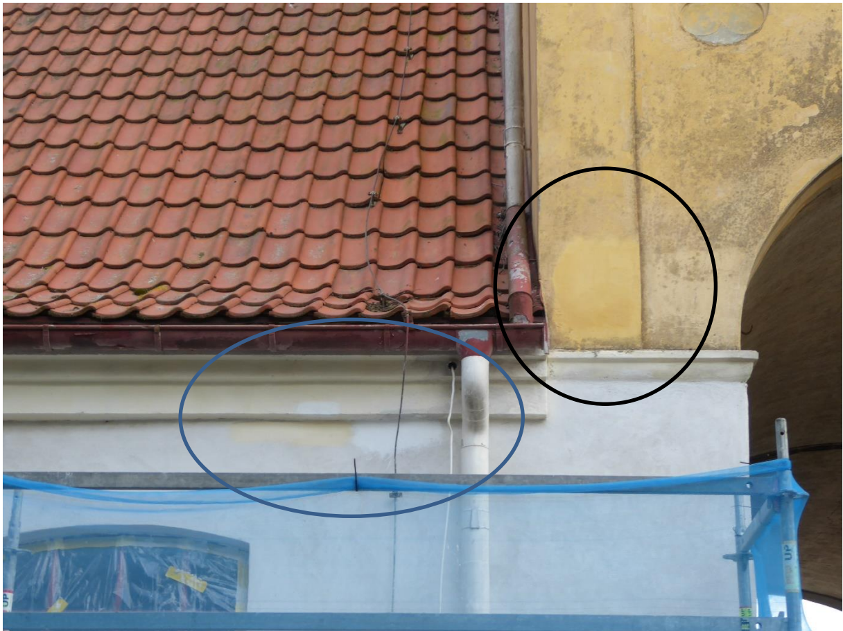
Figur 31. Blå cirkel visar vita uppstrykningsprover. På listen vit linoljefärg. Under listen är vänstra provet färg 4-1 enligt RAÄ:s kalkfärgslikare (vilket användes 1984) och det högra är Kungskalk opigmenterad. Svart cirkel visar samma pigmentering som uppstrykningsprov I men här struken på gammal puts och färg.
