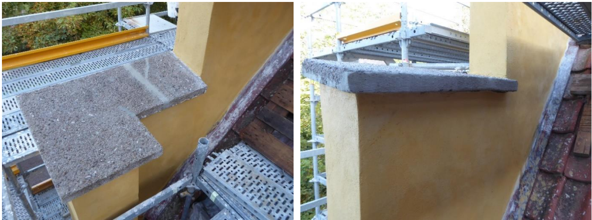
Figur 20. Lagning av täckplattor på trappgaveln.
