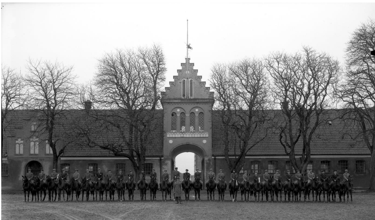
Figur 26. Fotografi daterat 1936. Observera ljusa blindingar i trappgaveln till vänster i bild och att listen under blindingarna har samma färg som fasaden. Naturstenen i portomfattningarna är synlig. Källa: Kulturen Carlotta A2381.(Bildens är beskuren)
