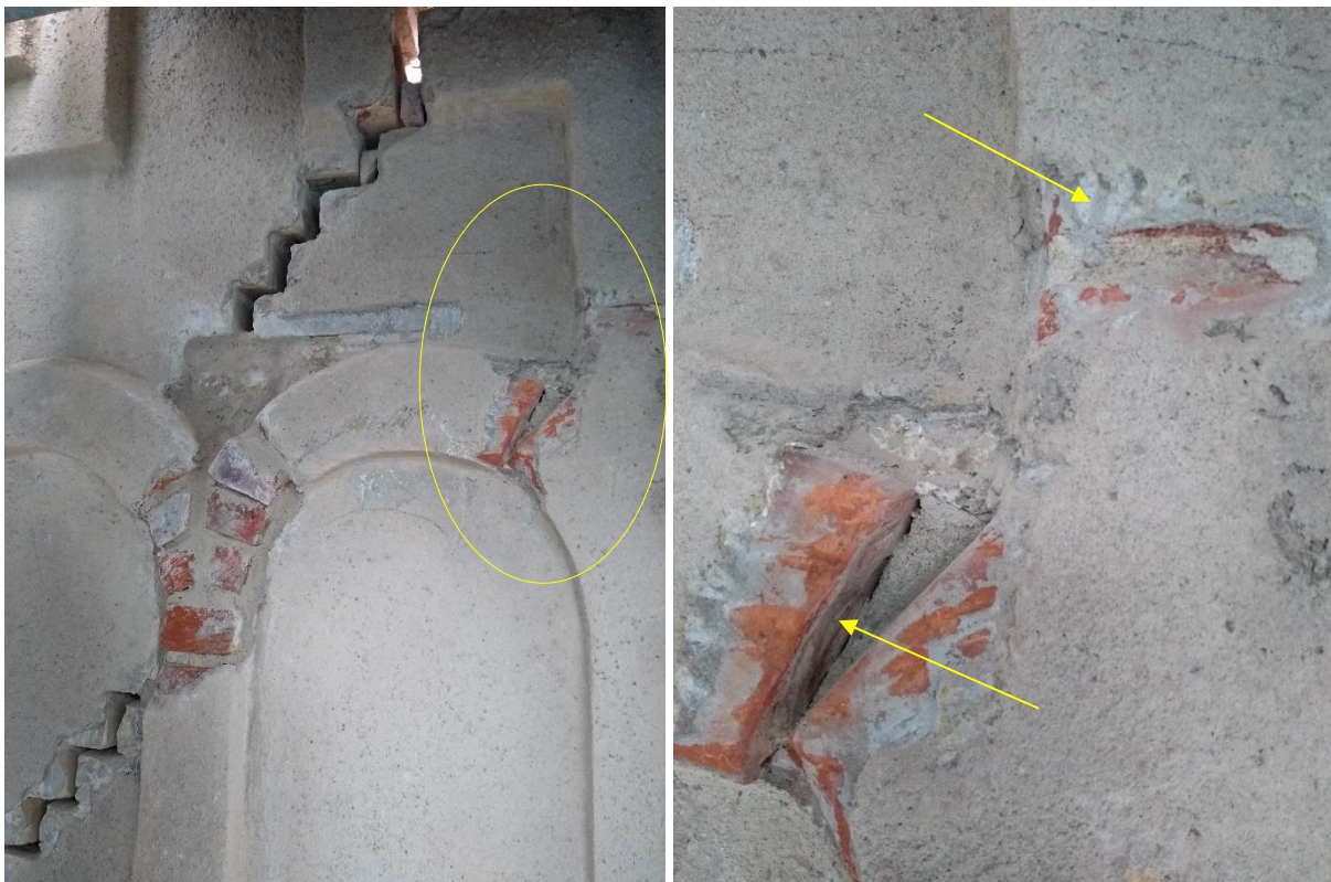
Figur 12. Vänster: Blästrad och rengjord trappgavel. Höger: Blästrad trappgavel och den kraftiga sprickan som var tydlig före åtgärderna har knackats upp.
