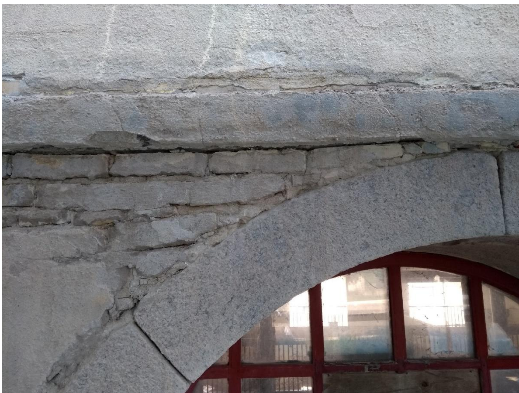
Figur 8. Portomfattningen efter putsnedknackning och rengöring. I fasaden syns en svag sättnings som dock inte påverkat naturstensomfattningen.
