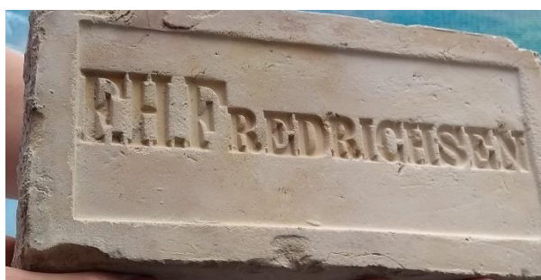
Figur 14. I sprickan i trappgaveln finns gult tegel stämplat F.H Fredrichsen på en sida och Sölyst Nivva på andra sidan. Ett antal stenar murades om.
