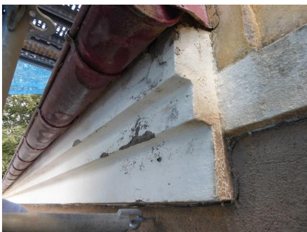
Figur 10. Fasad efter blästring och när sprickor knackats upp.
