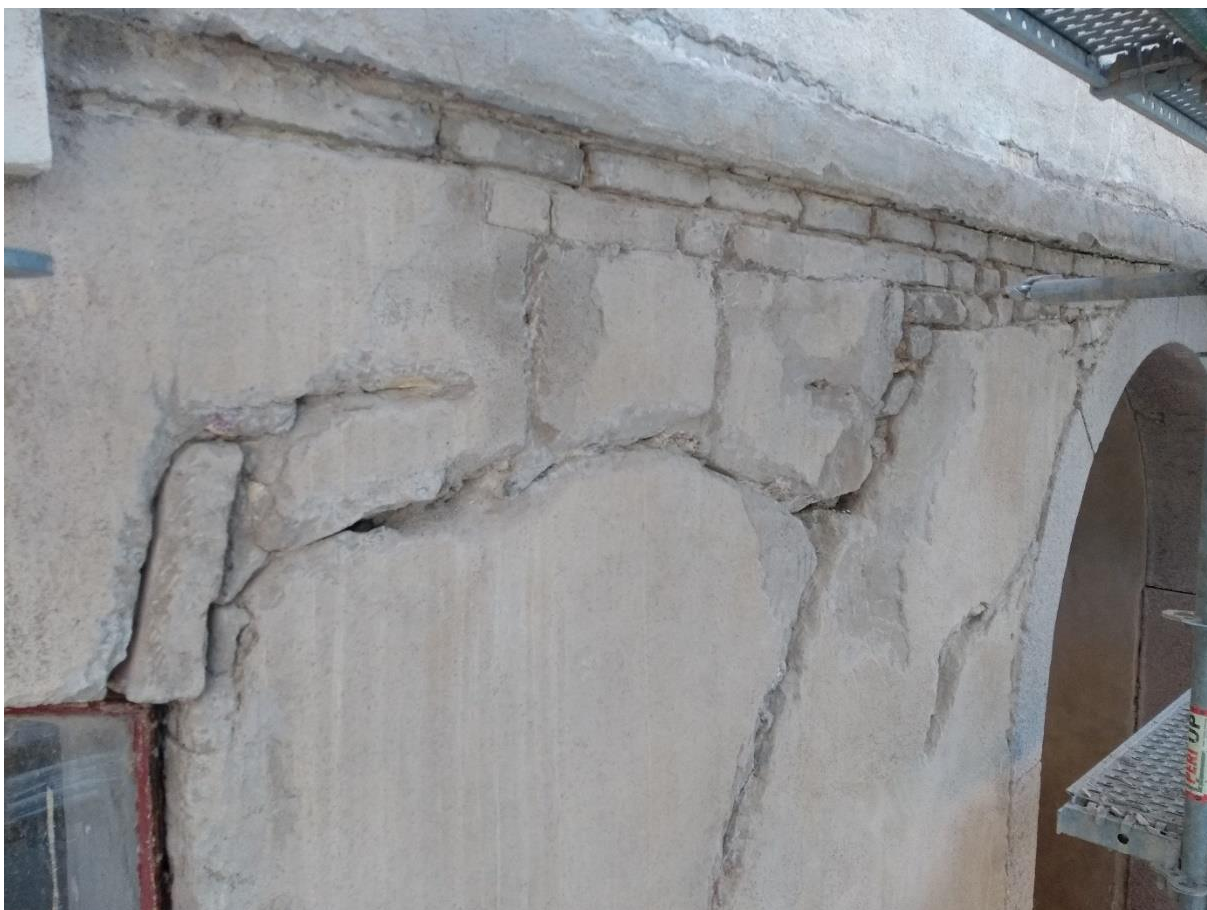
Figur 10. Fasad efter blästring och när sprickor knackats upp.
