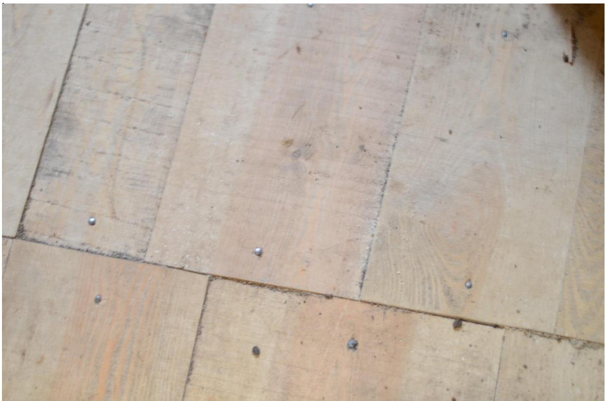
Foton som visar den nya golvbeläggnigen med ramsågad yta.
