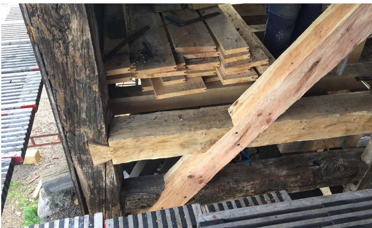
Foto som visar stombjälkens nya förbindning med laxstjört istället för tapp/tapphål mot hörnstolpen och snedstyvnans spikförband mot stombjälken.
