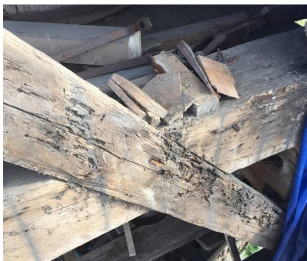
Foton på de befintliga kryssen, med svåra skador av röta och skadeinsekter
