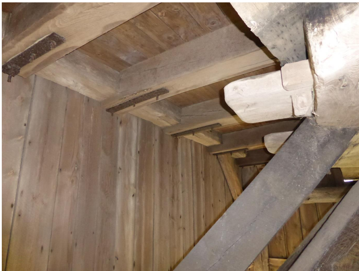
Befintliga bjälkar till broloftet som hade anpassats efter möllans sättningar med hak och stålbeslag.
