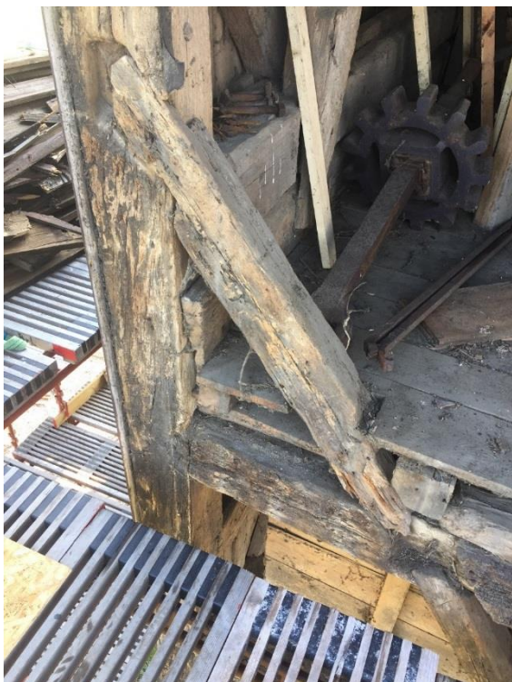
Foton på de befintliga kryssen, med svåra skador av röta och skadeinsekter
