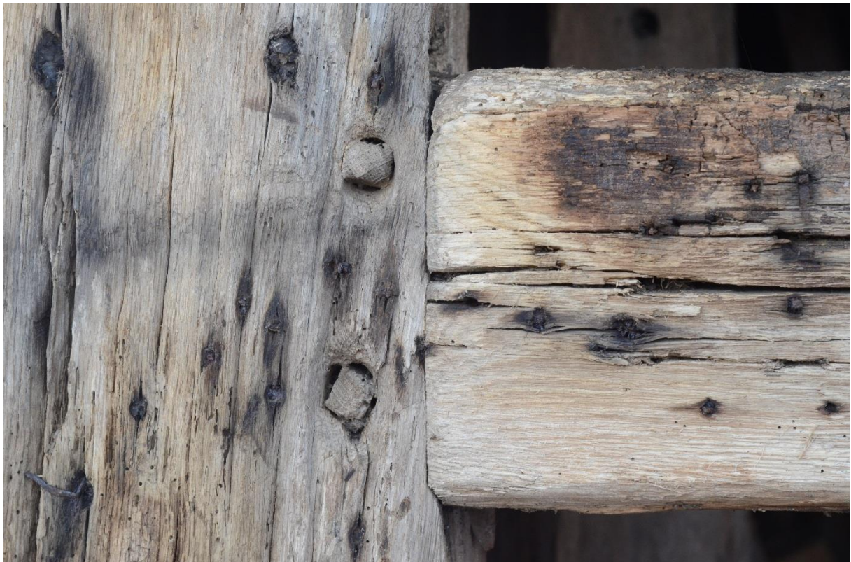
Foto på hörnstolpe och bjälke vid kvarnloft då dessa frilagts från panelbräderna och som visar sammanfogning med tappar och trädubb från utsidan.
