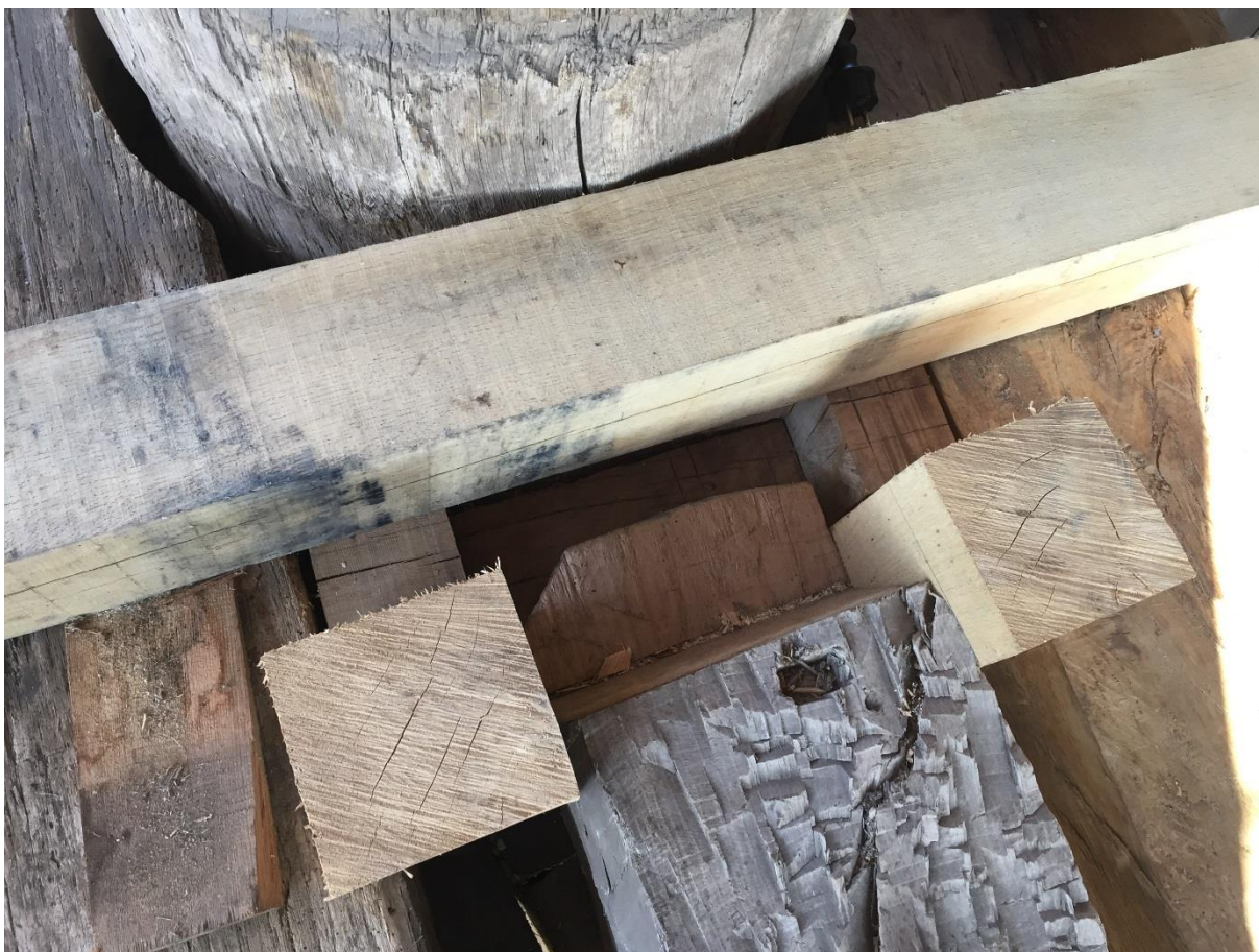
Foto över svansträets (nederst i bild) sammanfogning mot stubben och brostocken.
