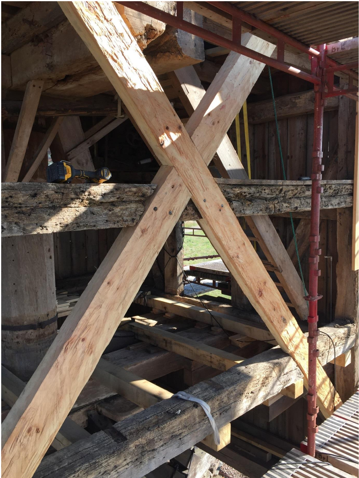
Foto som visar kryssens bearbetade yta.
