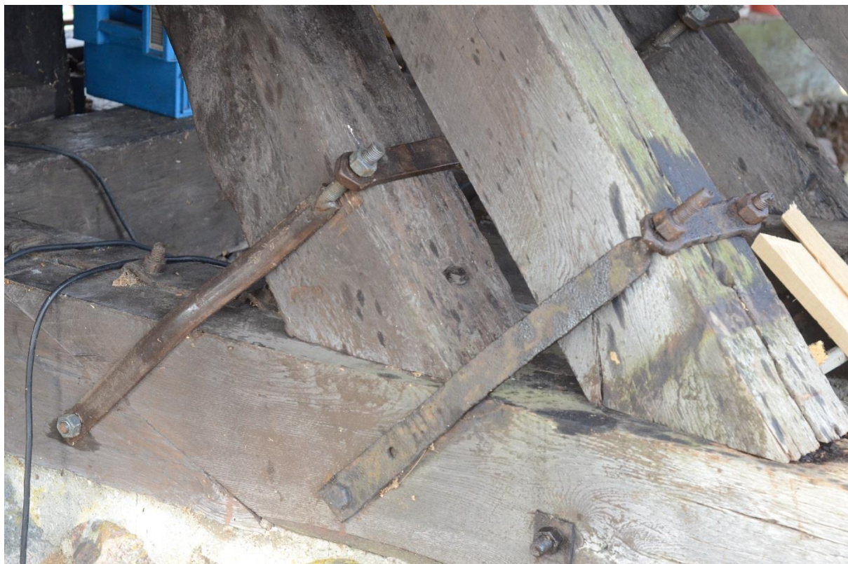
Foto som visar de nya stålhillorna på den inre stivan. Målning var inte utförd då fotot togs.
