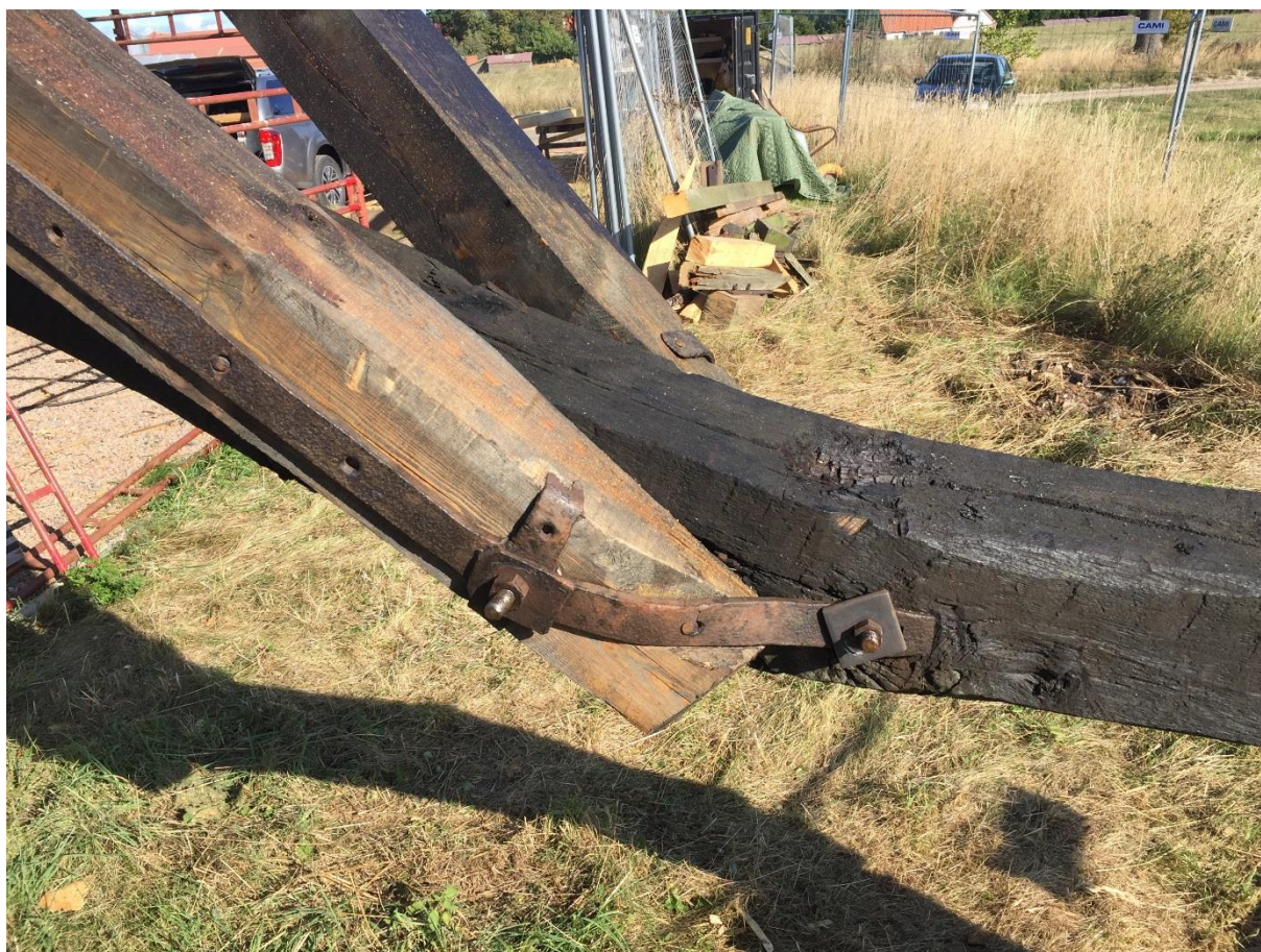
Foto visar sammanfogning mellan svansträ och slanor med de befintliga beslagen.
