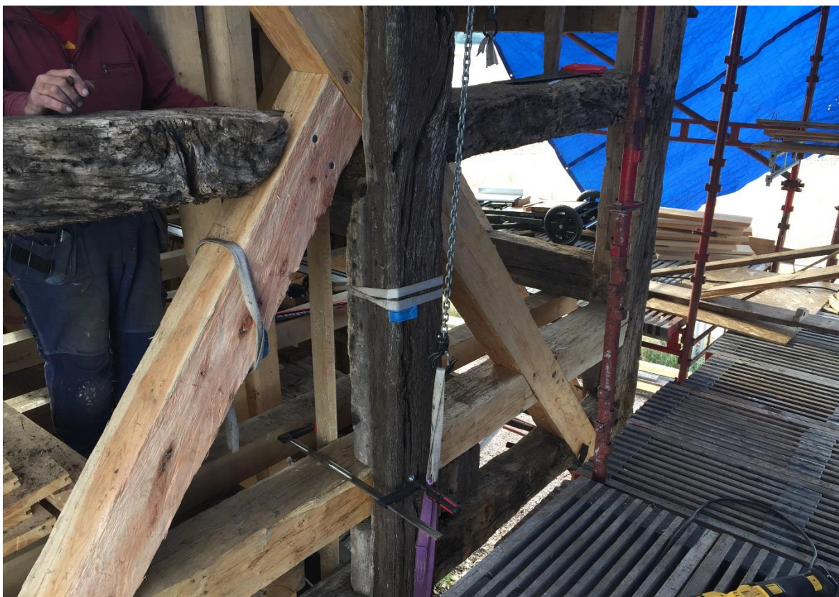
Stombjälken och kryssen ersatta och pannbjälken lyfts åter på plats.
