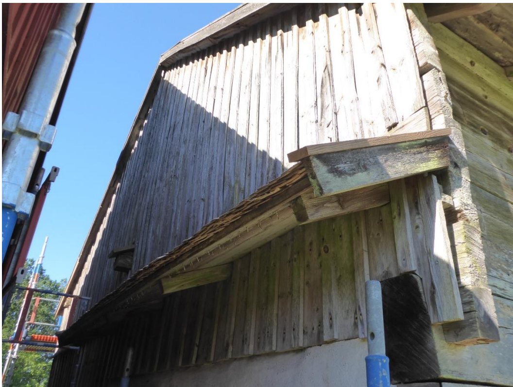
Figur 11. Efter åtgärder. Skärmtaket i gattet.
