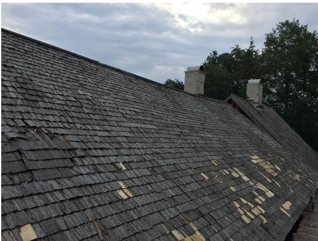
Figur 7. Under arbete, södra takfallet.
