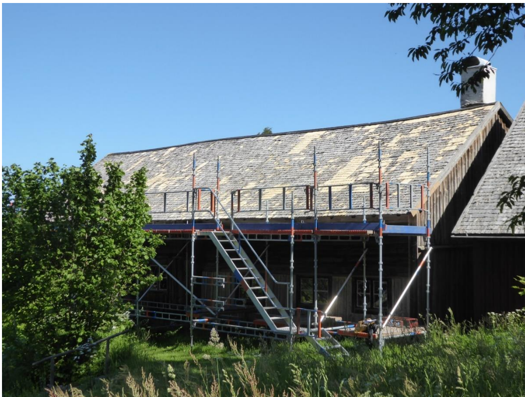
Figur 8. Efter åtgärder. Bostadshusets södra takfall. Lagningar syns som ljusare partier.
