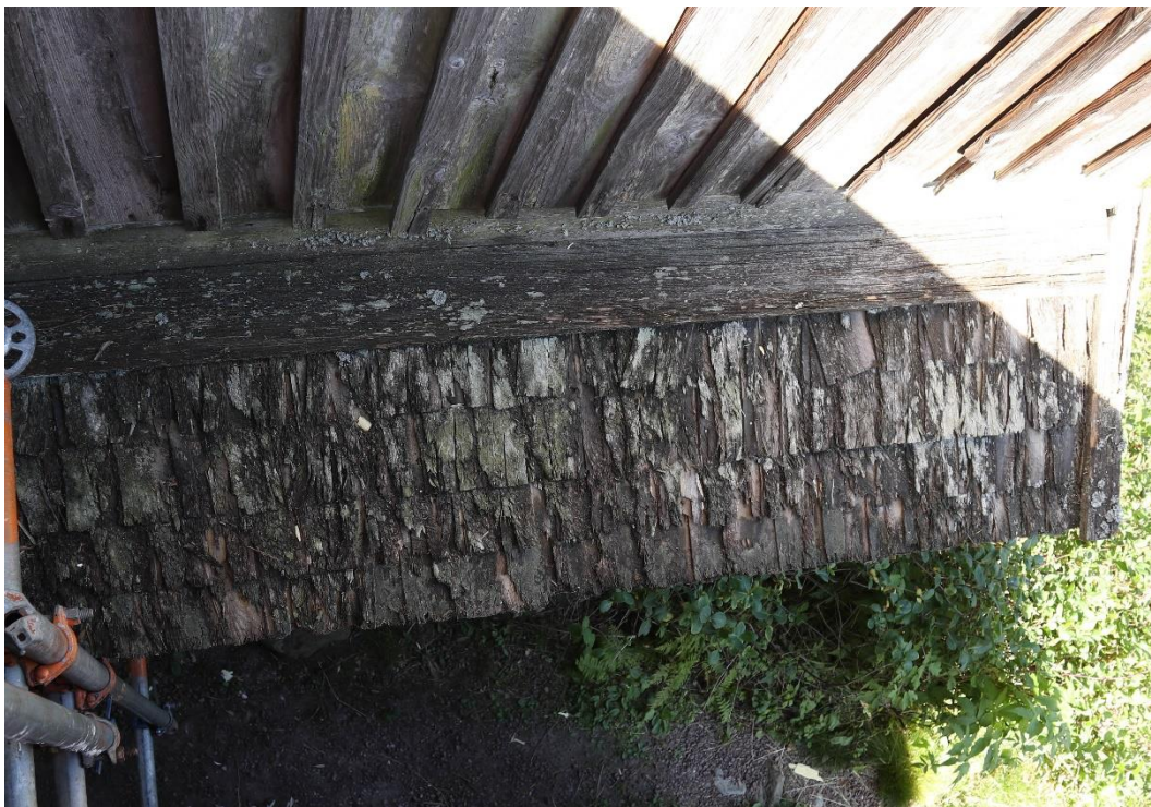
Figur 6. Före åtgärderna, skärmtaket i gattet.
