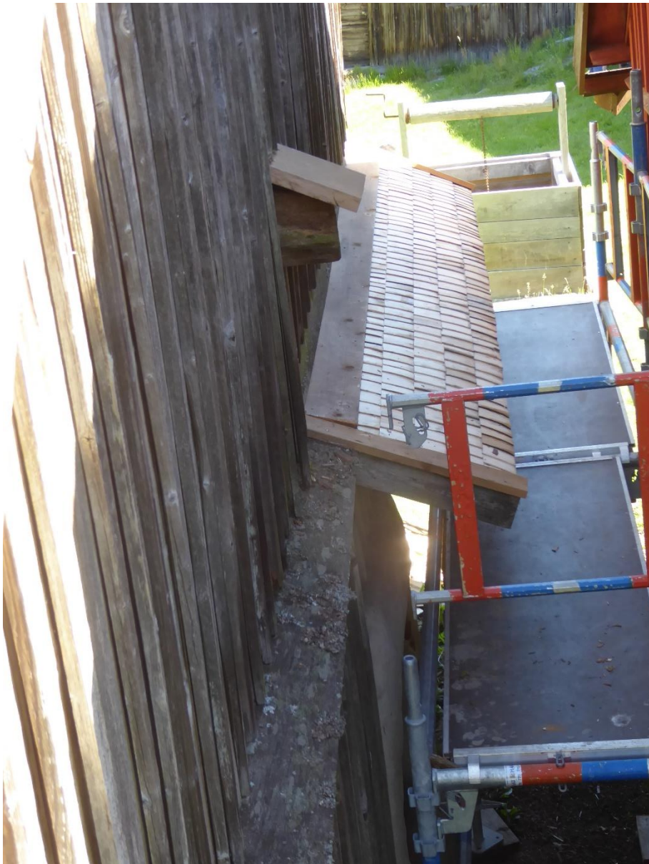
Figur 12. Efter åtgärder. Skärmtaket i gattet.
