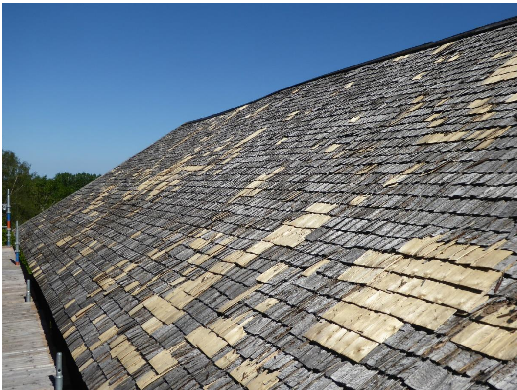
Figur 10. Efter åtgärder, södra takfallet på bostadshuset.
