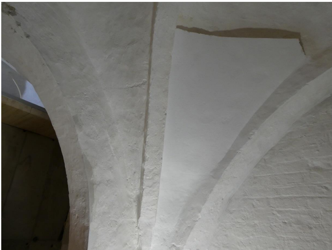
Mellersta valvet södra sidan, provyta akustikputs som behandlats för att ge putsstruktur i ytan.
