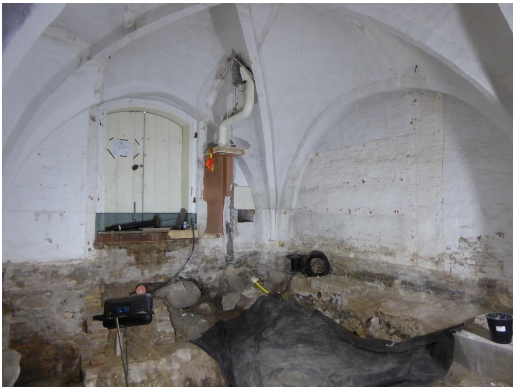
Östra valvet efter utrivning av äldre wc-paket, på platsen för den nya våtrumsenheten.
