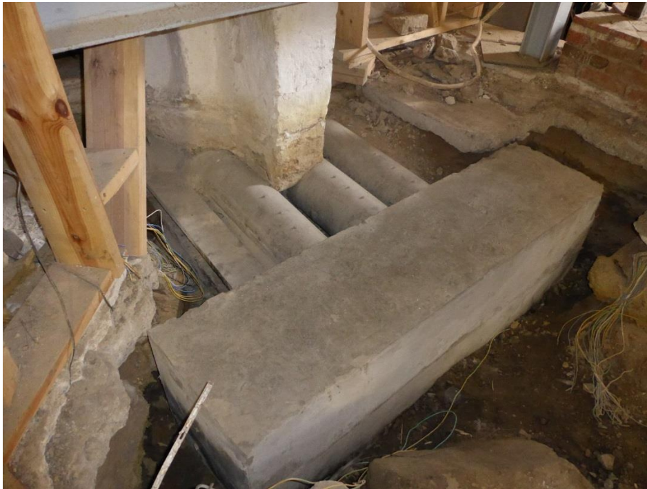
Den grundförstärkning som gjordes i östra valvet med borrning från nedsänkt teknikutrymme norr om Liberiet. Denna konstruktion döljs nu av gjutet betonggolv klätt med kvadratisk tegel.
