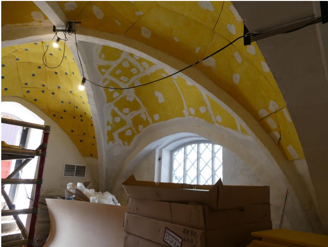
Västliga valvet akustikskivor monterade, inför putsning.
