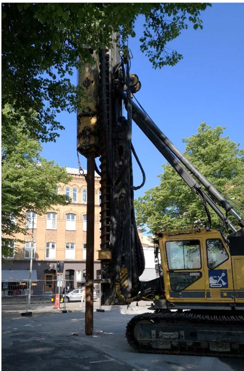
Figur 5. En massiv järnpåle med diameter omkring 350 mm användes inledningsvis för att banka igenom de första 2 m för att bereda väg för skruvborren genom asfalt och bärlager. Fotografi taget från öster.
