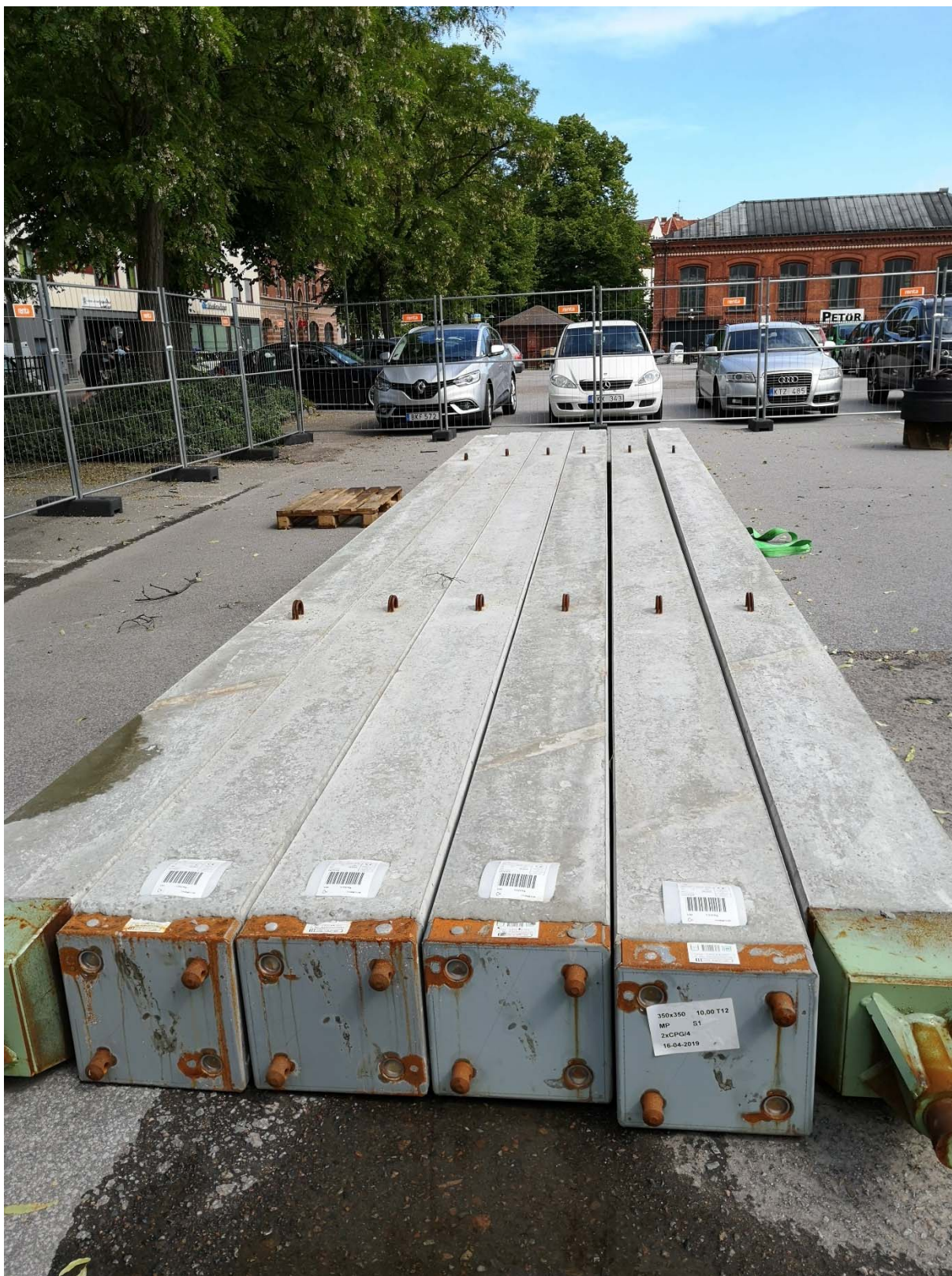
Figur 8. Pålar med dimensionen 350×350 mm bankades ned i det runda skruvhålet. Vid kontrollräkning krävdes mer än 600 slag/pållängd.
