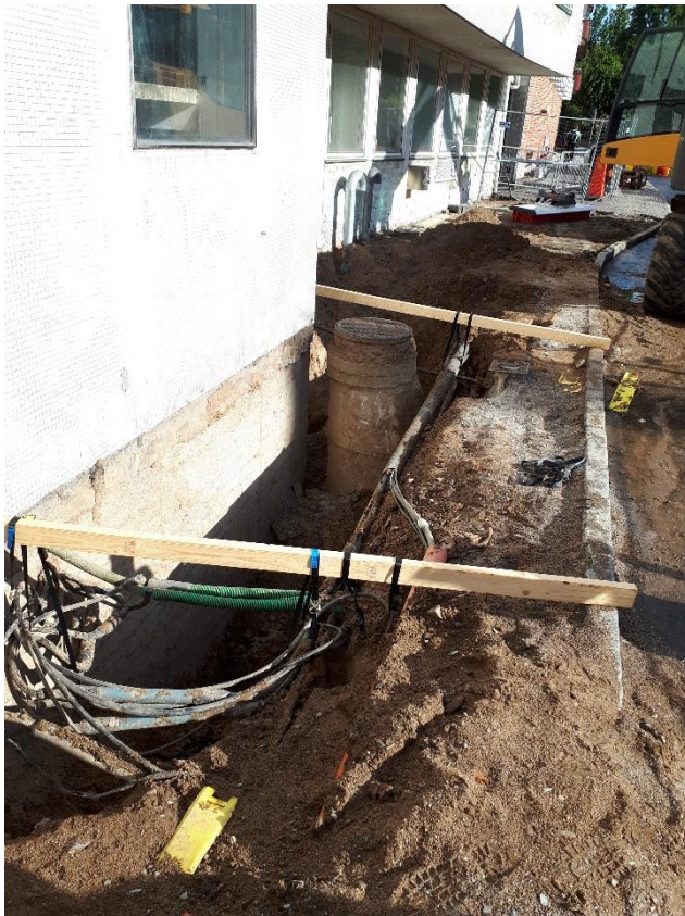
Figur 3. Översiktsbild över schaktet med fyllnadsmassor. Fotot taget från söder.
