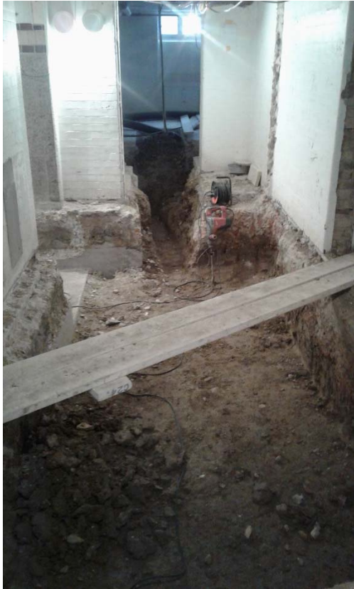
Figur 6. Del av källarschaktet, Schakt 8.
