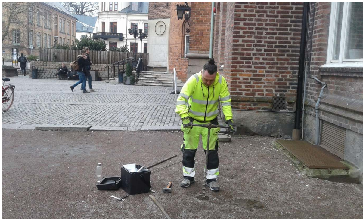
Figur 3. Då alla utom ett av borrhöven gjordes inomhus i trånga källarutrymmen så skedde borrhöven för hand. Detta begränsade borrhöjpet. Vid borrhöv 5, som gjordes utomhus, begränsades djupet till cirka 0,50 m. Fotografiet taget från söder.
