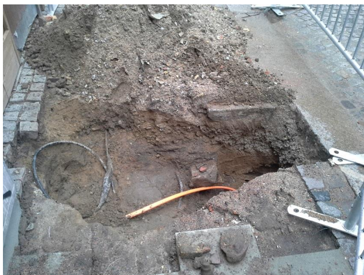
Figur 4. Översiktsbild över schaktet, fotot taget från norr. Uppkastade kulturlagermassor syns längs upp i bilden.
