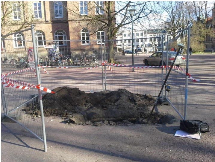
Figur 6. Schakt nr 6 sett från väster, i bakgrunden ses AF-borgen och Kulturens huvudbyggnad.
