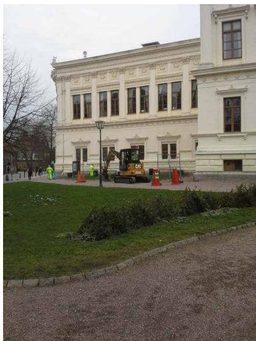
Figur 8. Arbetet med schakt 10 påbörjas. Foto taget från sydost.
