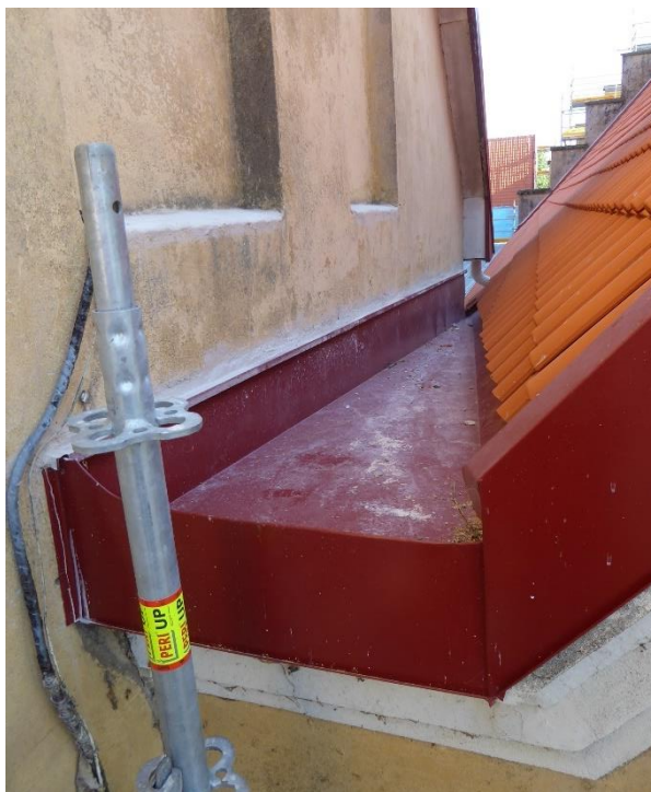
Före och efter åtgärder rännedal möte i norr respektive söder. Plåtens droppkant är kopierad som en liten uppvikt ränna och infästning mot fasad är förbättrad.
