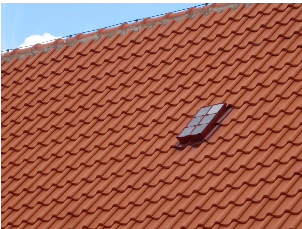
Efter åtgärder, exempel på fönster på kommenderingsstallen.
