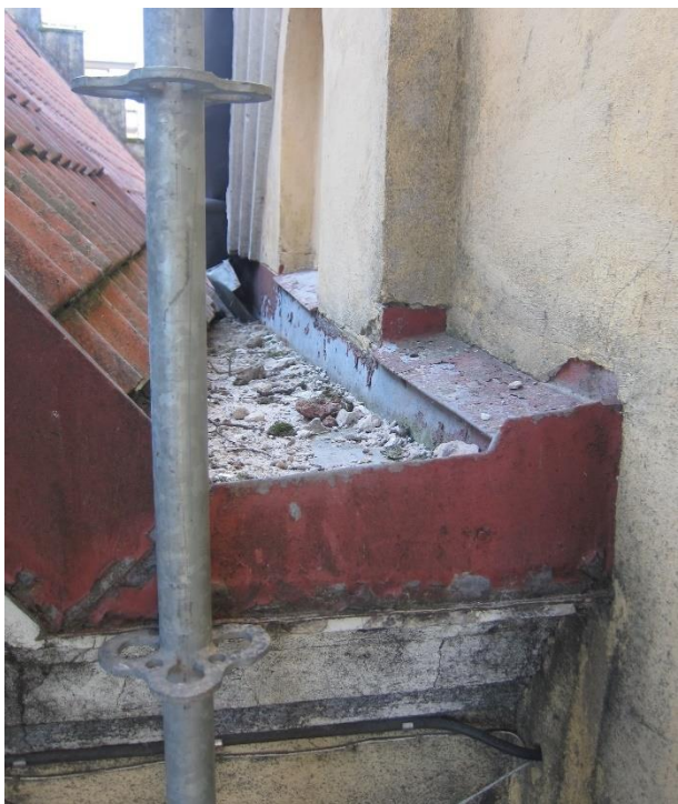
Före och efter åtgärder rännedal möte i norr respektive söder. Plåtens droppkant är kopierad som en liten uppvikt ränna och infästning mot fasad är förbättrad.
