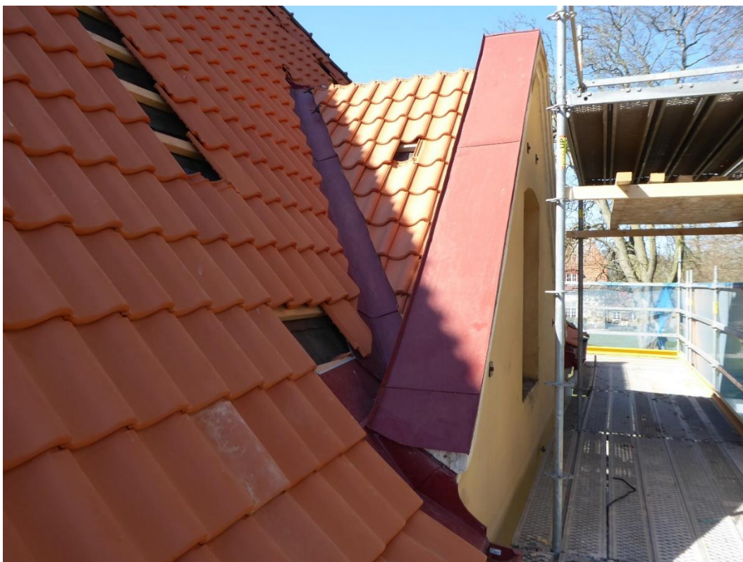
Frontespis med nya plåtarbeten och brickor (syns i putsfältet) som förstärkning för muren.
