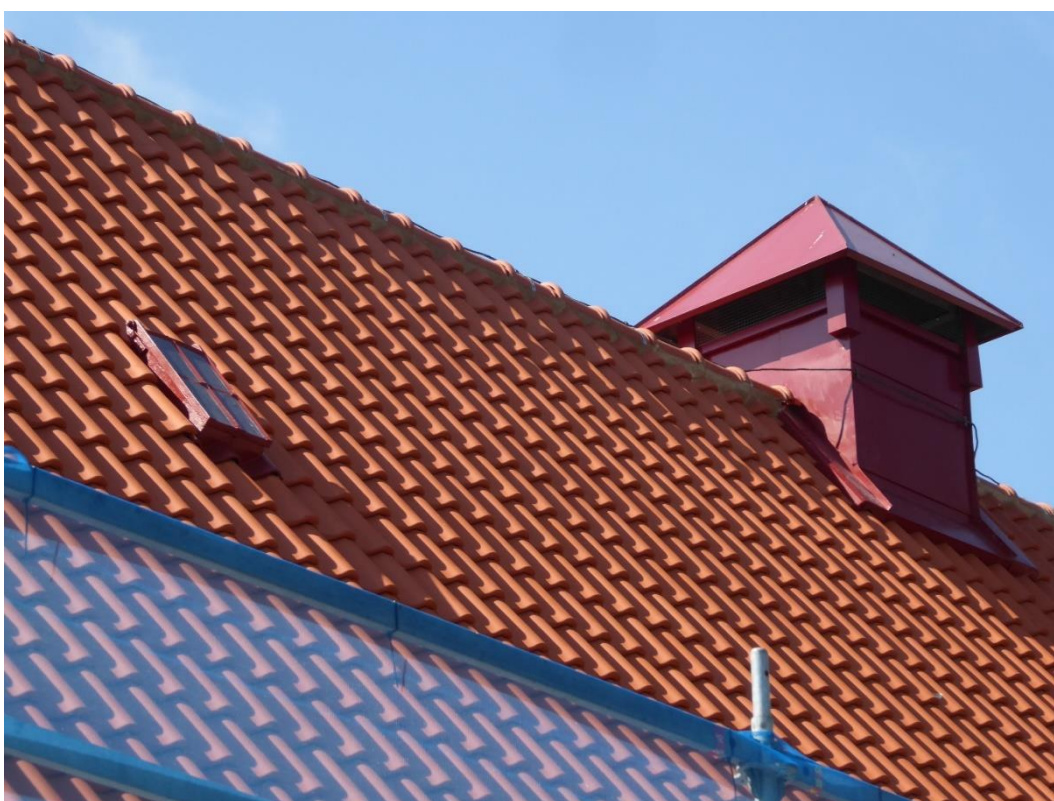
Ventilationshuv före och efter åtgärder. Samtnock och takfönster.
