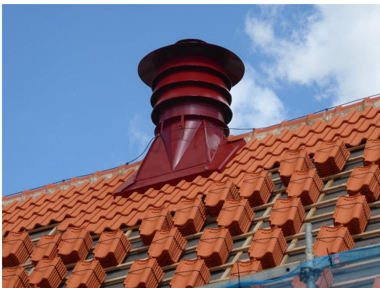
Ventilationshuv före åtgärder, under arbete och efter åtgärder.
