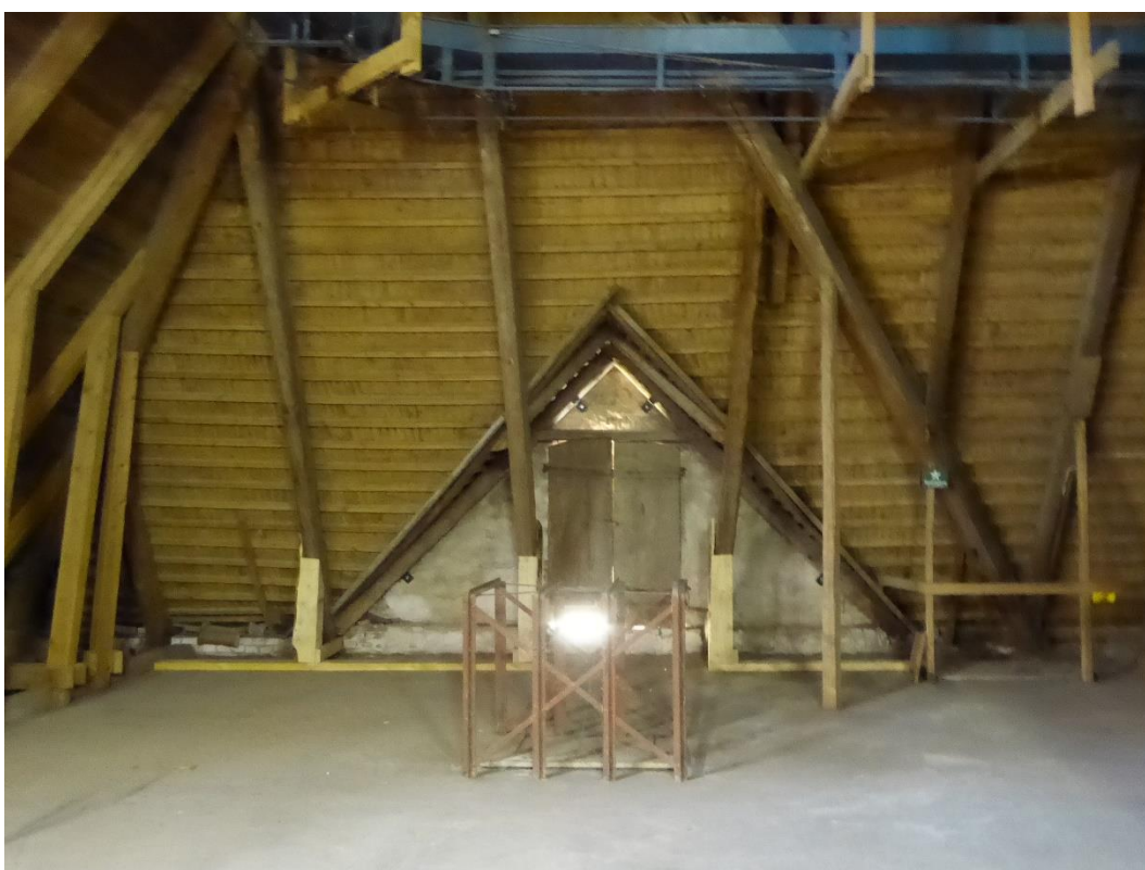
Före och efter åtgärder. Vinden vid frontespisen Norra unghäststallets nordvästra hörn. Kompletterat med nya stödben till taksparrar.
