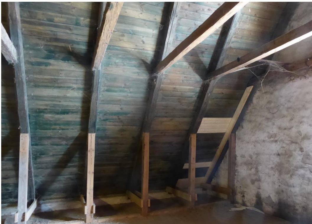
Lagning av undertak syns som ljusare fält till höger i bild samt förstärkning av taksparren längst till höger i bild. Norra kommenderingsstallets sydöstra hörn.
