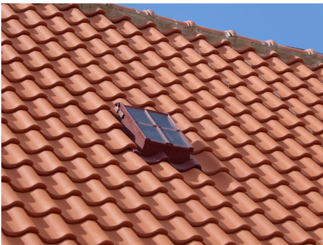
Efter åtgärder, exempel på fönster på Norra unghäststallet.
