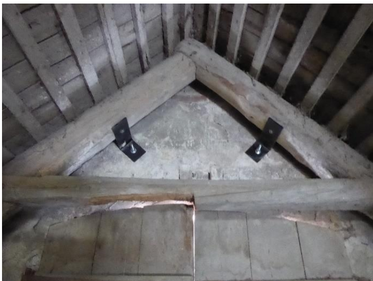
Vinden vid frontespisen Norra unghäststallets nordvästra hörn. Kompletterat med järn för stabilisering av frontespisens mur.
