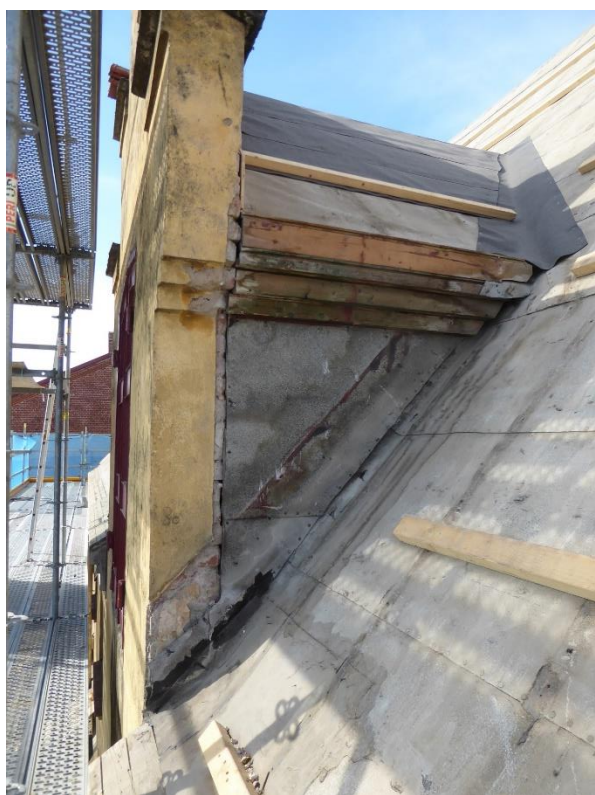
Före åtgärder och under arbete. Plåtinklädd sida på frontespis mot öster samt uppbbyggnad i trä och med pappklädnad.
