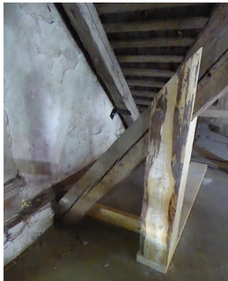
Vinden vid frontespisen Norra unghäststallets nordvästra hörn. Kompletterat med järn för stabilisering av frontespisens mur.
