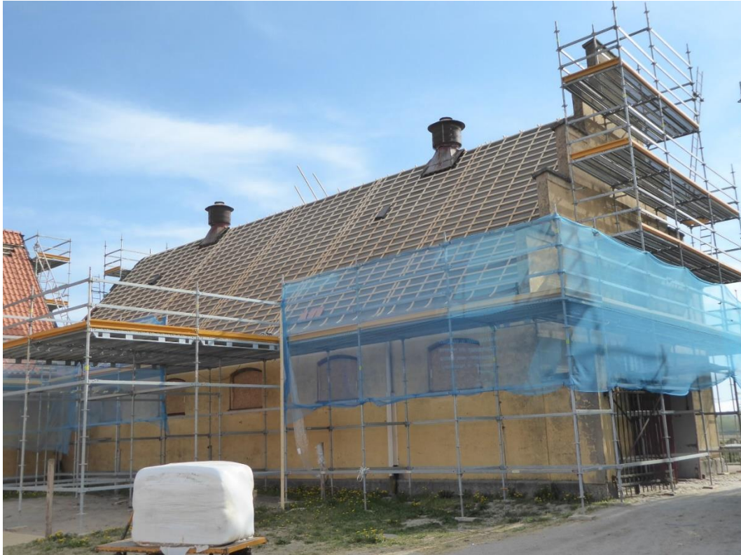
Under arbete Norra kommenderingsstallet västra takfallet.
