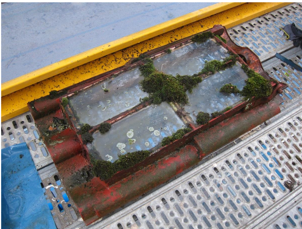
Före åtgärder, exempel på takfönster på Norra unghäststallet.
