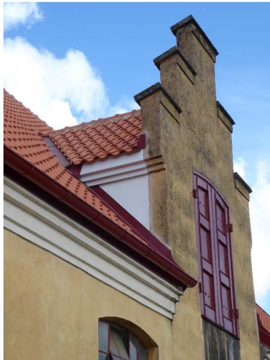
Vänster. Före åtgärder. Kommenderingsstallen, frontespis med lucka mot öster. Höger. Efter åtgärder med ny plåt på frontespis och bleck under porten.
