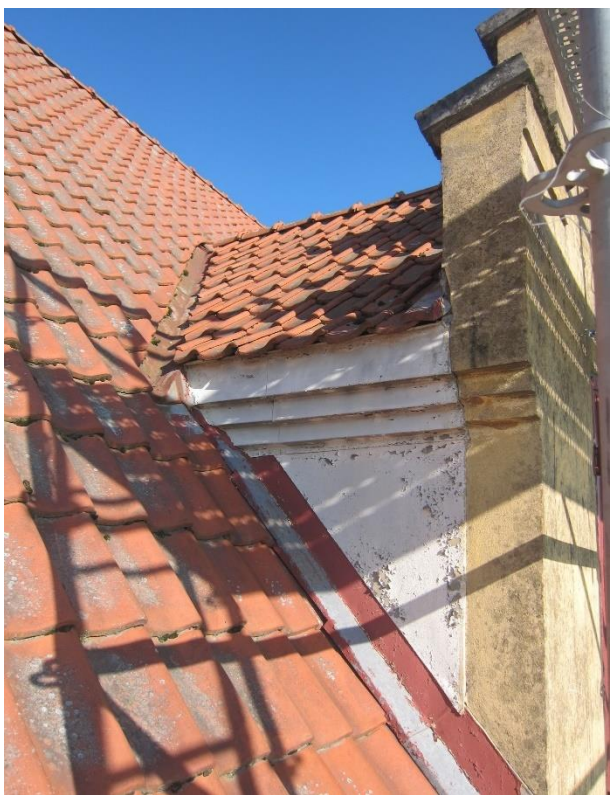
Före åtgärder och under arbete. Plåtinklädd sida på frontespis mot öster samt uppbbyggnad i trä och med pappklädnad.
