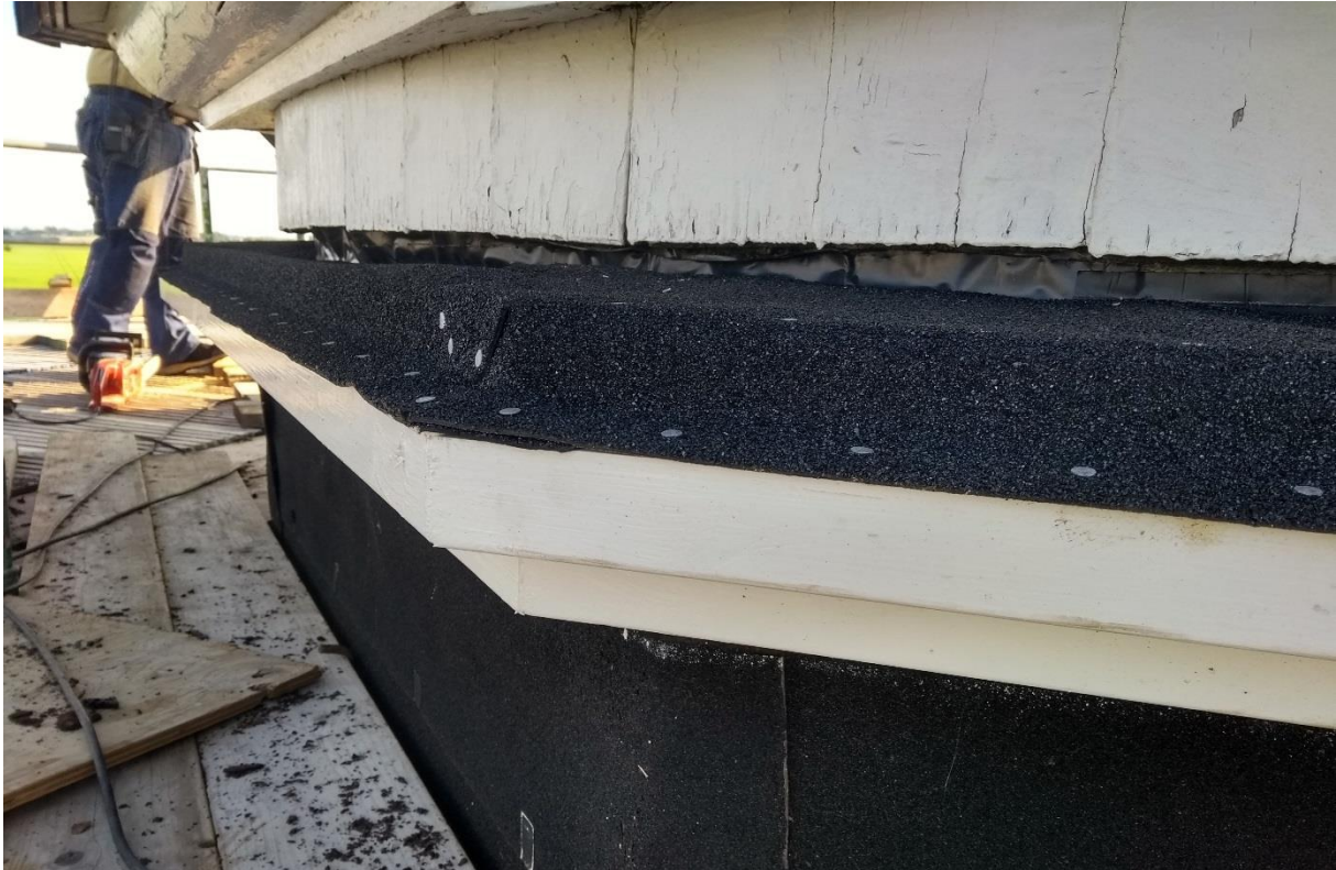
Gesimsen monterad och inklädd med asfaltsmatta på ovansidan.
