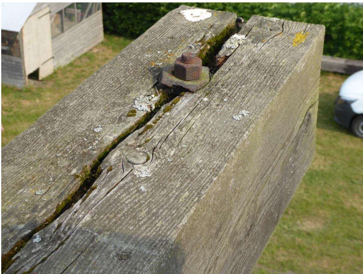
Bakre utstickaren med rötskador utefter märgsprickan.
