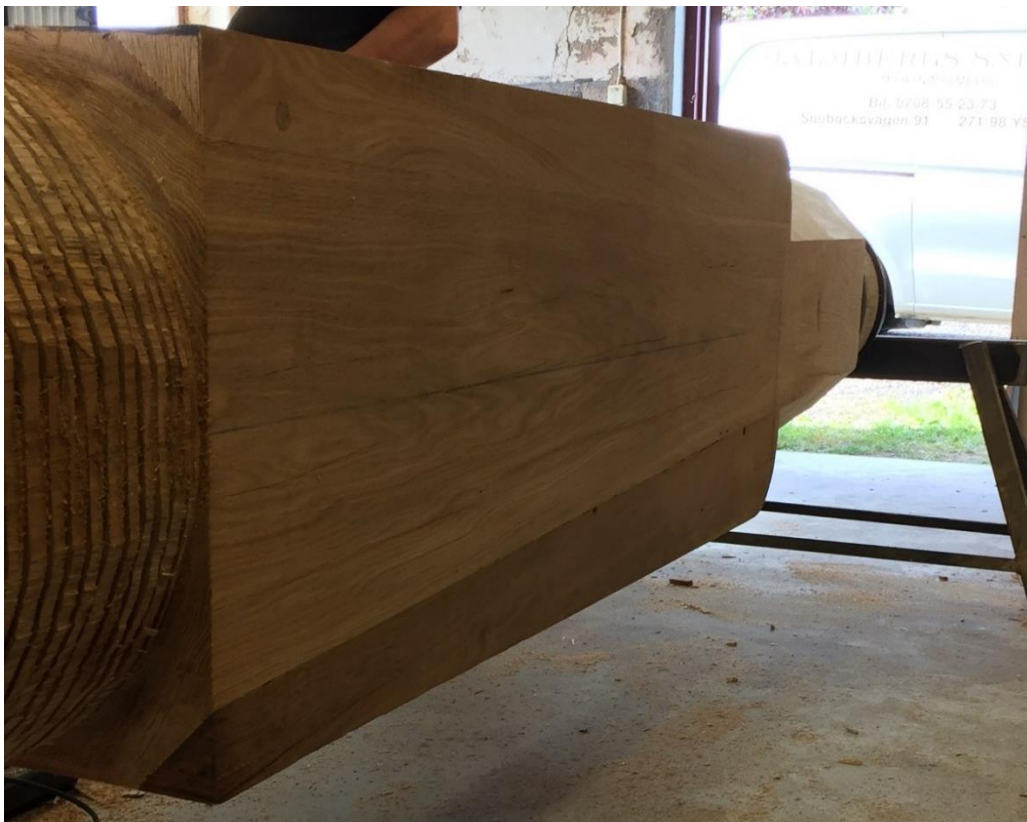
Hålet för vingaxeln som borrats ut från ovan- och undersida. Till vänster har ytan bearbetats med stämjärn och oscillerande sågblad.
