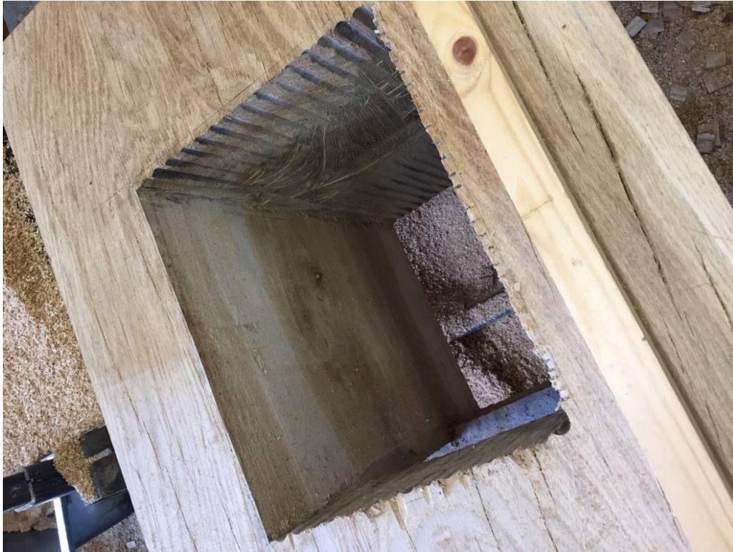
Hålet för vingaxeln som borrats ut från ovan- och undersida. Till vänster har ytan bearbetats med stämjärn och oscillerande sågblad.
