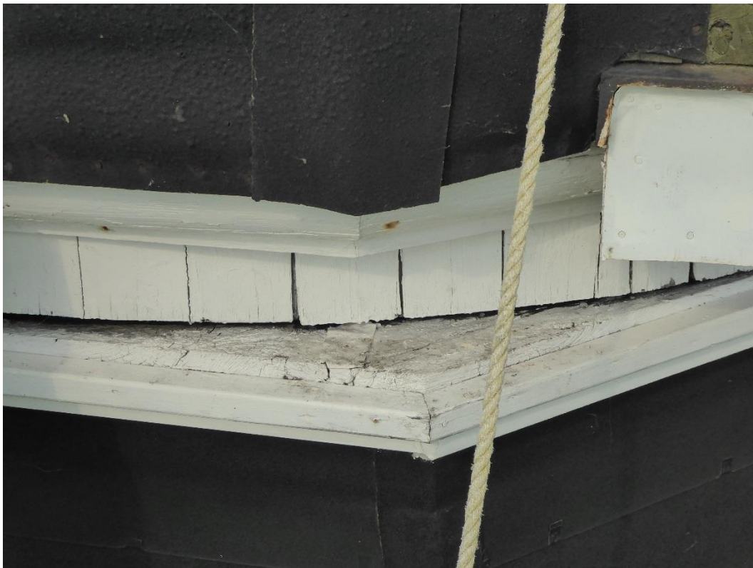
Befintlig gesims med den vitmålade ovansidan av bockryggsplankan och den påspikade trälisten och plåten nedanför.
