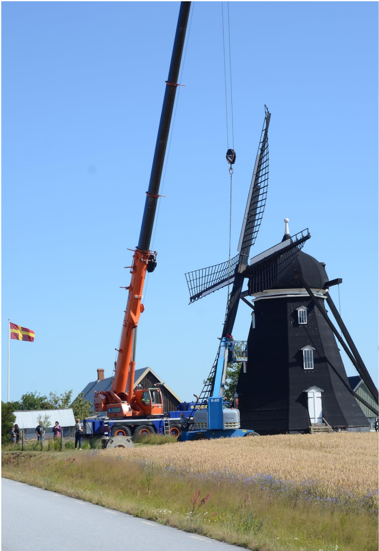
Skegrie mölla med vingarna återmonterade och arbetet färdigställt.
