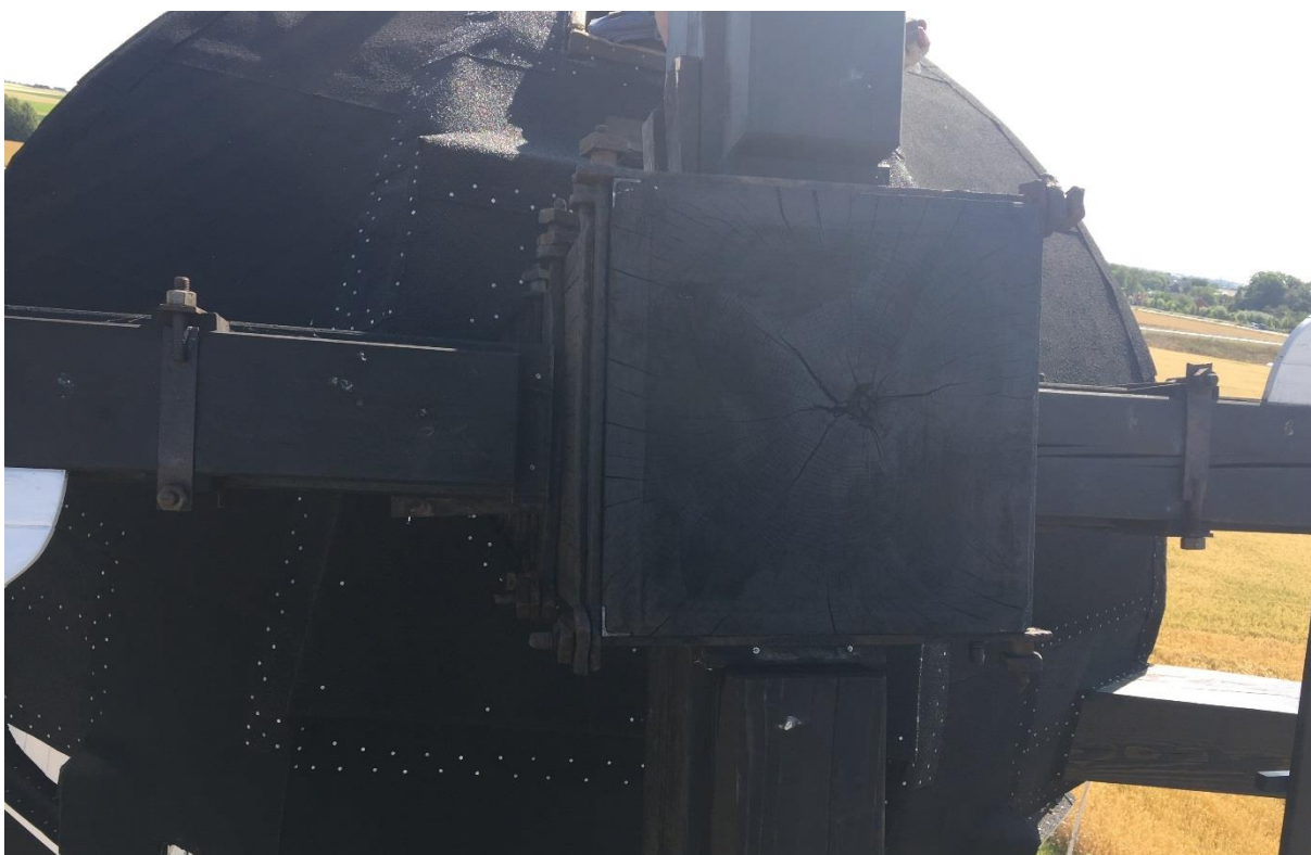
De nya utstickarna monterade och håltagningen lagad med ny asfaltsmatta.
