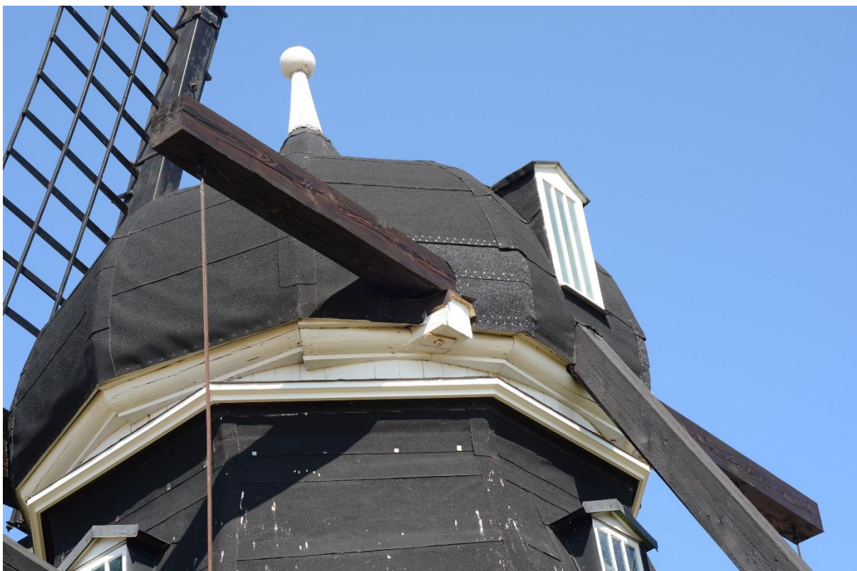
De nya utstickarna monterade och håltagningen lagad med ny asfaltsmatta.
