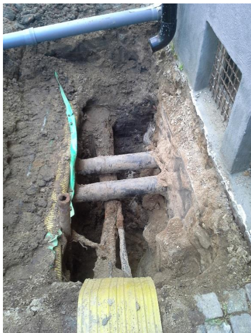
Figur 2. Schaktet sett från söder. Västra halvan grävdes inte ned ytterligare på grund av servisen som inte fick flyttas. Längst ned i bild ses den gula täckplasten som lagts över elledningarna i nord-sydlig riktning.
