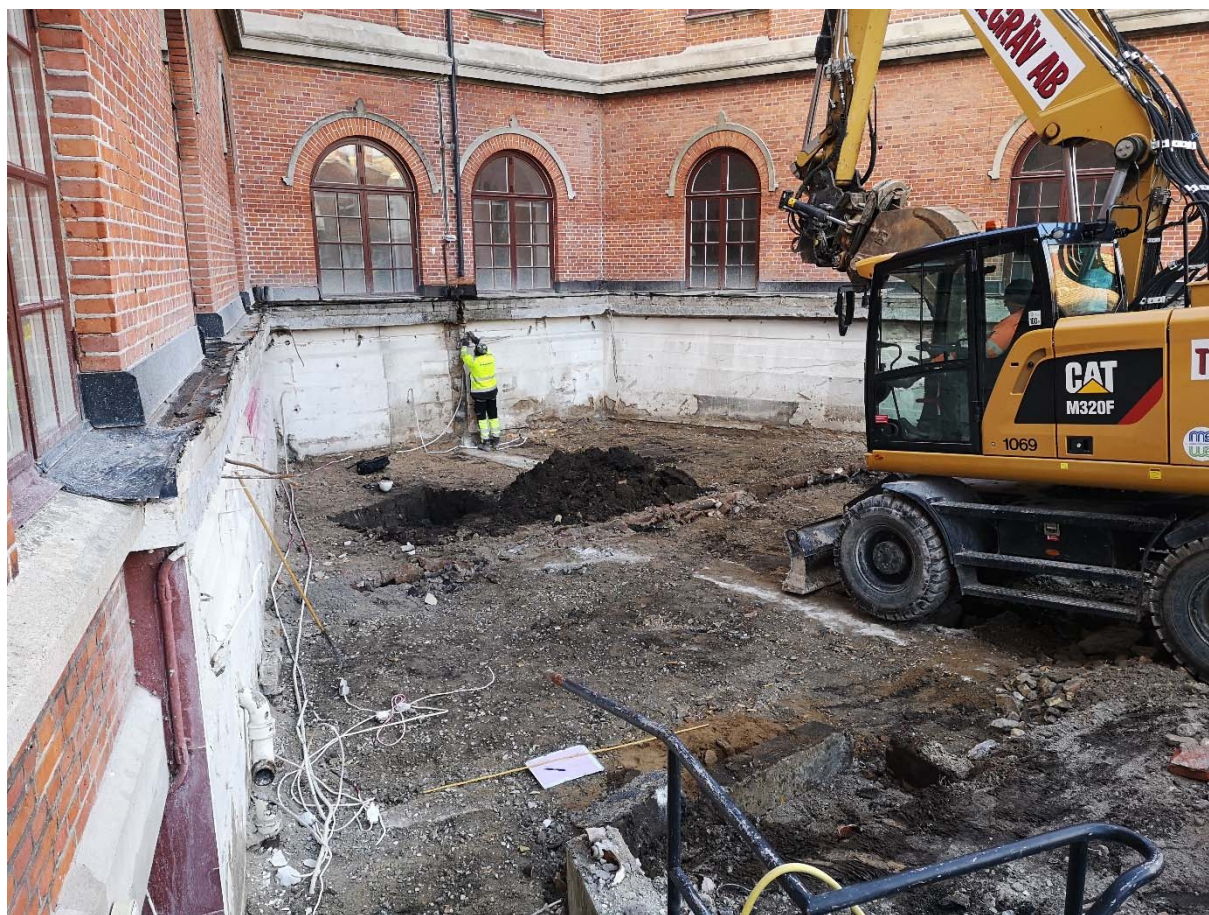
Figur 8. Vy över ytan efter rivning av skyddsrummet. Ett kompletterande förundersökningsschakt upptogs i den sydöstra ytan för att kontrollera kulturlagermäktigheten. Fotografi taget från norr.
